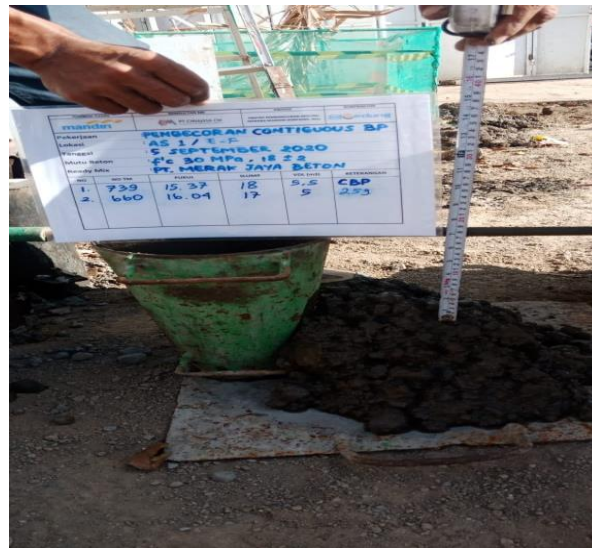
Gambar 39 Pengukuran Nilai Slump (Sumber Foto Lapangan)
