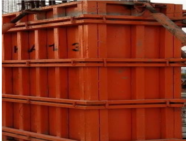
Gambar 75 Bekisting RW (Sumber Foto Lapangan)
