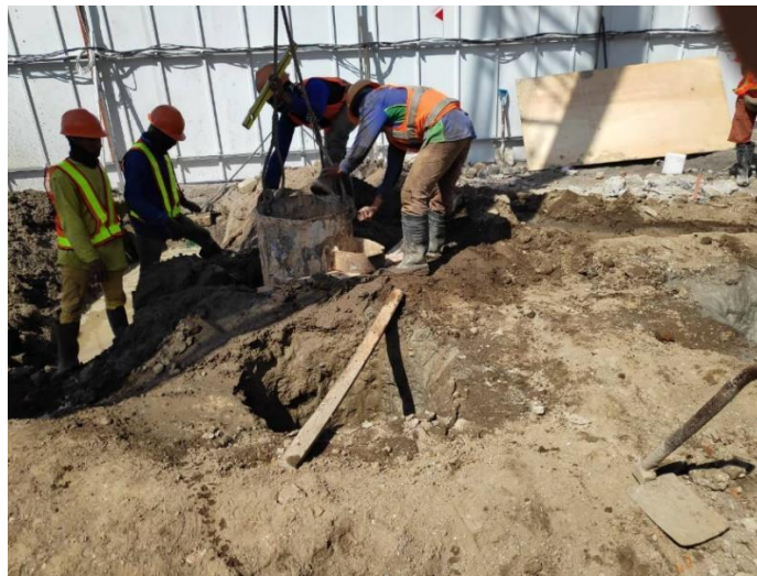
Gambar 33 Pemasukan Casing ke lubang CBP (Sumber Foto Lapangan)
