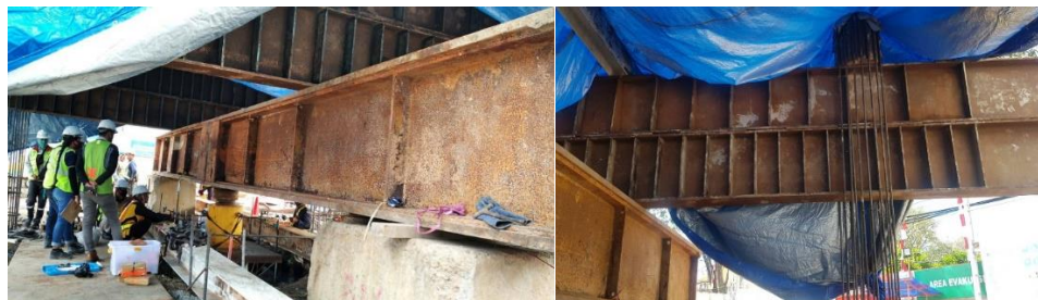
Gambar 96 Pemasangan Beam dan Main Beam (Sumber Foto Lapangan)
