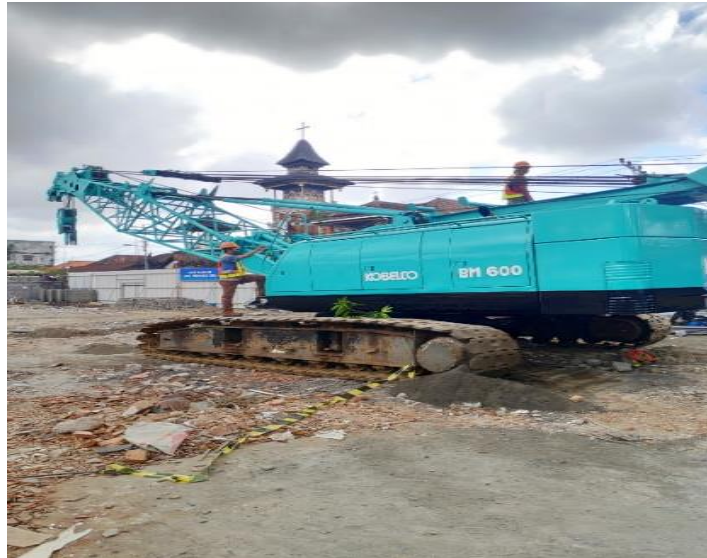
Gambar 50 Settingout Alat (Sumber Foto Lapangan)
