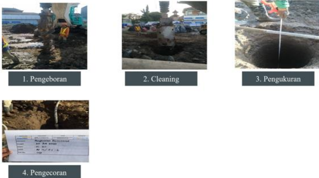
Gambar 126 Dokumentasi Pekerjaan Bentonite (Sumber Foto Lapangan)
