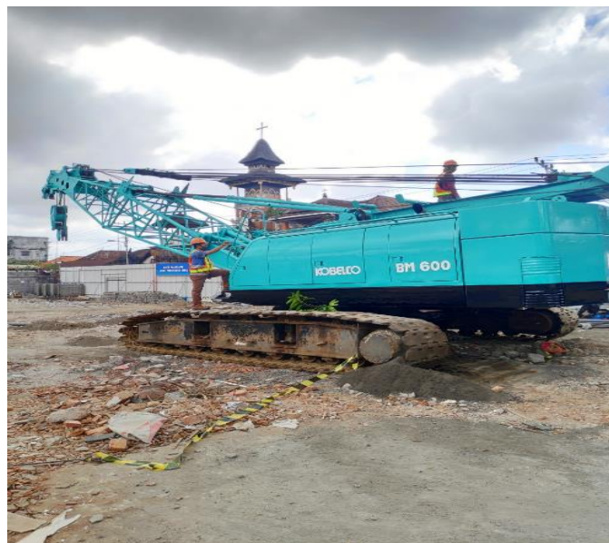
Gambar 26 Settingout Alat (Sumber Foto Lapangan)
