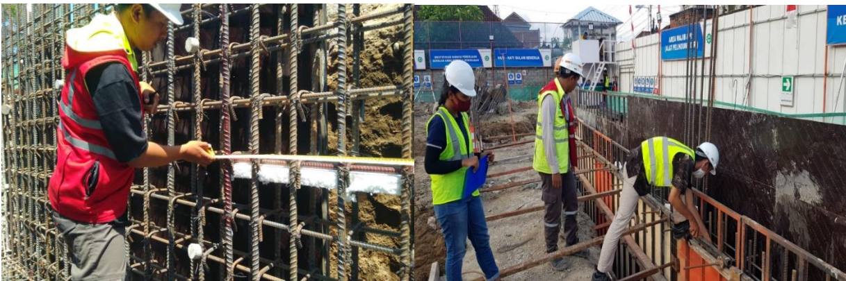
Gambar 81 Pengecekan Retaining Wall oleh QC (Sumber Foto Lapangan)
