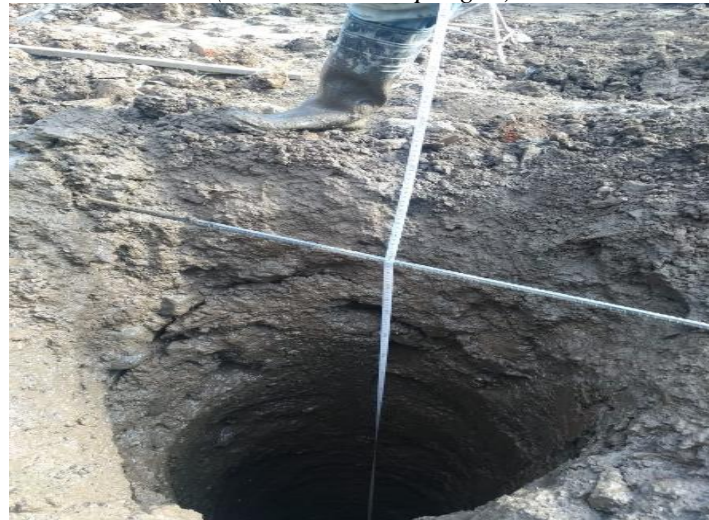
Gambar 54 Pengukuran kedalaman Bentonite Pile (Sumber Foto Lapangan)
