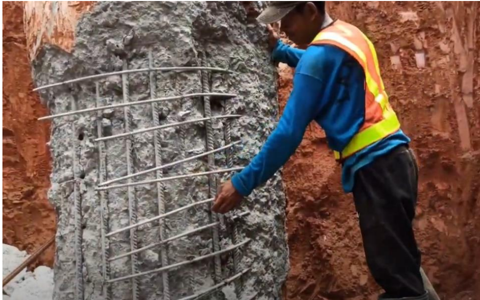
Gambar 65 Pembobokan Bored Pile (Sumber Foto Lapangan)
