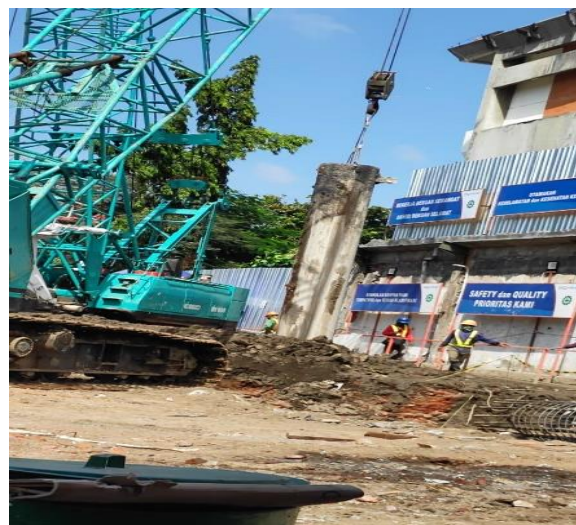
Gambar 42 Pelepasan Pipa Tremi dan Casing (Sumber Foto Lapangan)
