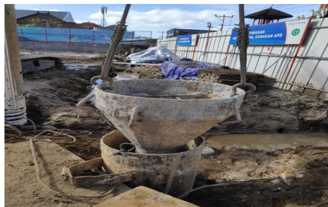
Gambar 23 Pipa Tremi (Sumber Foto Lapangan)
