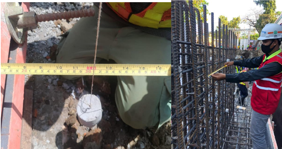
Gambar 67 Pengecekan Capping Beam oleh QC (Sumber Foto Lapangan)
