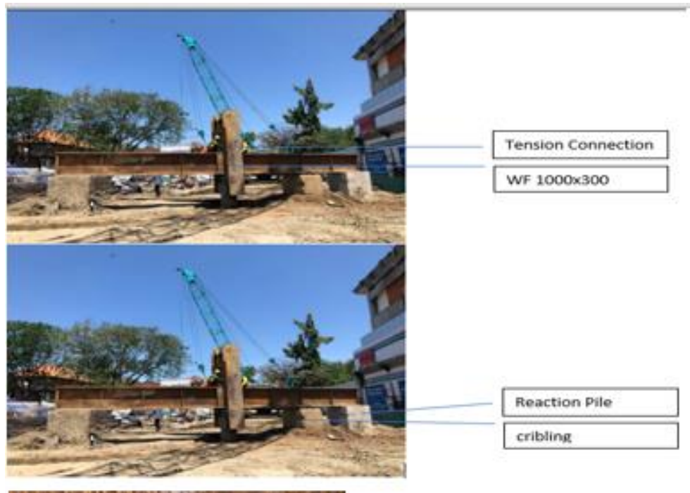
Gambar 116 Pemasangan Beam dan Main Beam (Sumber Foto Lapangan)
