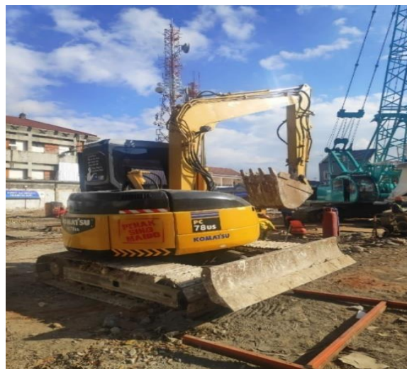
Gambar 8 Pekerjaan Pengurugan Tanah Dengan Menggunakan Alat Excavator (Sumber Foto Lapangan)
