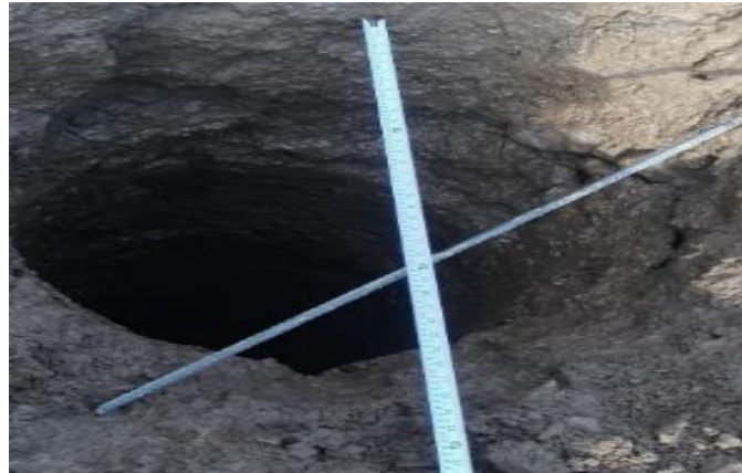
Gambar 53 Pengukuran Diameter Bentonite Pile (Sumber Foto Lapangan)
