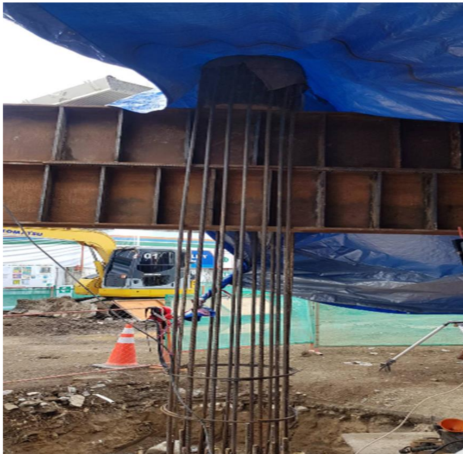
Gambar 97 Penyambungan Casing dengan Support Pile (Sumber Foto Lapangan)
