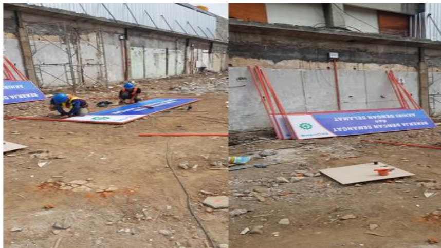
Gambar 9 Pekerjaan Pemasangan K3 (Sumber Foto Lapangan)
