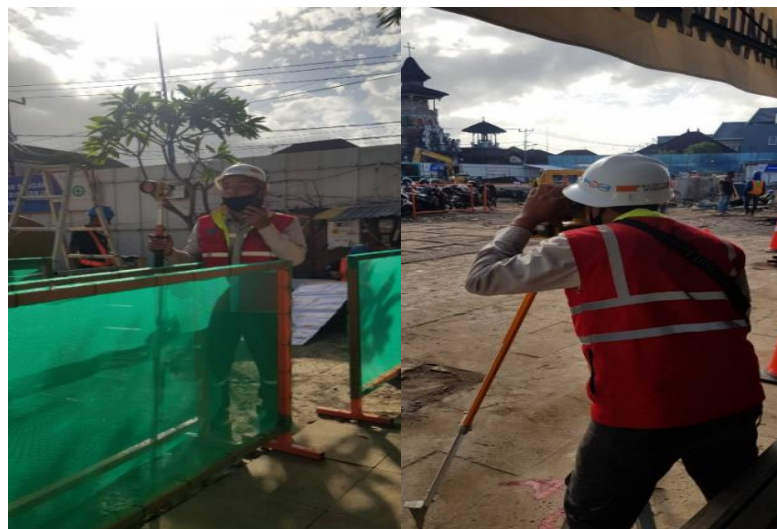
Gambar 16 Pembidikan Koordinat Yang Ditentukan Dengan Total Station (Sumber Foto Lapangan)
