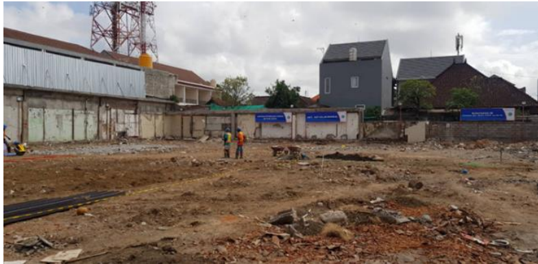
Gambar 7 Kegiatan Pembersihan Lahan di Proyek Gedung Mandiri Denpasar (Sumber Foto Lapangan)
