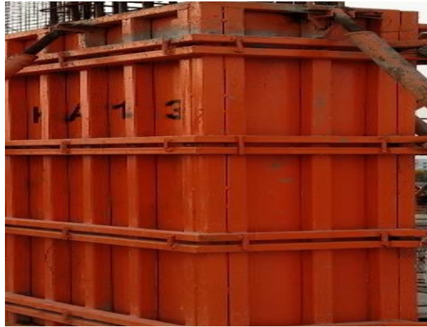
Gambar 62 Bekisting (Sumber Foto Lapangan)
