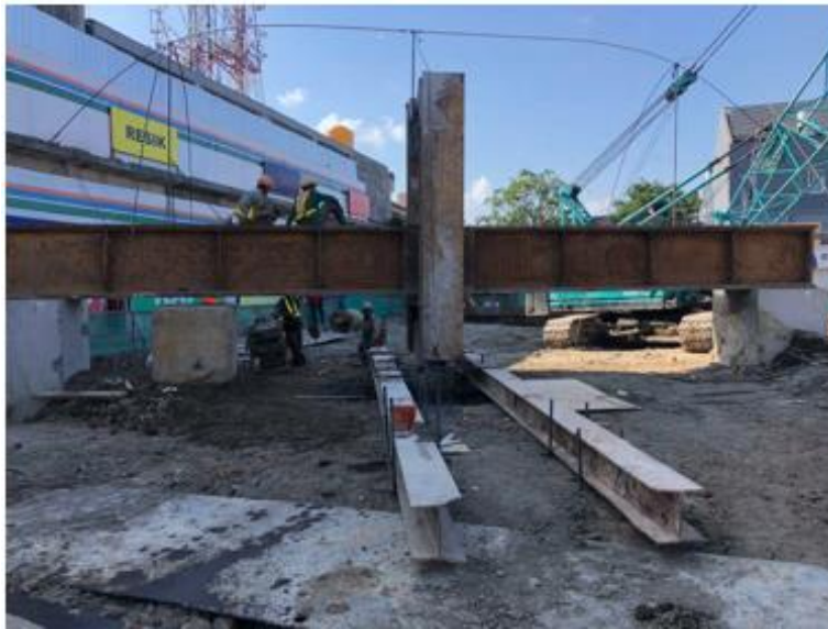
Gambar 117 Pemasangan Reference Beam (Sumber Foto Lapangan)
