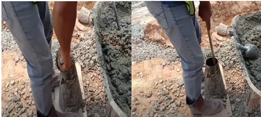
Gambar 38 Pengambilan Sample Beton (Sumber Foto Lapangan)
