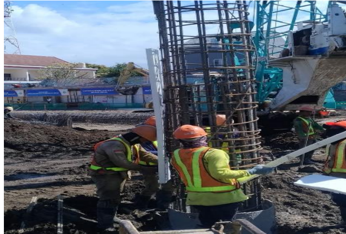
Gambar 35 Pemasangan Styrofoam (Sumber Foto Lapangan)
