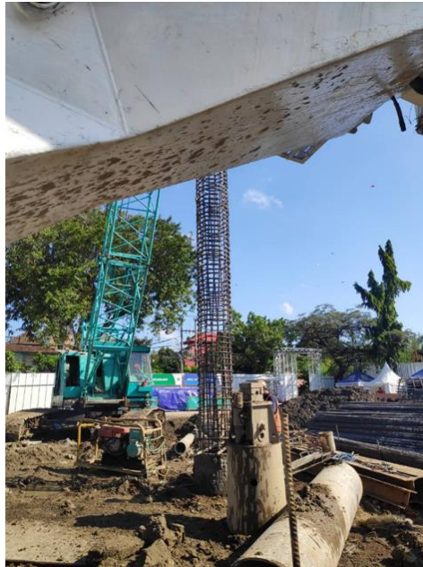
Gambar 93 Pekerjaan Reaction/Unused pile (Sumber Foto Lapangan)
