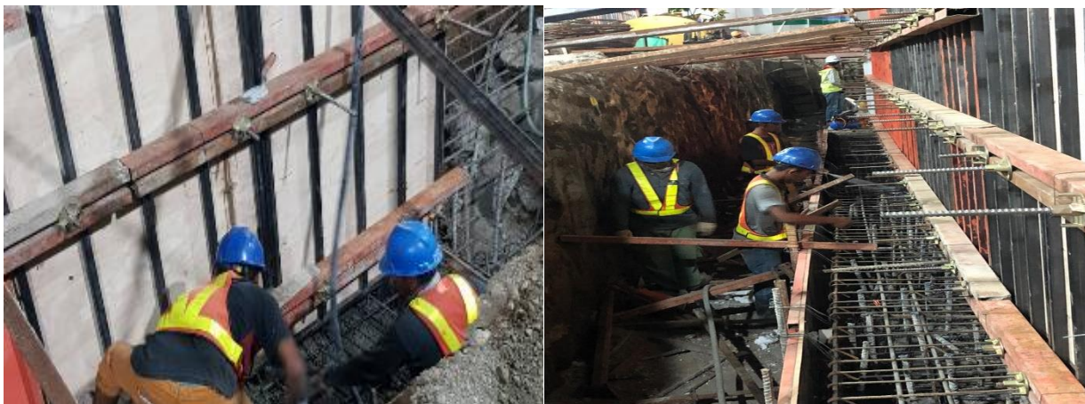
Gambar 66 Pembesian dan Bekisting Capping Beam (Sumber Foto Lapangan)
