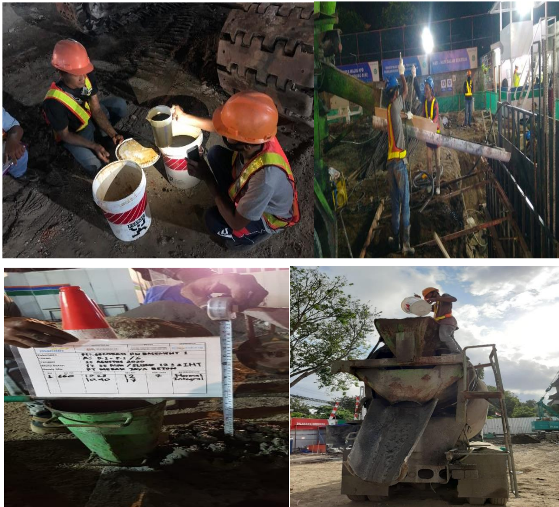
Gambar 82 Pengecoran Retaining Wall (Sumber Foto Lapangan)
