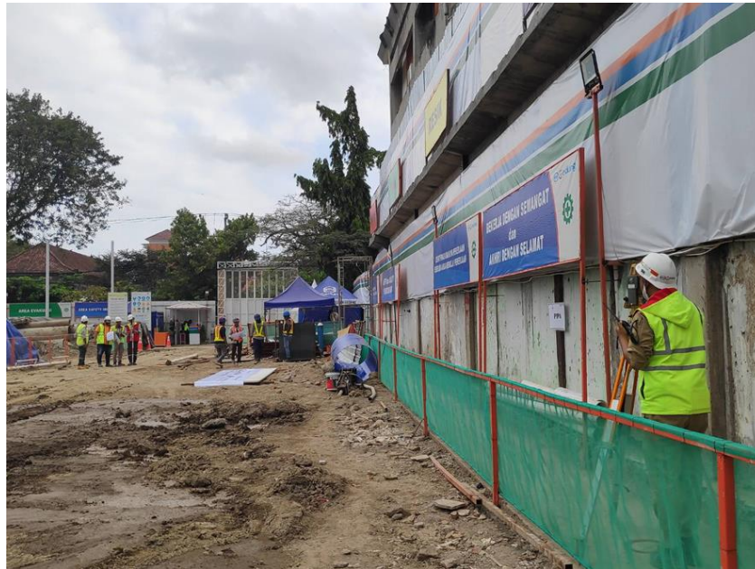
Gambar 114 Penentuan Titik Reaction/Unused pile (Sumber Foto Lapangan)
