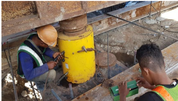
Gambar 108 Hydraulic Jack (Sumber Foto Lapangan)
