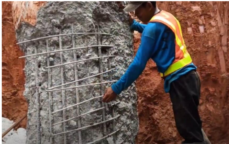
Gambar 79 Pembobokan Bored Pile (Sumber Foto Lapangan)
