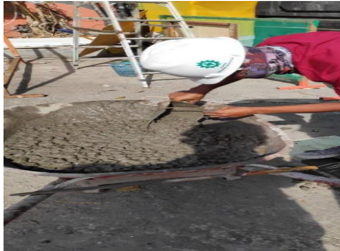
Gambar 37 Pengambilan Sample Beton (Sumber Foto Lapangan)
