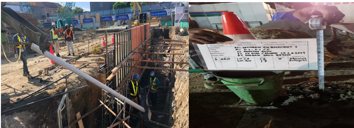
Gambar 68 Pengecoran Area Capping Beam (Sumber Foto Lapangan)
