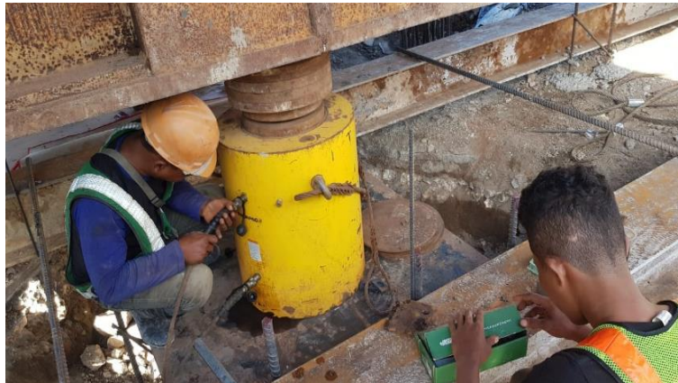
Gambar 87 Hydraulic Jack (Sumber Foto Lapangan)
