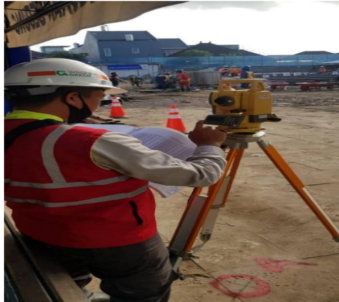
Gambar 15 Pemasukan Data Koordinat X, Y pada Alat Total Station (Sumber Foto Lapangan)
