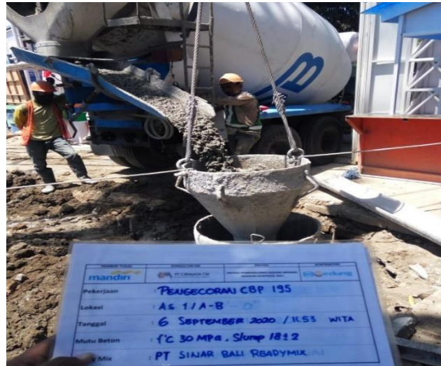
Gambar 41 Benda Uji Beton CBP (Sumber Foto Lapangan)
