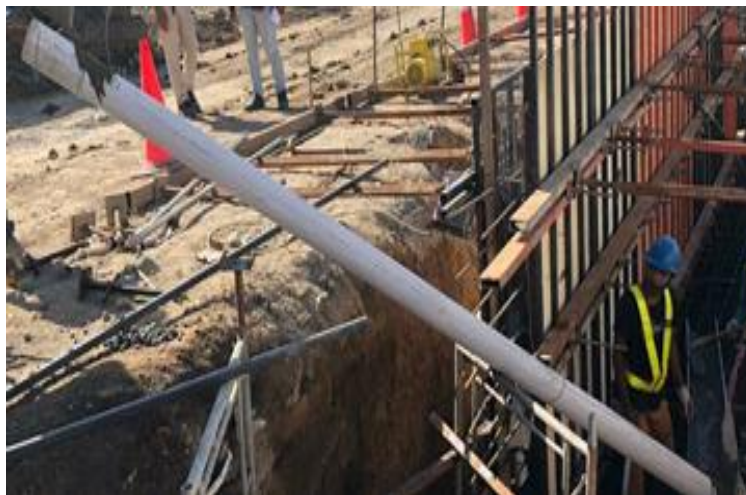
Gambar 59 Pipa Pengecoran (Sumber Foto Lapangan)
