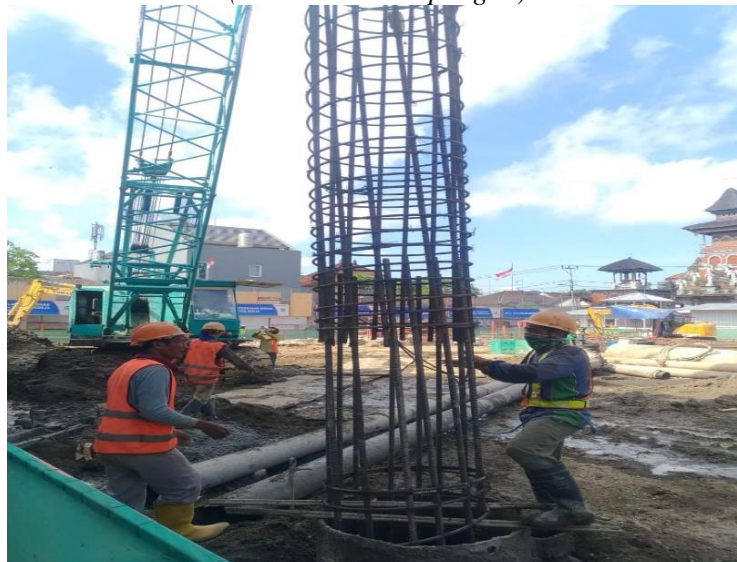
Gambar 34 Pemasukan Besi CBP (Sumber Foto Lapangan)
