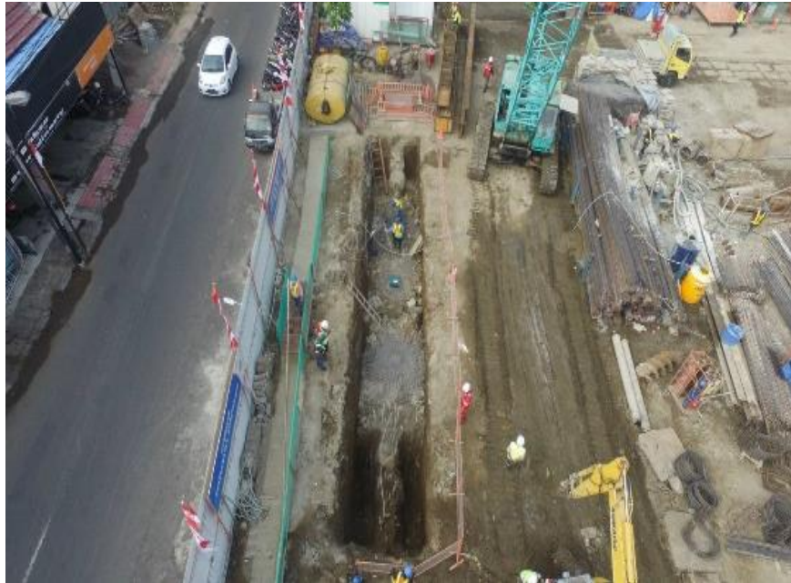
Gambar 78 Penggalian Tanah (Sumber Foto Lapangan)
