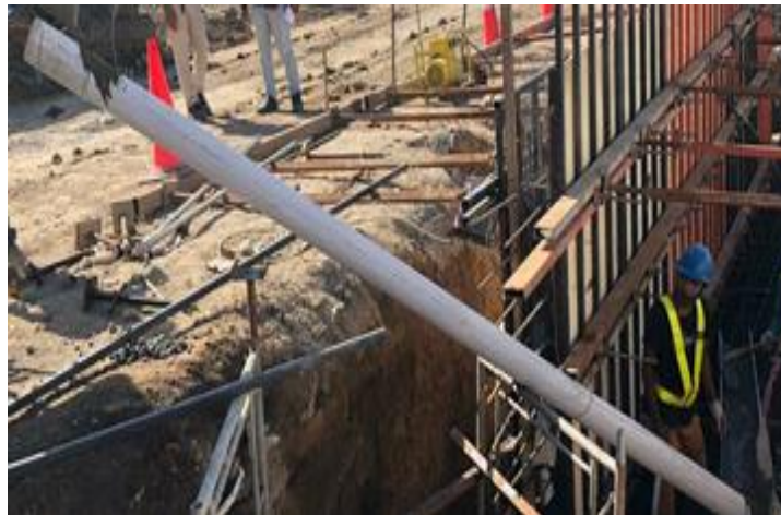
Gambar 72 Pipa Pengecoran (Sumber Foto Lapangan)
