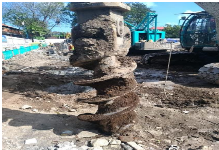
Gambar 51 Pengeboran Bentonite (Sumber Foto Lapangan)
