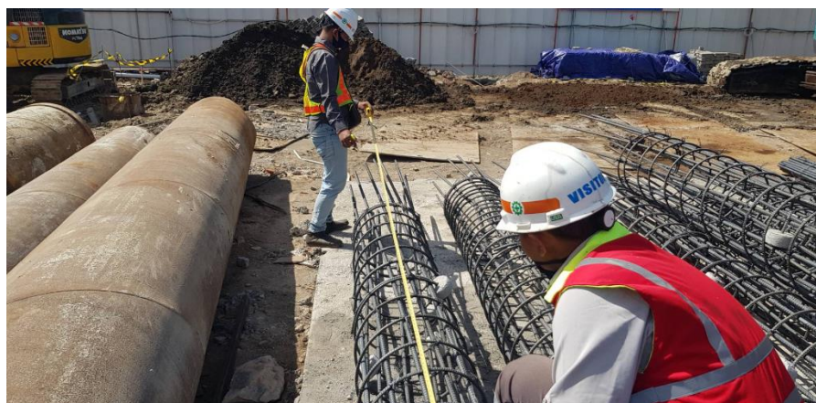
Gambar 32 Pengecekan Panjang Tulangan oleh QC (Sumber Foto Lapangan)
