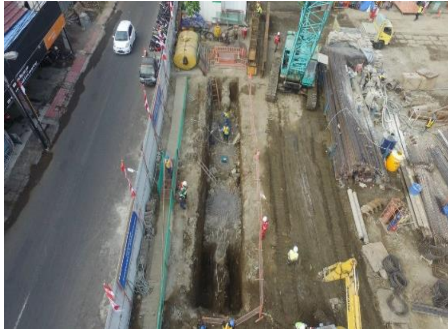
Gambar 64 Penggalian tanah Capping Beam (Sumber Foto Lapangan)
