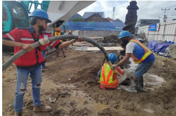
Gambar 47 Selang Pengecoran (Sumber Foto Lapangan)
