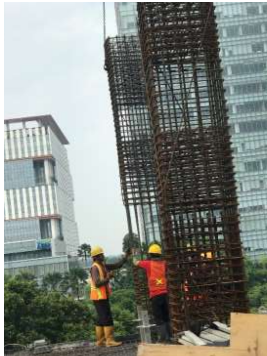
Gambar 7.4 Controlling Progres Pekerjaan Kolom Sumber: Dokumentasi Penulis, 2020.
