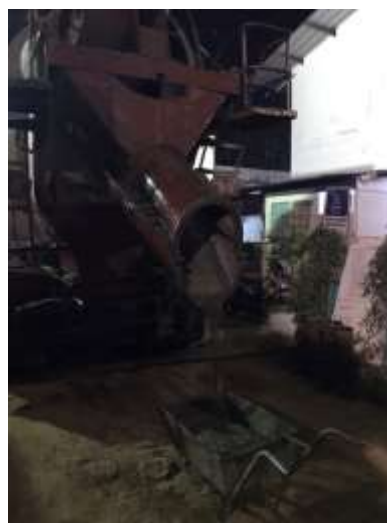
Gambar 5. 13 Concrete Mixer Truck Sumber: Dokumentasi Penulis, 2020.
