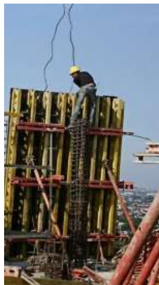
Gambar 4. 11 Proses Pembongkaran Bekisting Kolom dan Shearwall Sumber: Dokumentasi Penulis, 2020.
