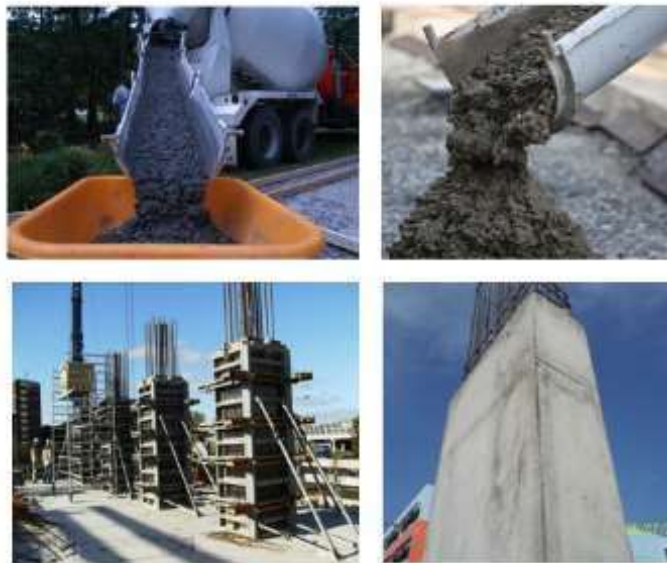
Gambar 5. 2 Material dan Bahan Bantu Pembuatan Kolom Sumber: Google.
