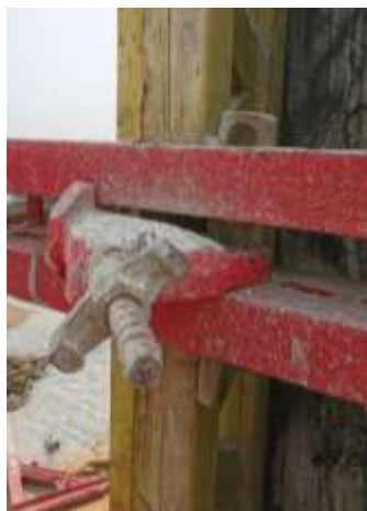
Gambar 4. 2 Tie Rod pada Bekisting Kolom Sumber: Dokumentasi Penulis, 2020.
