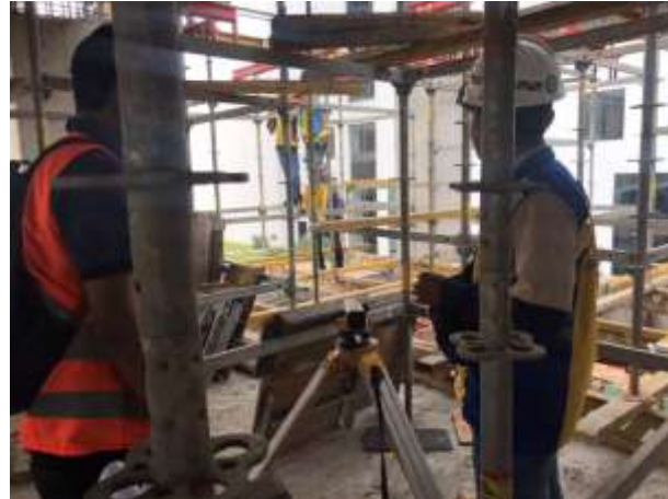
Gambar 4. 6 Proses surveying dan Penentuan As Kolom dan Shear Wall Sumber: Dokumentasi Penulis, 2020.
