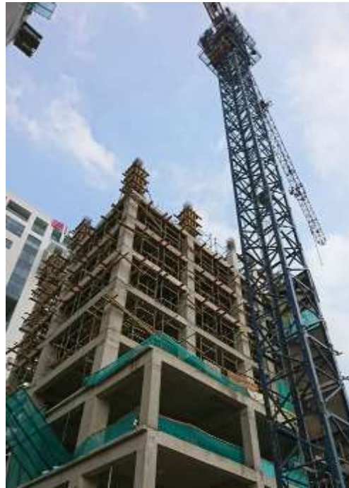
Gambar 3. 8 Tower Crane Proyek Gedung Sanggala Sumber: Dokumentasi Penulis, 2020.
