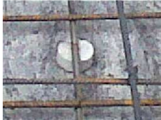
Gambar 5. 6 Beton Decking Sumber: Dokumentasi Penulis, 2020.
