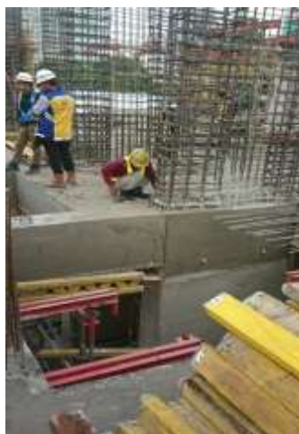
Gambar 4.16 Proses Pelepasan Bekisting Pelat Sumber: Dokumentasi Penulis, 2020.
