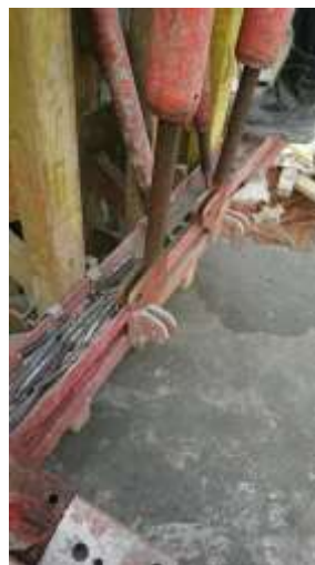
Gambar 4.4 Extension Splice pada Bekisting Kolom Sumber: Dokumentasi Penulis, 2020.
