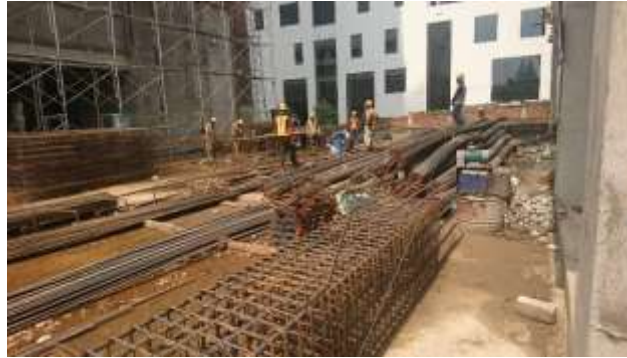
Gambar 3. 9 Stockyard Proyek Gedung Sanggala Sumber: Dokumentasi Penulis, 2020.
