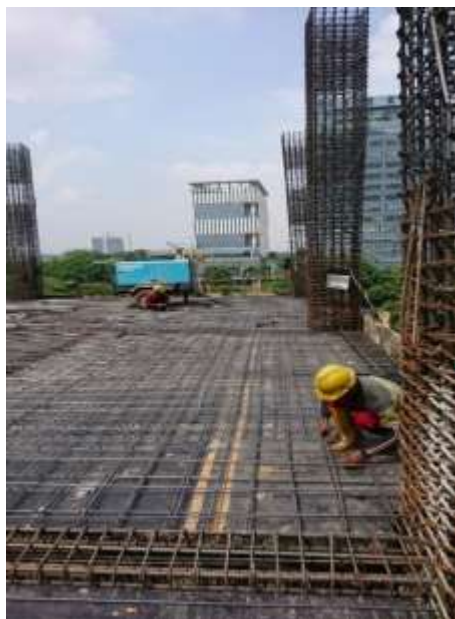
Gambar 4.14 Proses Pemasangan Tulangan Pelat dan Stopcor Sumber: Dokumentasi Penulis, 2020.
