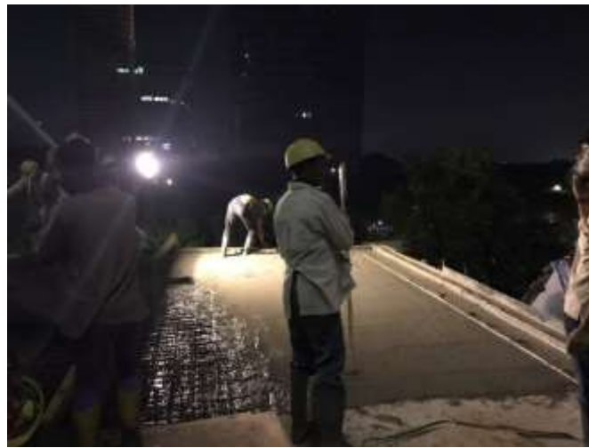
Gambar 4.15 Proses Pengecoran Pelat Sumber: Dokumentasi Penulis, 2020.
