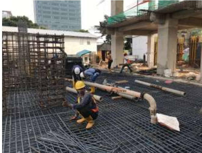
Gambar 5. 14 Concrete Pump Sumber: Dokumentasi Penulis, 2020.
