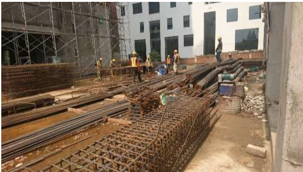
Gambar 5. 5 Besi Tulangan Sumber: Dokumentasi Penulis, 2020.
