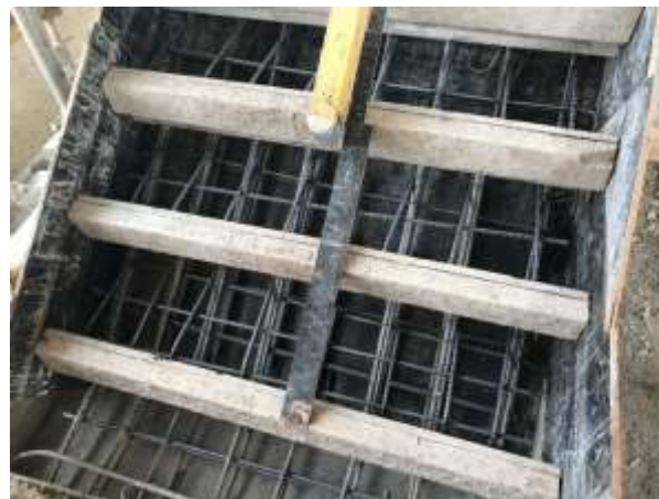
Gambar 7. 1 Controlling Jumlah Tulangan Tangga Sumber: Dokumentasi Penulis, 2020.
