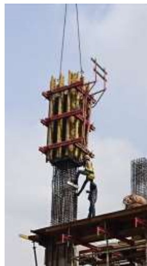
Gambar 4. 9 Proses Pemasangan Bekisting Kolom dan Shearwall Sumber: Dokumentasi Penulis, 2020.
