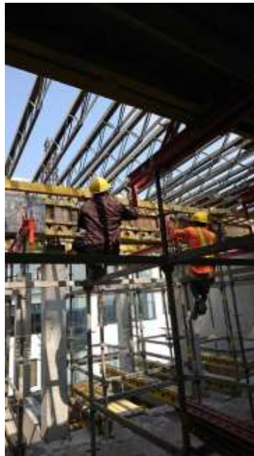
Gambar 5. 8 Scaffolding Sumber: Dokumentasi Penulis, 2020.
