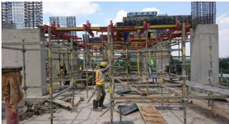
Gambar 4. 12 Fabrikasi Tableform Sumber: Dokumentasi Penulis, 2020.
