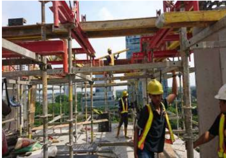
Gambar 4.13 Pemasangan Bekisting Pelat lantai 4 Sumber: Dokumentasi Penulis, 2020.
