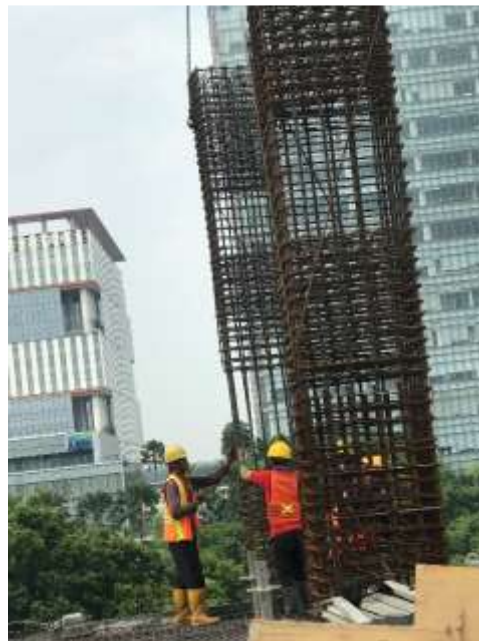
Gambar 4. 7 Proses Pemasangan Tulangan Kolom Sumber: Dokumentasi Penulis, 2020.
