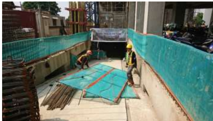
Gambar 3. 2 Proteksi Area Dalam Proyek berupa Safety Net Sumber: Dokumentasi Penulis, 2020.
