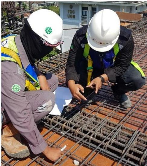
**Gambar 5. 47 Pengecekan Jarak Tulangan**
