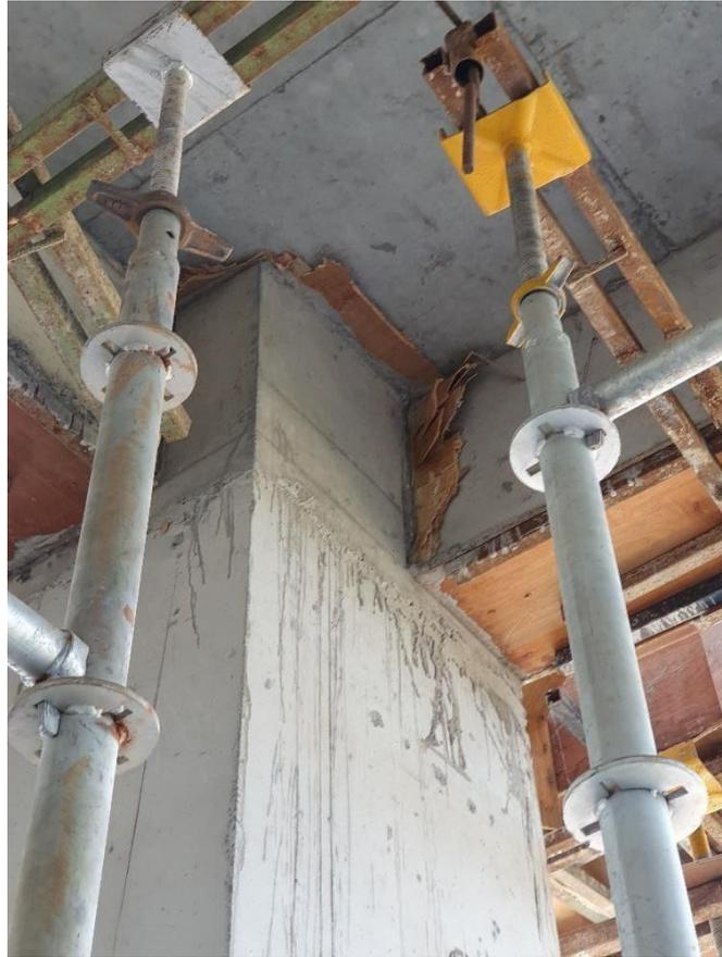
**Gambar 7. 2 Sisa Multiplek yang Tertinggal Saat Bongkar Bekisting**
