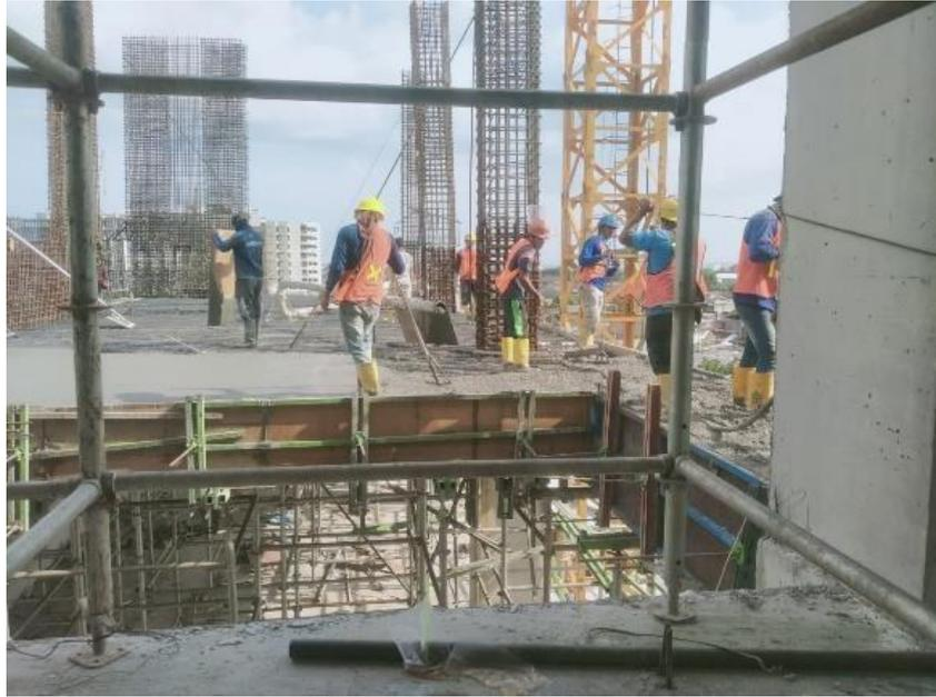
**Gambar 5. 50 Pengecoran Pelat dan Balok**
