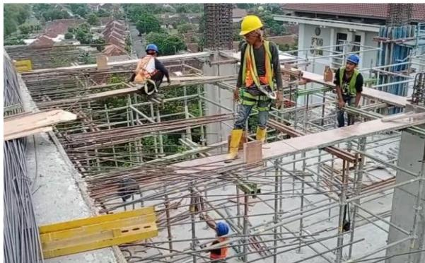
**Gambar 5. 43 Pemasangan Bekisting Balok dan Pelat**
