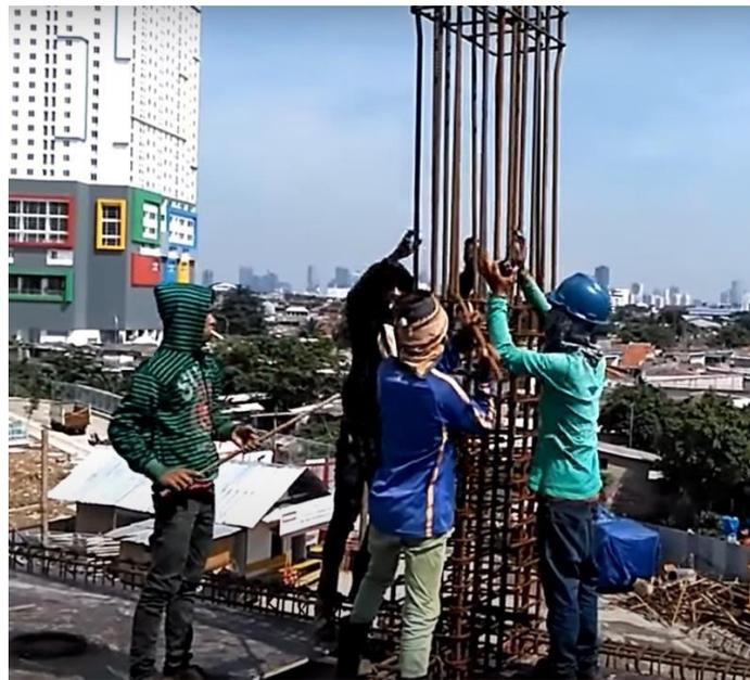
**Gambar 5.38 Ilustrasi Pemasangan Sambungan Antar Kolom**
