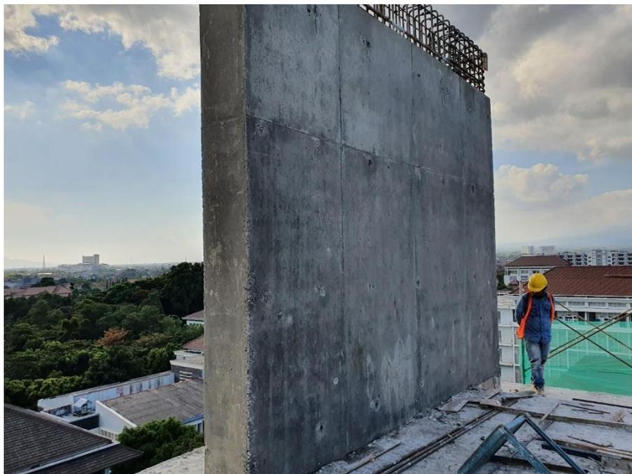
**Gambar 5. 16 Ilustrasi Setelah Pembongkaran Bekisting**
