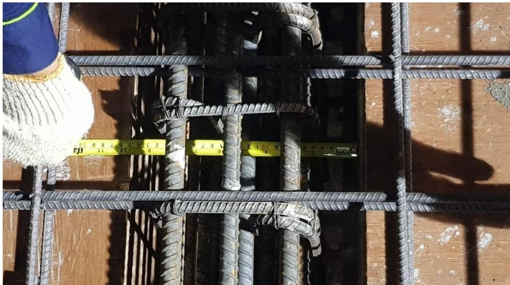
**Gambar 6. 20 Pengecekan Jarak Antar Tulangan**
