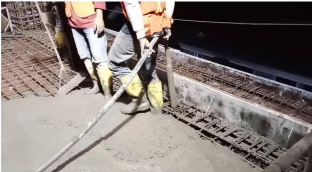
**Gambar 5. 51 Pematatan Beton Cair**
