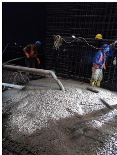
**Gambar 5. 3 Pengecoran**
