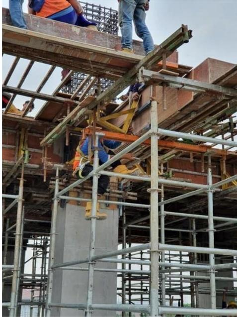
**Gambar 5. 17 Pemasangan Bekisting Balok dan Pelat**
