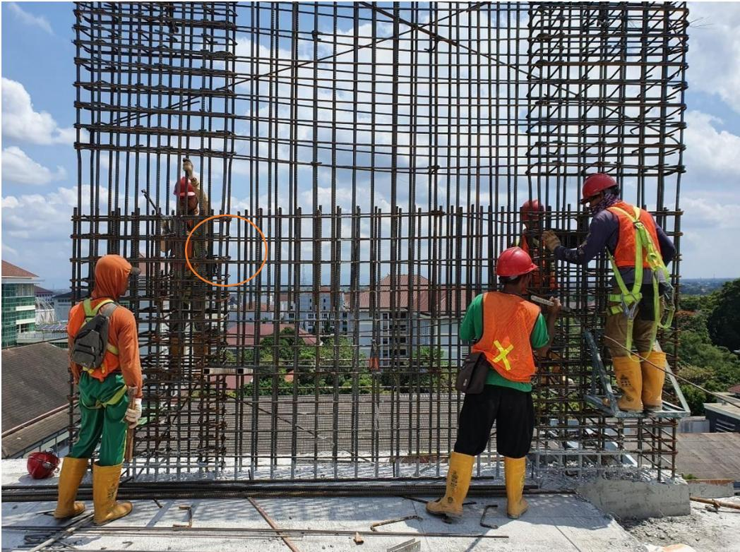
**Gambar 7.6** Penyambungan *Shearwall* Kurang Tulangan
