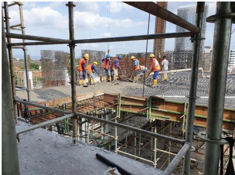
**Gambar 5. 25 Pemerataan Permukaan Beton Setelah Dituang ke Bekisting**
