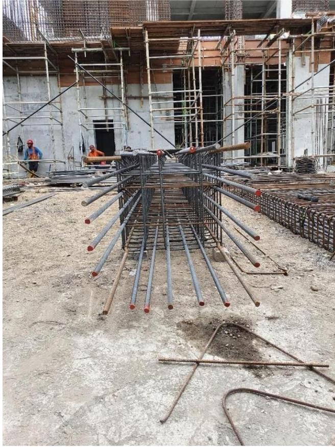
**Gambar 5. 7 Perakitan dan Pemasangan Tulangan Kolom**
