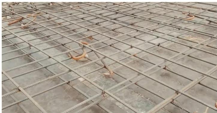
**Gambar 5. 45 Pemasangan Spacer Tulangan**
