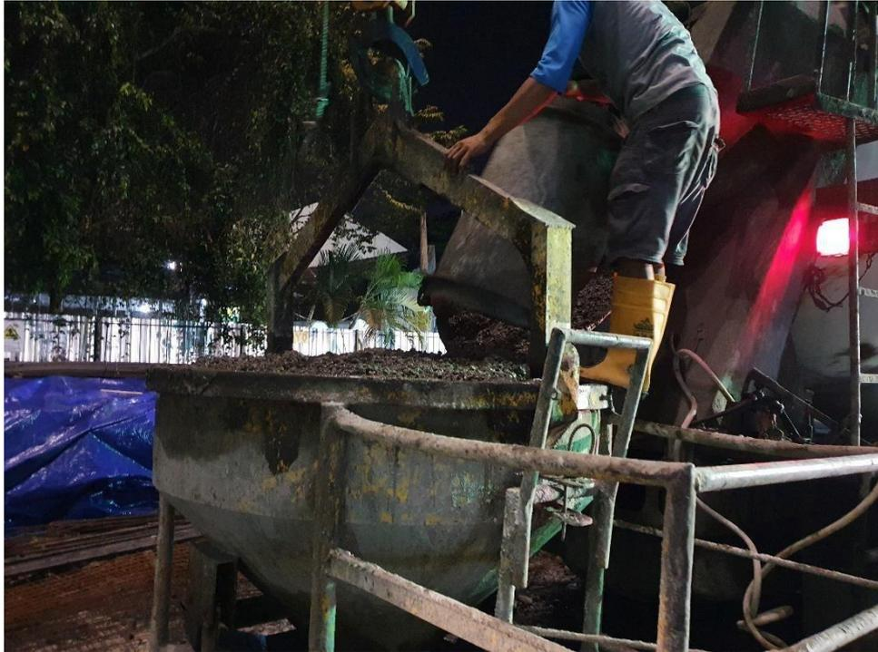
**Gambar 5. 14** Penuangan Beton ke *Bucket*
