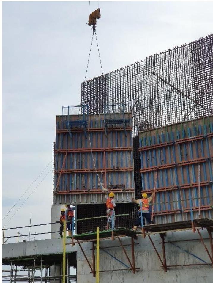
**Gambar 5. 11 Pemasangan Bekisting Kolom dan Dinding**
