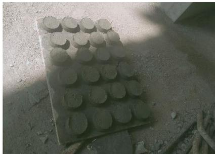
**Gambar 3. 5 Decking Beton (Tahu Beton)**
