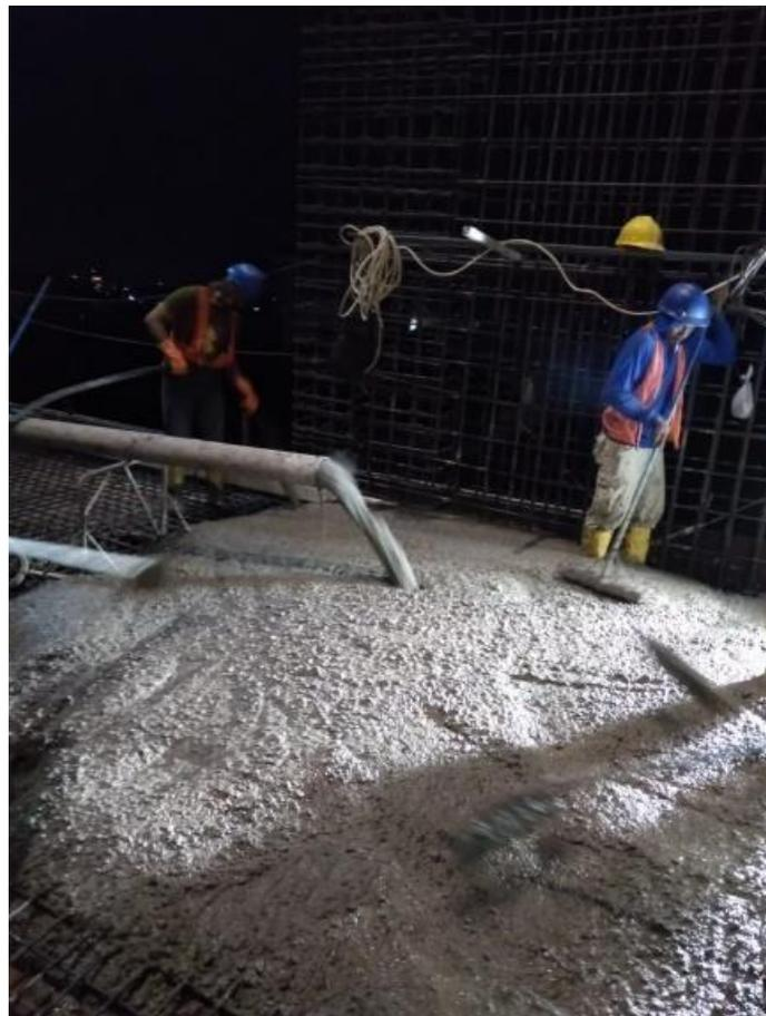
**Gambar 5. 23 Penggunaan *Concrete Pump* Untuk Pengecoran**
