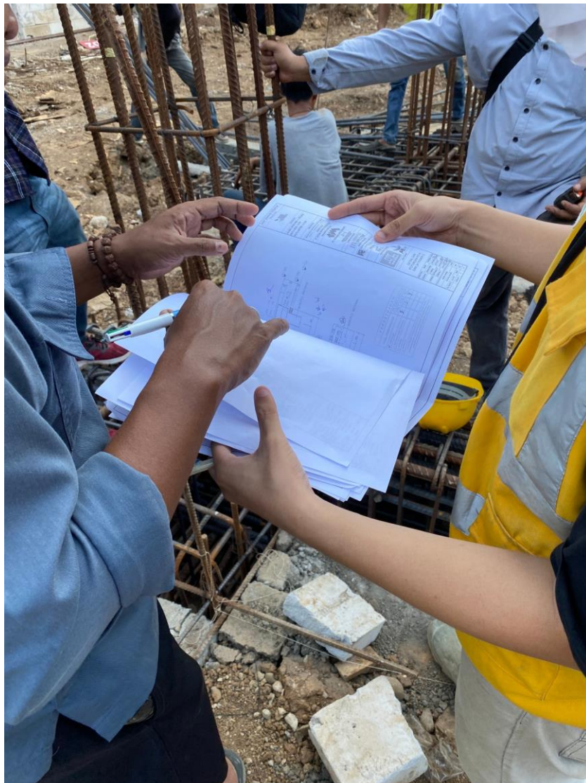
Gambar 5.10 Pengecekan Tulangan Pile Cap
