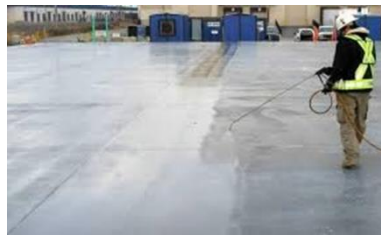
Gambar 3.11 Curing dengan penyemprotan Air
