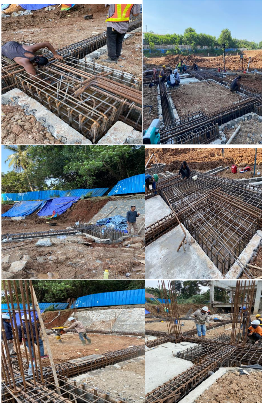
Gambar 3.12 Penulangan Pile Cap dan Kolom
