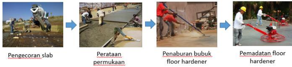
Gambar 3.10 Ilustrasi Pekerjaan Floor Hardener
