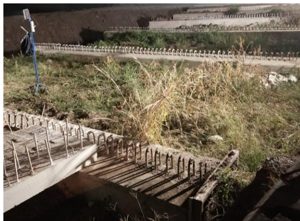
Gambar 3.37 Lokasi Dilakukannya Erection Half Slab
