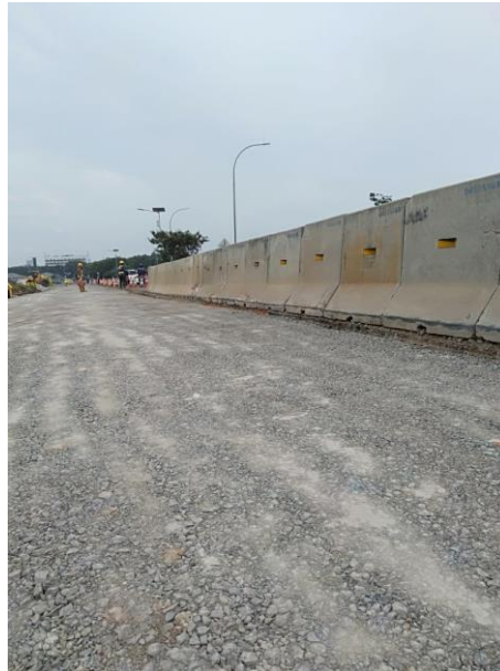
Gambar 3.45 Lapisan Base Course A Interchange Selatan Sisi Timur Airnav
