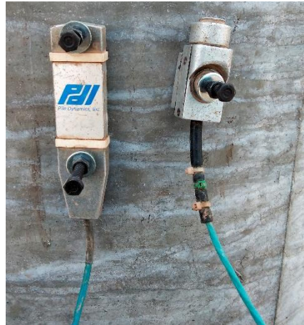
Gambar 3.58 Pemasangan Transducer dan Accelerometer pada Spun Pile
