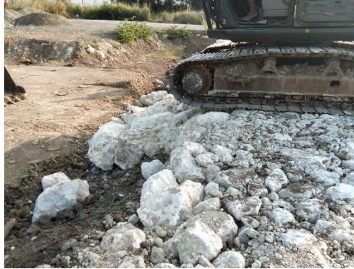
Gambar 3.65 Penampakan 1 Material Limestone pada Area Pool Taxi
