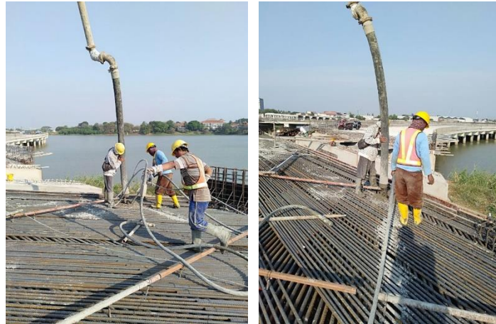
Gambar 3.77 Proses Pengecoran Box Culvert Diagonal Selatan
