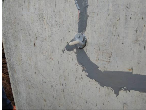
Gambar 3.75 Pemasangan Nipple Injeksi dan Penutupan Keretakan Menggunakan Material Sika-Sikadur
