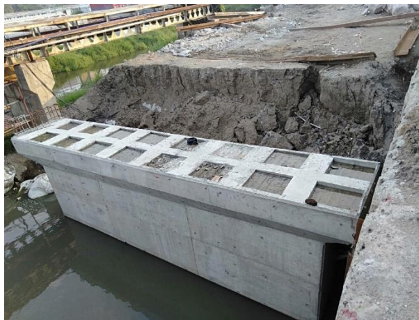
Gambar 3.51 Dinding Box Culvert Selatan A2
