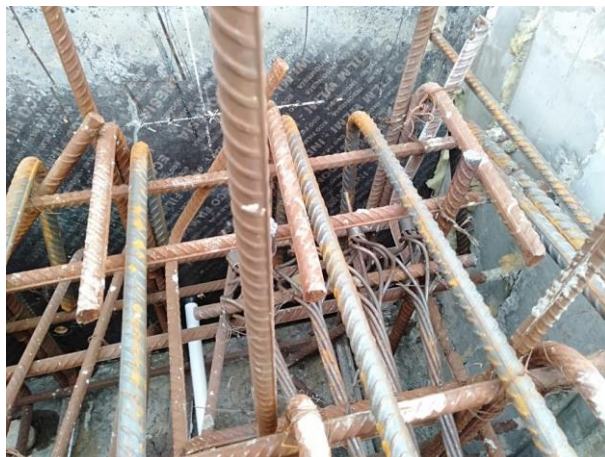
Gambar 3.25 Angkur Mati Tendon Arah Lateral Jembatan Utama
