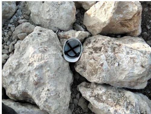
Gambar 3.66 Penampakan 2 Material Limestone pada Area Pool Taxi
