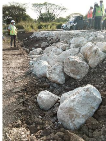
Gambar 3.67 Penampakan 3 Material Limestone pada Area Pool Taxi
