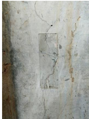
Gambar 3.70 Penampakan Retak pada Kaca
