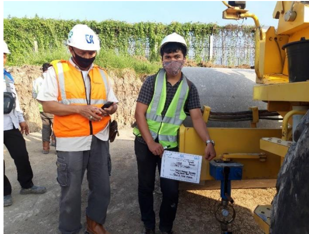
Gambar 3.41 Pengujian CBR Lapisan Tanah Dasar di Lapangan
