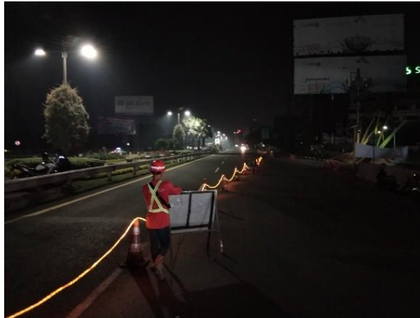
Gambar 3.8 Pemasangan Pengamanan Berupa Plang Peringatan dan Informasi Pekerjaan
