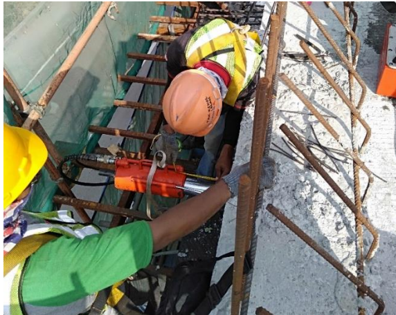
Gambar 3.26 Proses Jacking Tendon Arah Lateral Jembatan Utama
