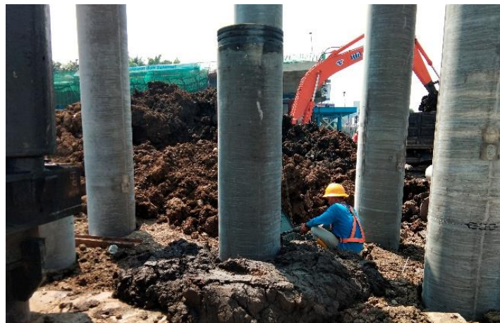
Gambar 3.57 Spun Pile yang Diuji
