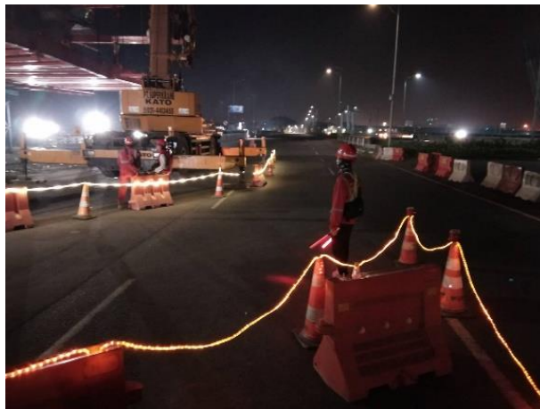
Gambar 3.4 Kegiatan Erection Form Traveller Pada Sebagian Sisi Jalan
