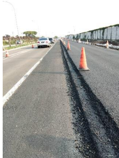
Gambar 3.10 Pemasangan Kun Pada Jalan yang Baru di Aspal
