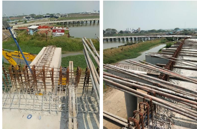
Gambar 3.68 Perubahan Desain Pile Head Jembatan Sisi Utara
