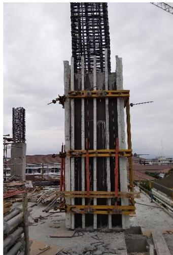
Gambar 3.11 Pemasangan bekisting kolom
