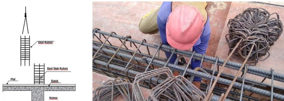
Gambar 3.9 Ilustrasi perakitan dan pemasangan tulangan kolom
