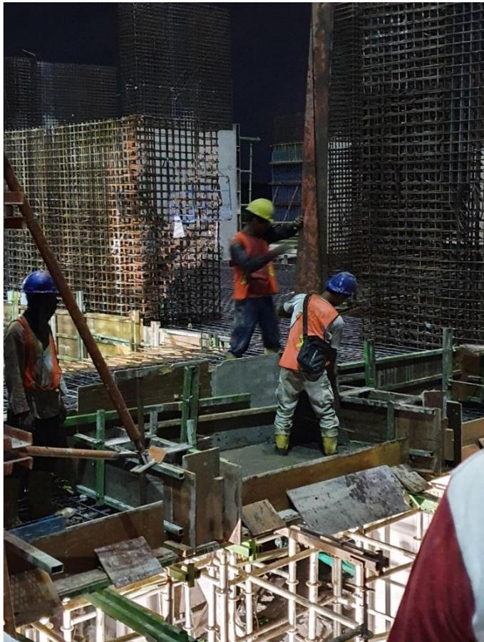
Gambar 3.5 Proses pengecoran pelat lantai
