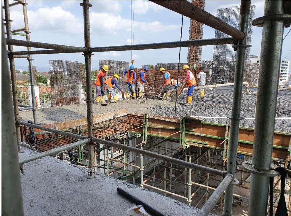
Gambar 3. 6 Proses perataan beton pada pelat lantai
