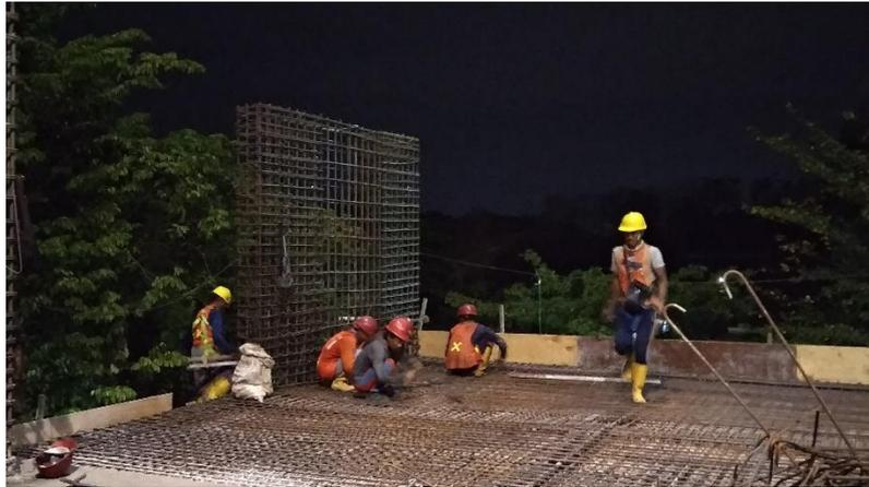
Gambar 3.3 Pekerjaan penulangan balok dan pelat lantai
