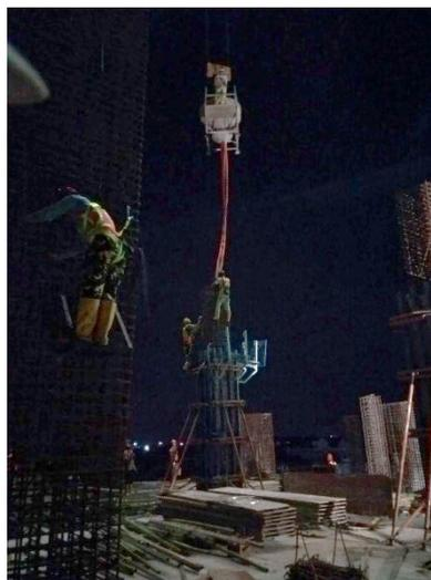
Gambar 3.15 Pengecoran kolom
