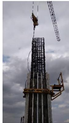
Gambar 3.16 Ilustrasi setelah pembongkaran bekisting kolom
