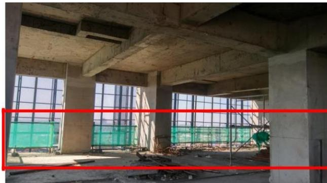
Gambar 4. 7 Pagar pembatas atau railing
