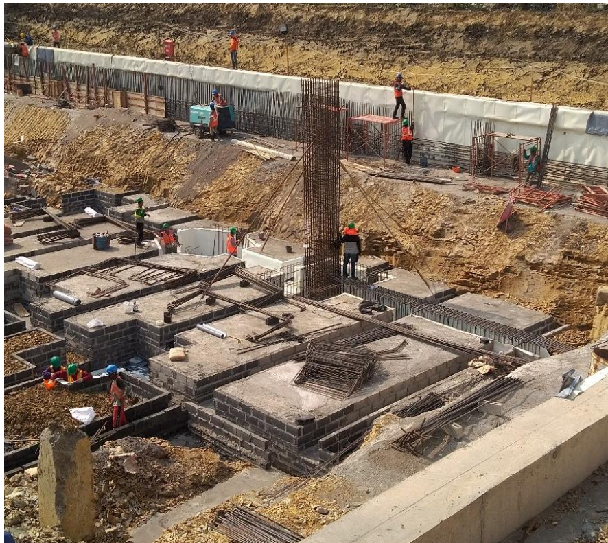
Gambar 3.3 Pekerjaan pemasangan bekisting tie beam dan pile cap
