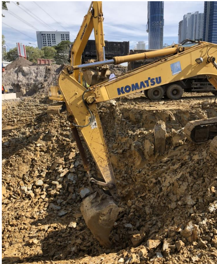
Gambar 3.11 Pekerjaan galian basement
