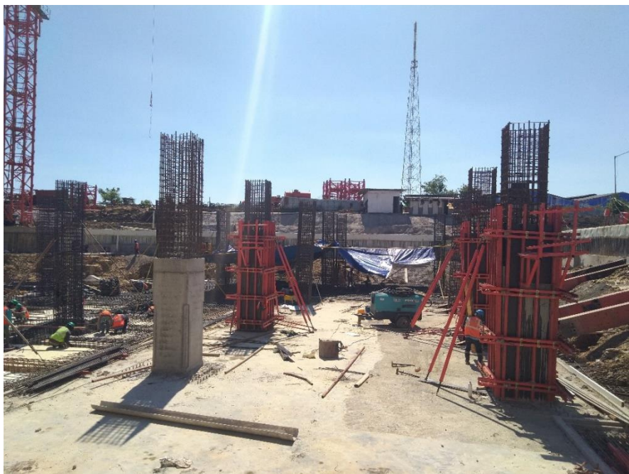
Gambar 3.4 Pekerjaan pemasangan bekisting pada kolom lantai basement 2
