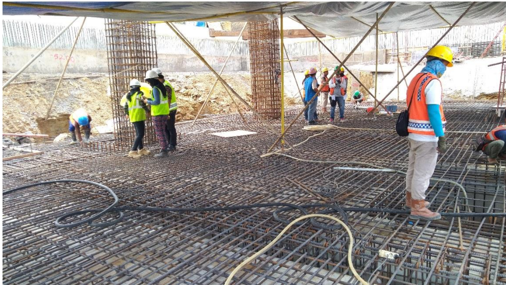
Gambar 3.5 Pekerjaan penulangan pada area pelat lantai basement 2
