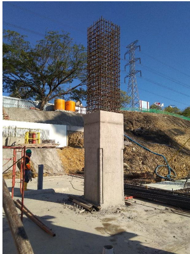
Gambar 3.7 Pekerjaan kolom pada area tower lantai basement 2
