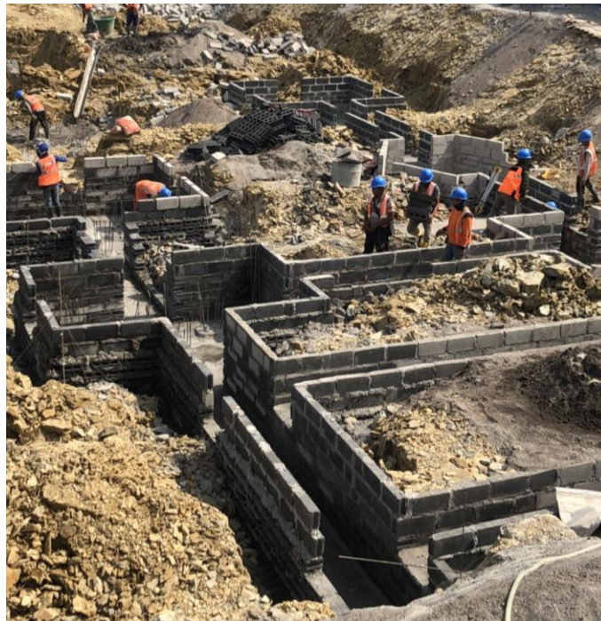
Gambar 3.14 Pekerjaan bekisting pile cap dan tie beam
