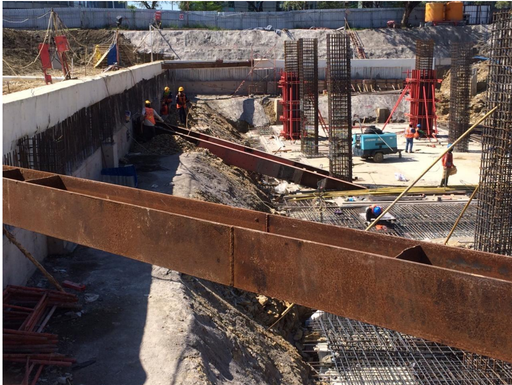
Gambar 3.28 Pemasangan strutting beam pada sudut area galian
