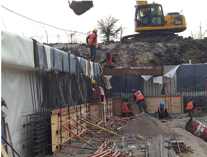
Gambar 3.8 Pekerjaan penulangan waller beam di area tower
