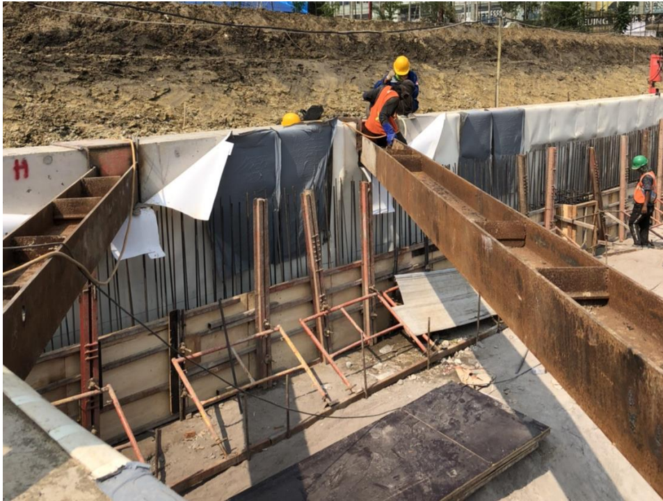
Gambar 3.18 Pemasangan bekisting serta penulangan waller beam dan retaining wall
