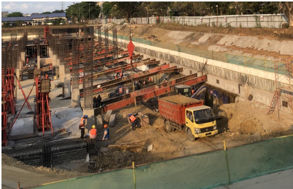
Gambar 3.20 Pemasangan strutting beam
