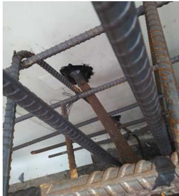
Gambar 3.22 Pemasangan angkur dengan mortar injection
