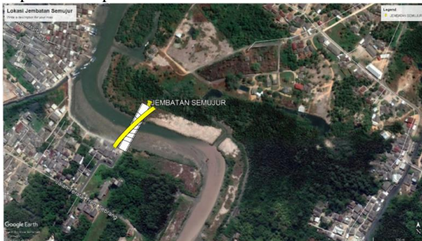
Gambar 3.1 Tampak Atas Jembatan
