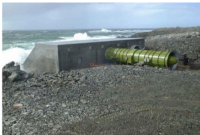
Gambar 2.11 Salah Satu Contoh WEC dengan Konsep OWC, LIMPET (Falcão, 2010)
