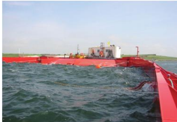
Gambar 2.9 Salah Satu Contoh WEC dengan Konsep Overtopping Devices , Wave Dragon
