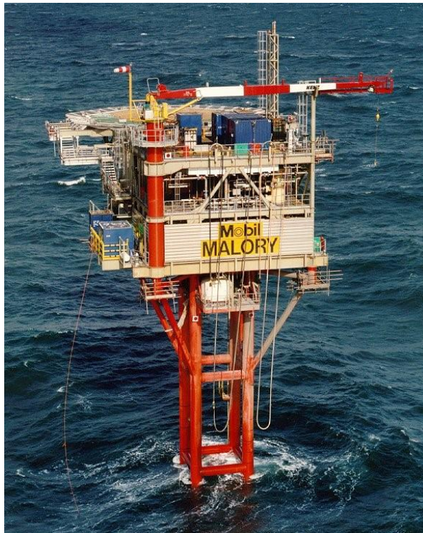
Gambar 2. 1 Contoh Struktur Jacket Minimalis
