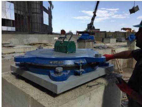
Gambar 6. Pemasangan FPS dan pengencangan baut
