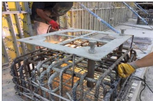
Gambar 1. Pemasangan steel gage dan bottom dowels
