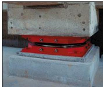
**Gambar 2.10** Pemasangan FPS Pada Kolom Pedestal yang Pendek
