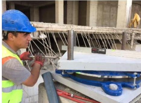
Gambar 7. Pemasangan *top plate*, dan *dowels*, serta *leveling*
