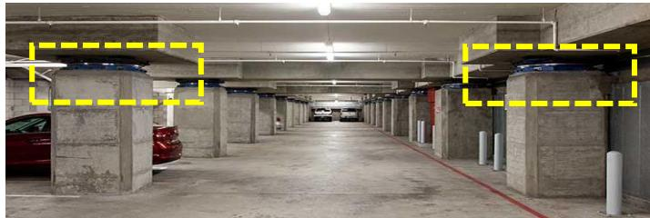
**Gambar 2.9** Pemasangan FPS di Atas Kolom Area Basement
