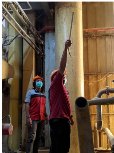
Gambar 34. Proses penandaan dan penentuan lokasi Pondasi/Struktur ( marking and positioning )
