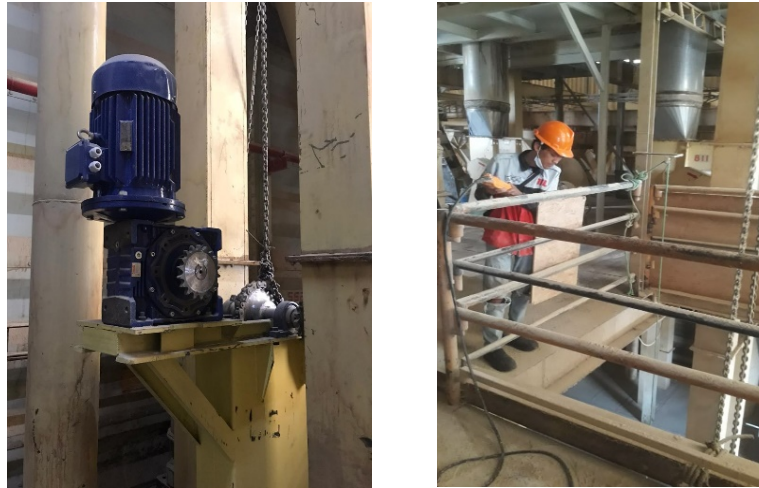
Gambar 35. Proses Pengangkatan ( Lifting )
