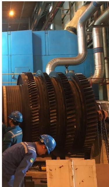
Gambar 3.7 Turbin pada saat Overhaul
