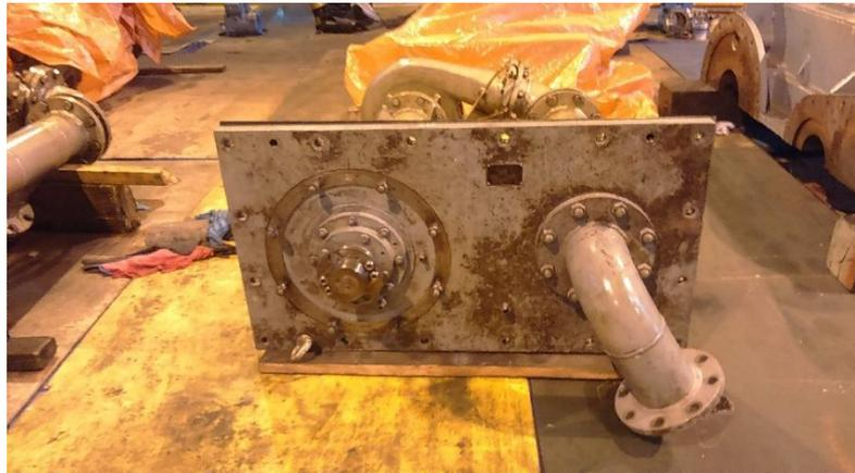
Gambar 4.14. Auxiliary Lube Oil Pump (AOP) pada PLTGU PJB Gresik
