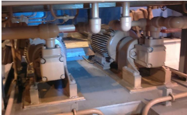
Gambar 4.8. Jacking Oil Pump pada PLTGU PJB Gresik
