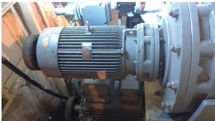
Gambar 4.7. AC Turning Motor pada PLTGU PJB Gresik
