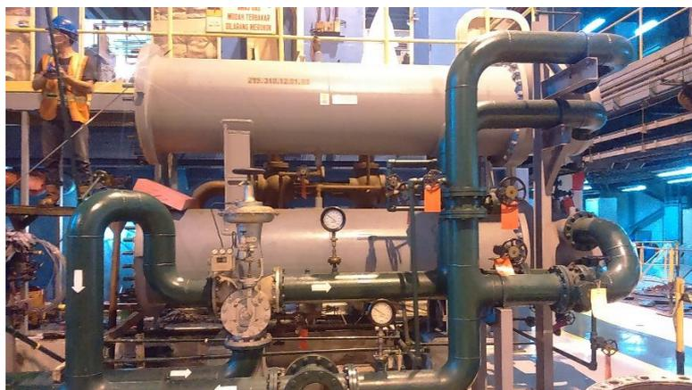
Gambar 4.9. Cooling Oil Cooler pada PLTGU PJB Gresik
