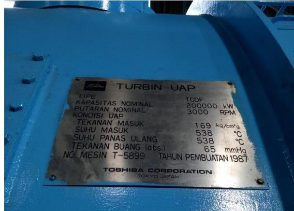
Gambar 3.12. Spesifikasi Turbin Uap
