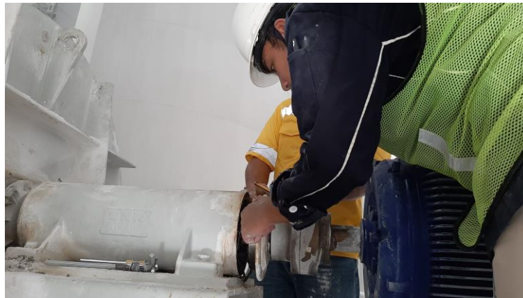
Gambar 3. 11 Pembukaan Cassing Motor Blower Fan
