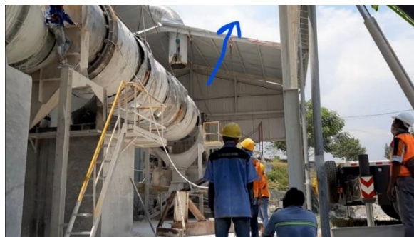
Gambar 3. 1 Pelepasan Atap Untuk Akses Crane
