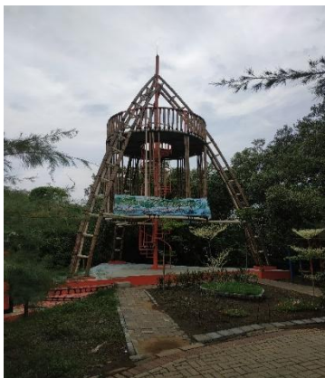
Gambar 4. 7 Menara Pandang (Sumber : Survei Primer)
