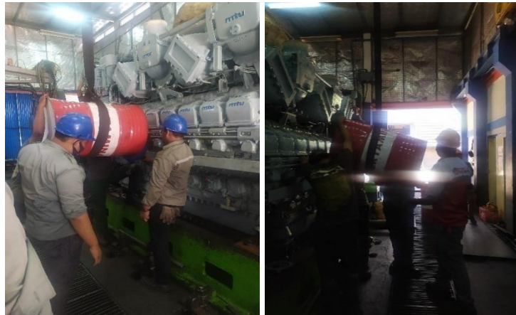
Pengisian oli engine sebelum dilakukan running test
