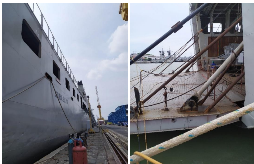
Persiapan proses perbaikan untuk penyesuaian posisi bracket rod eye cylinder hidrolik
