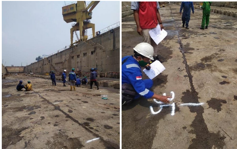
Pengukuran jarak antar side block sebelum dilakukan docking kapal selam
