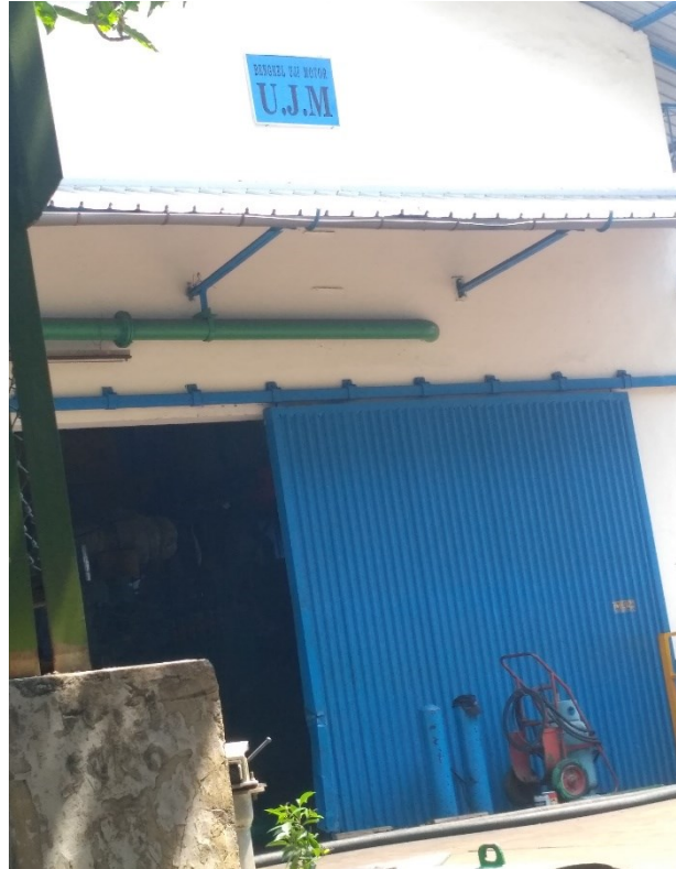
Gambar 1.4 Bengkel Uji Motor (Sumber: Dokumentasi penulis)
