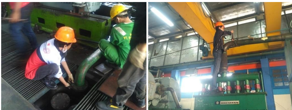
Pemasangan pipa sistem pendinginan
