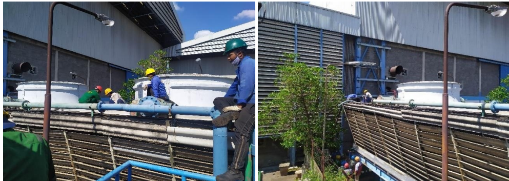
Perbaikan saluran pipa sistem pendingin pada cooling tower
