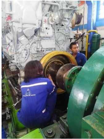
Pemasangan coupling oleh pihak PT AIR
