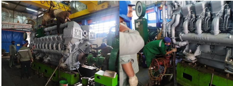
Pemasangan exhaust engine KRI AJAK dan Pemasangan selang bahan bakar
