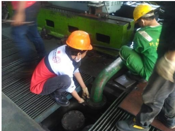
Gambar 5.1 Pemasangan pipa air pendingin (Sumber: Dokumentasi penulis)
