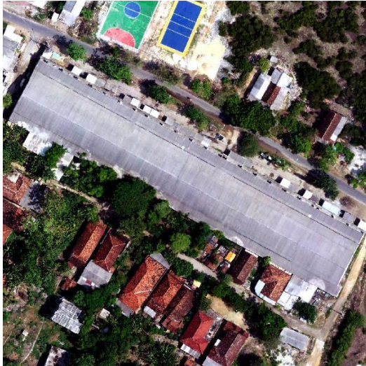
Gambar 4.4 Bangunan Gudang di Desa Campurejo Wilayah 2
