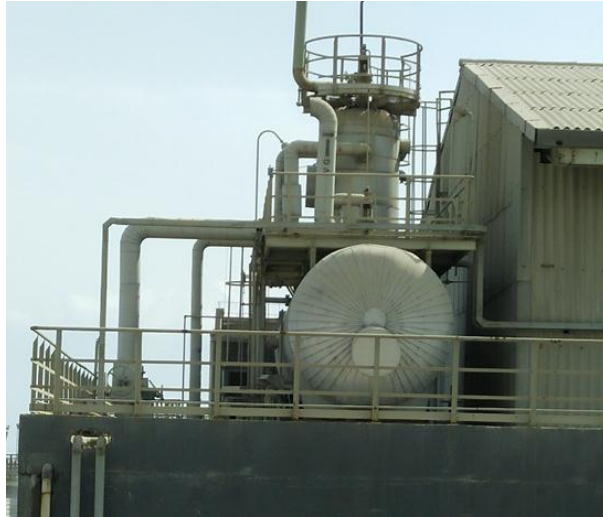
Gambar 2.5 Daerator pada SA plant di PT Petrokimia Gresik
