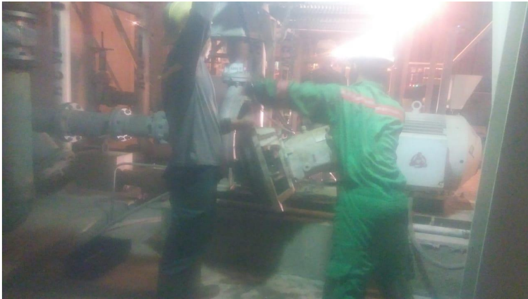
Gambar 5.1 Pembongkaran Pompa
