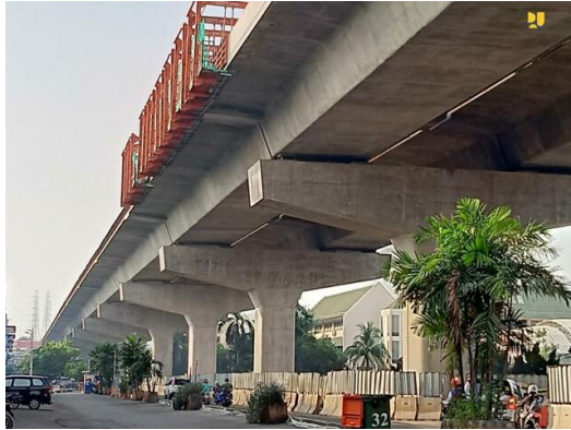
Gambar 2. 1 Jalan Layang Tol dalam Kota
