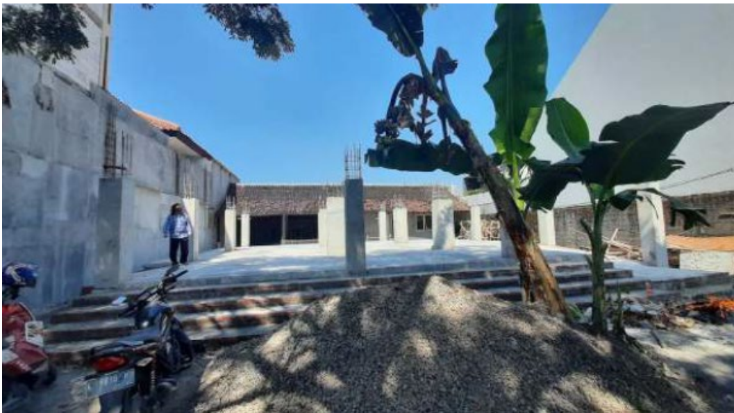
Gambar 72 Proses Pembangunan Pondasi dan Pedestal
