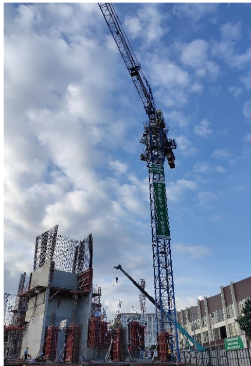
Gambar 4.1 Tower Crane di Lokasi Proyek
