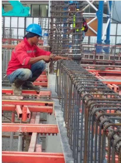
Gambar 4.34 Penulangan Balok Konvensional
