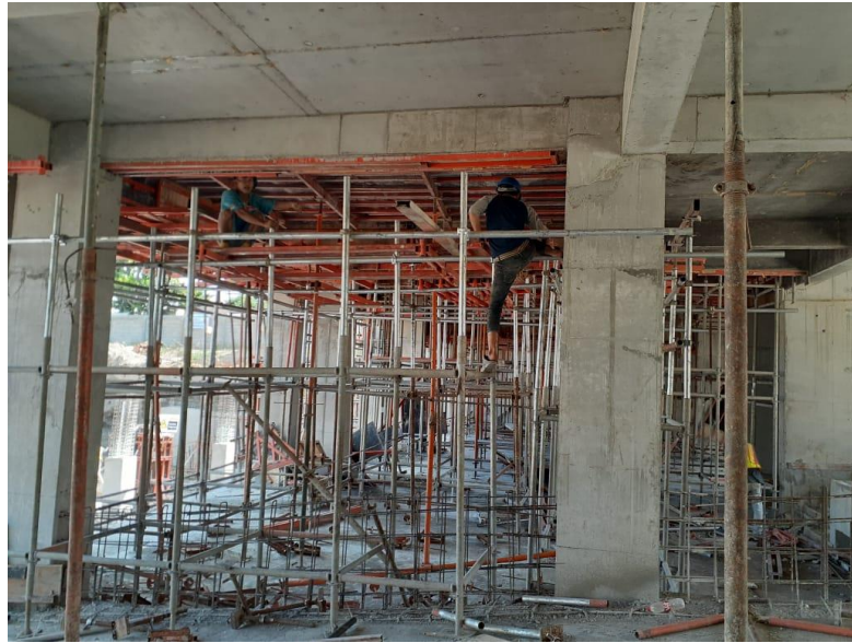
Gambar 4.41 Pembongkaran Bekisting
