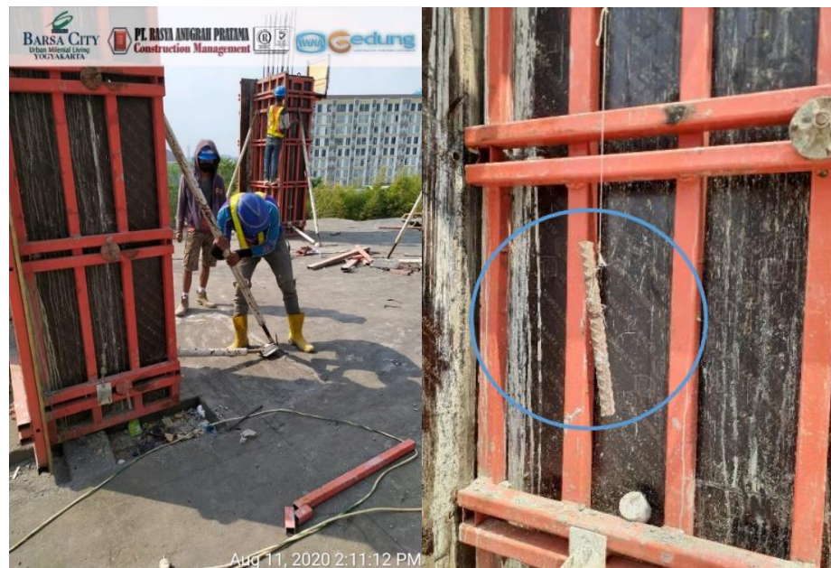
Gambar 4.24 Proses Penguncian Bekisting dan Pengecekan Kelurusan Bekisting dengan Unting – Unting
