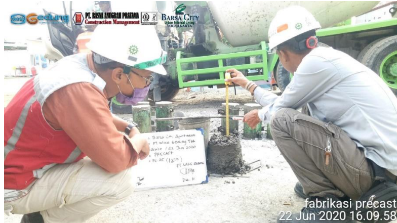
Gambar 4.45 Uji Slump Balok Precast
