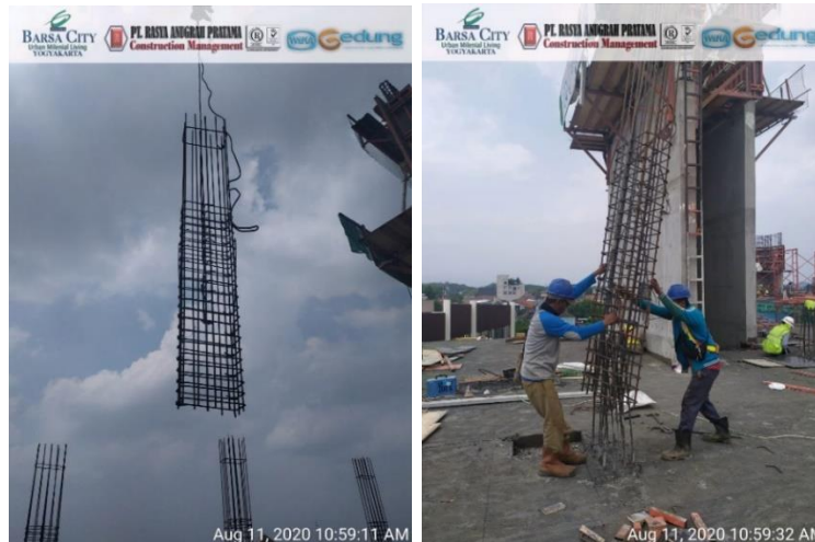
Gambar 4.21 Proses Pemasangan Tulangan Kolom
