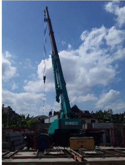
Gambar 4.2 Mobile Crane di Lokasi Proyek
