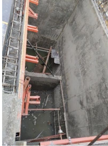
Gambar 4.61 Curing Shear Wall dengan cara menggenanginya.
