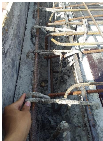
Gambar 4.37 Pengecekan Tulangan Balok Pada Lapangan
