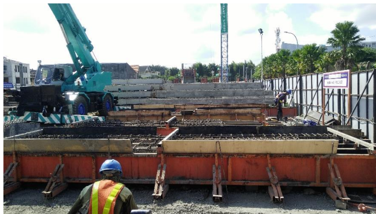
Gambar 4.44 Cetakan Beton Balok Precast
