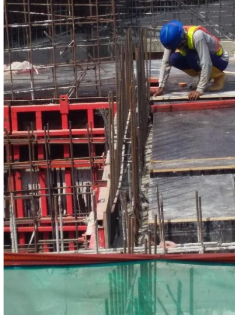
Gambar 4.32 Pemasangan Bekisting Balok dan Pelat Lantai
