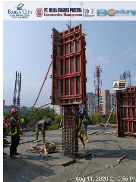
Gambar 4.23 Pemasangan Bekisting Kolom dengan Bantuan Tower Crane
