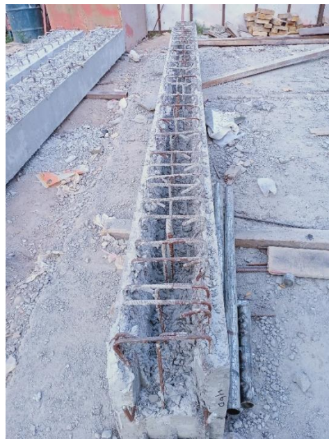
Gambar 4.48 Balok Precast U-Shell (Balok Utama)
