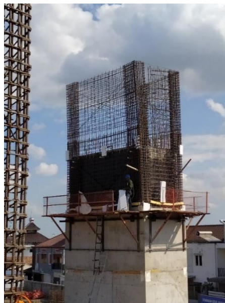
Gambar 4.55 Pemasangan Block Out dan Beton Decking
