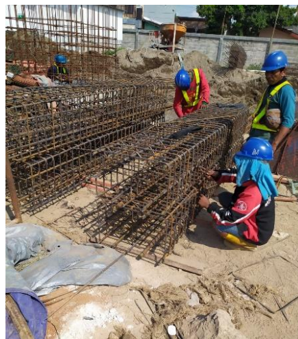
Gambar 4.20 Perakitan Besi Tulangan
