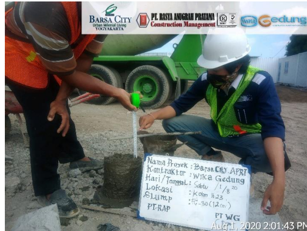
Gambar 4.39 Pengecekan Nilai Slump Beton
