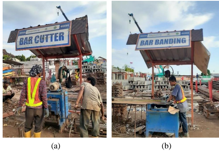
Gambar 4.19 (a) Proses Pemotongan Tulangan dan (b) Pembengkokan Besi Tulangan
