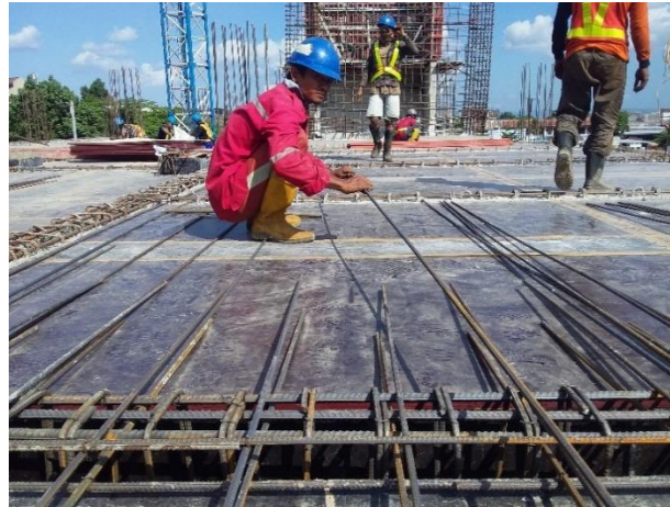
Gambar 4.35 Penulangan Pelat Lantai
