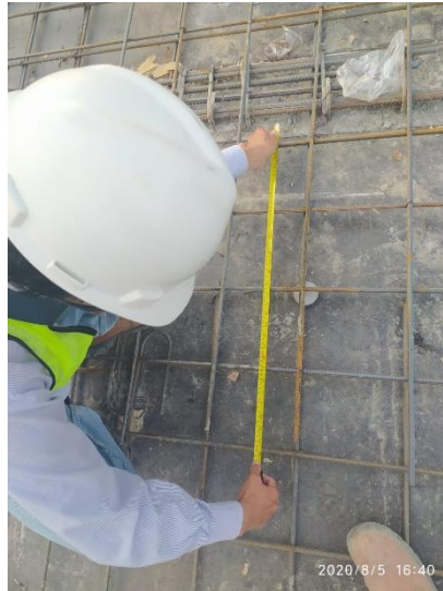
Gambar 4.36 Pengecekan Tulangan Pelat Lantai Pada Tumpuan
