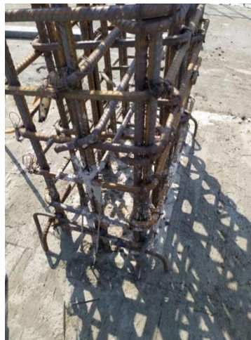
Gambar 4.22 Proses Pengencangan Area Sambungan dengan Sengkang dan Bendrat
