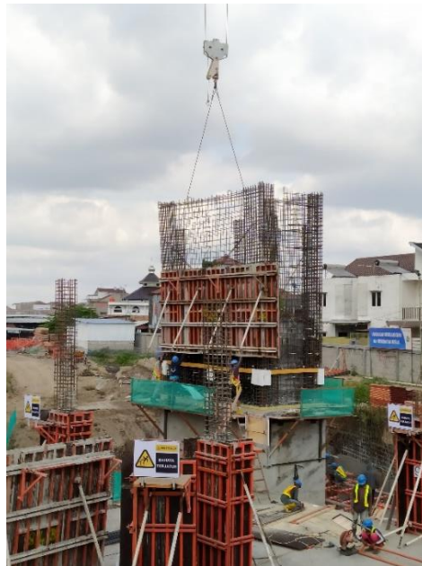
Gambar 4.58 Pemasangan Bekisting Sistem Shear Wall
