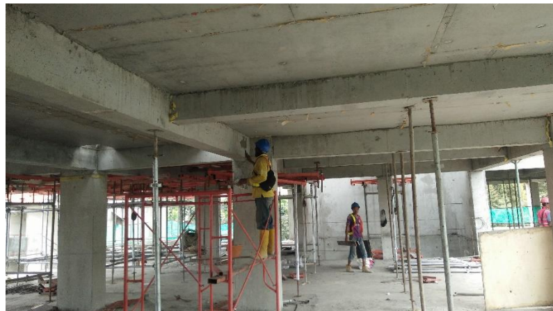
Gambar 4.43 Proses Skim Coat Kolom, Balok dan Pelat
