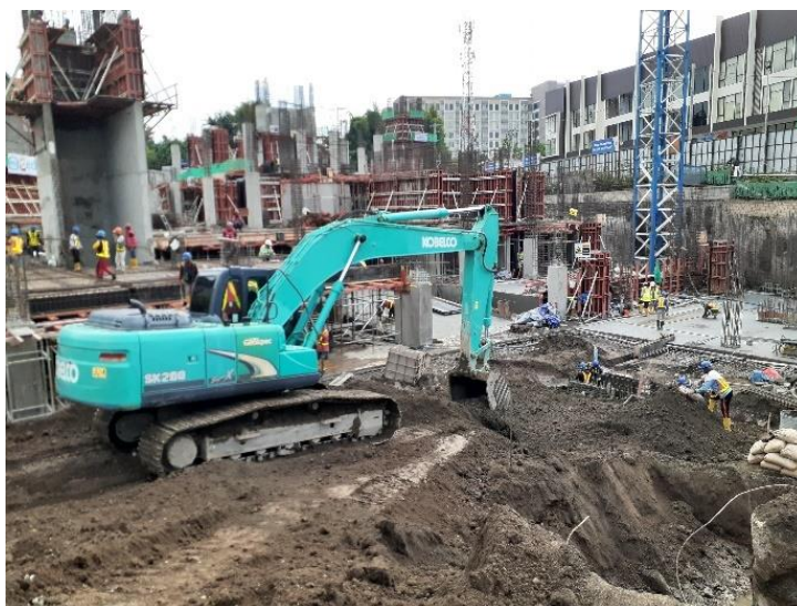
Gambar 4.3 Excavator atau Bego
