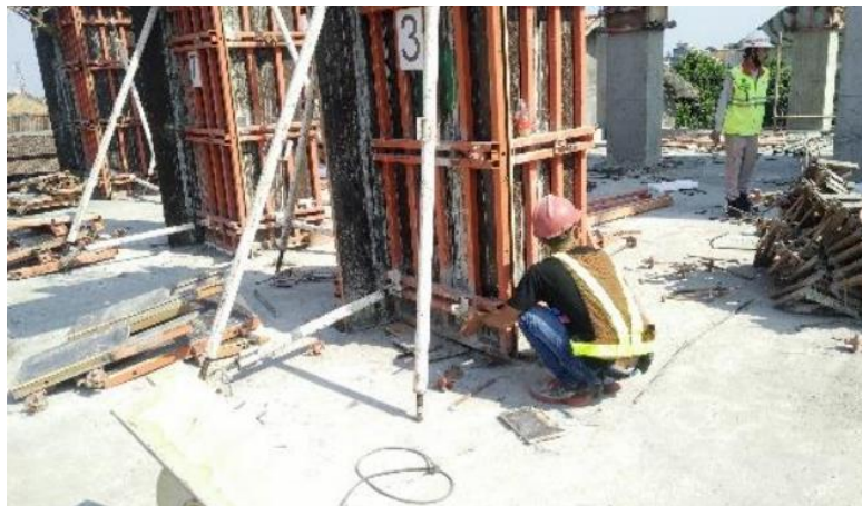
Gambar 4.28 Proses Pengenduran Penyangga pada Bekisting Kolom
