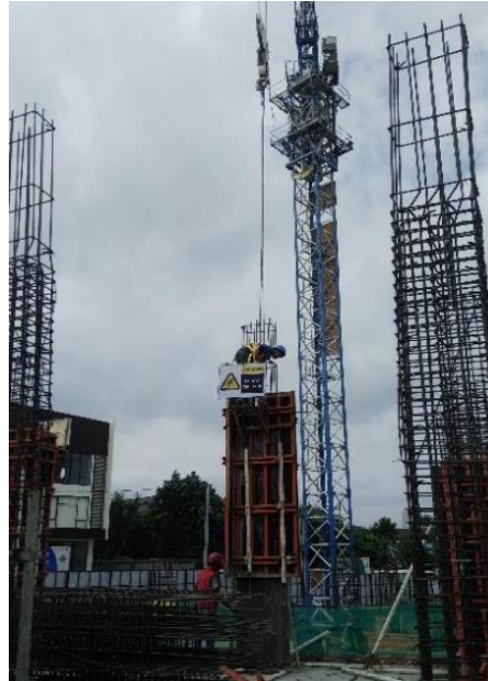
Gambar 4.29 Proses Pengangkatan Bekisting Kolom
