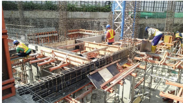
Gambar 4.33 Pemasangan Bekisting Balok
