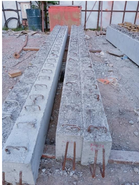
Gambar 4.47 Balok Precast Solid (Balok Anak)
