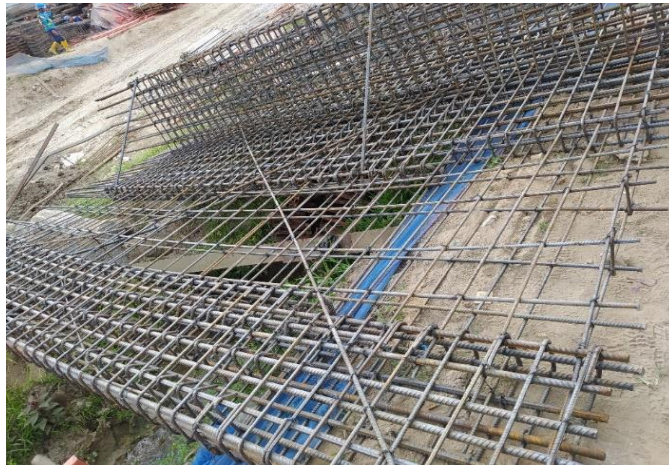
Gambar 4.50 Perancangan Tulangan Shear Wall
