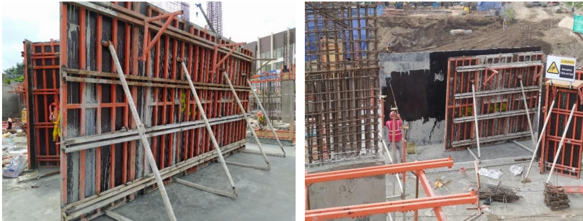
Gambar 4.57 Bekisting Sistem dan Pelapisan Oli pada Bekisting Sistem
