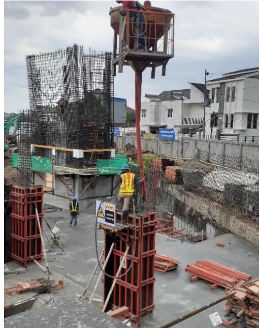
Gambar 4.27 Proses Pengecoran Kolom
