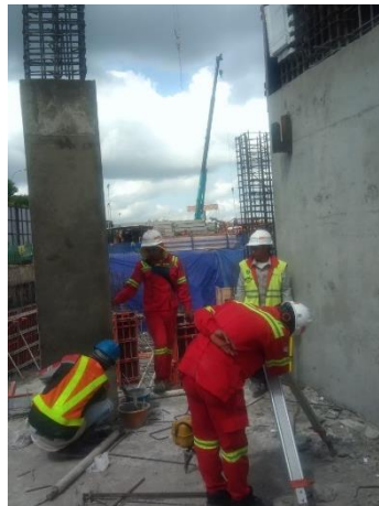
Gambar 4.18 Pengukuran As Kolom dengan Theodolite dan Waterpass
