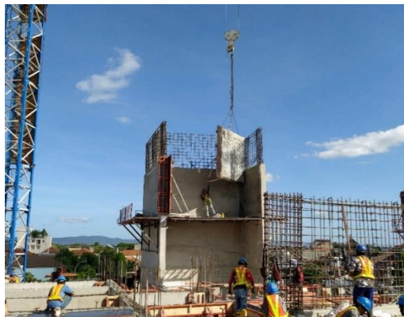
Gambar 4.60 Pembongkaran Bekisting Sistem Shear Wall
