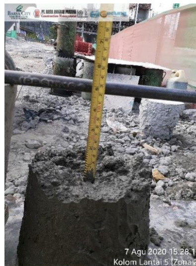
Gambar 4.26 Pengecekan Nilai Slump Sebelum Pengecoran Kolom
