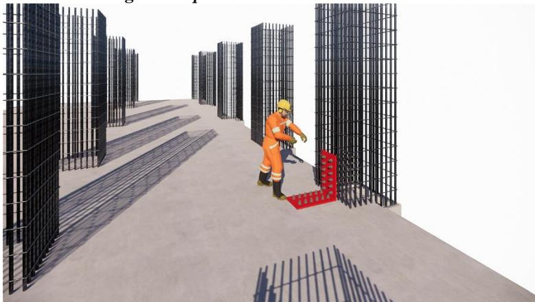
**Gambar 8.4** Pemasangan Baseplate pada Kolom
