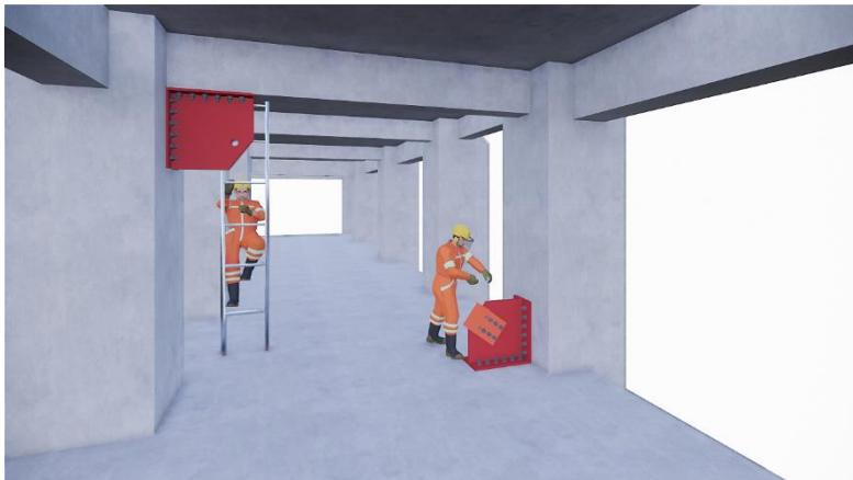
**Gambar 8.5** Pemasangan Gusset Plate
