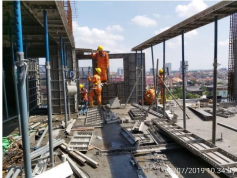
Gambar 4.2 Pekerjaan Pemasangan Bekisting Pelat Lantai Aluminium Formwork
