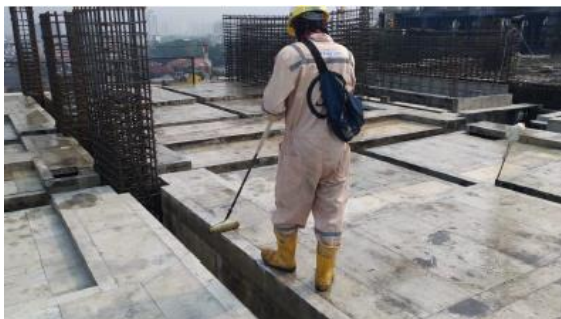
Gambar 4.11 Pengolesan Minyak Aluminium Formwork Sumber: Dokumen PT. PP
