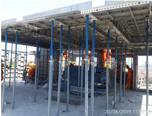
Gambar 4.10 Proses Pemasangan Panel Pelat Horizontal Sumber : Dokumen PT. PP Grand Dharmahusada Lagoon
