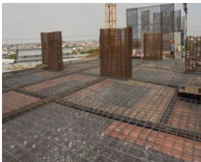
Gambar 4.22 Pemasangan Pelat Metode Table Formwork [25]
