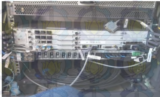
Gambar 2.10 Perangkat BBU ( Baseband Unit )
