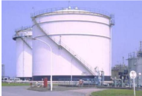
Gambar 8 Tangki Jenis Dome Roof Tank
