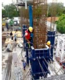
Gambar 7.14 Pengerojokan Ready Mix
