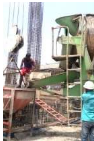
Gambar 7.13 Penuangan Ready Mix
