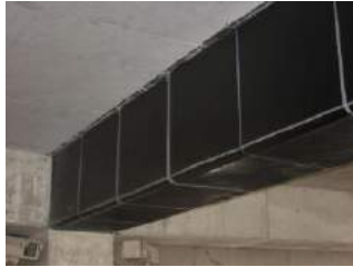
Gambar 7.28 Hasil Pemasangan Sika Wrap
