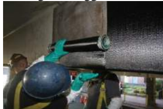
Gambar 7.26 Pemasangan Sika Wrap
