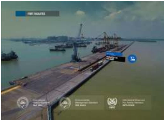
Gambar 1. 3 Kondisi Operasional Dermaga Domestik
