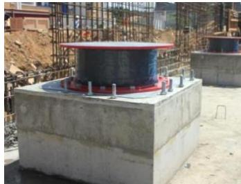
**Gambar 10-14.** Pemasangan Top Plate
