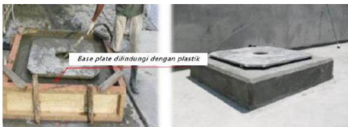
**Gambar 10-8.** Pengecoran Kolom Pedestal Bawah
