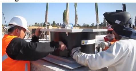
**Gambar 10-13.** Pemasangan Baut Bawah
