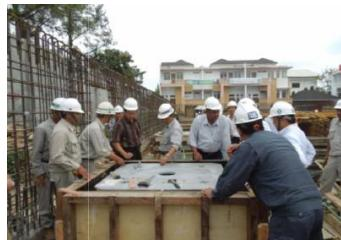
**Gambar 10-7.** Pemasangan Bekisiting Kolom Pendestal Bawah
