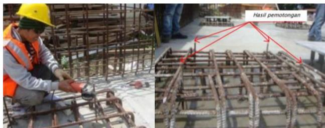
**Gambar 10-4.** Pemotongan Besi Dudukan Base Plate
