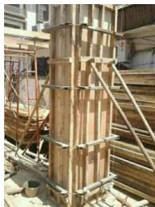
**Gambar 5. 23** pemasangan bekisting
