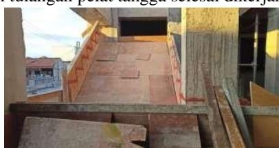
**Gambar 5. 33** Pemasangan Bekisting
