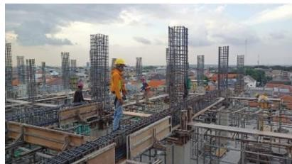
**Gambar 5. 28** Pemasangan Bekisting Balok
