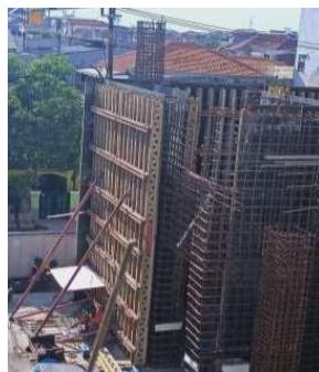
**Gambar 5. 5** Pemasangan Bekisting
