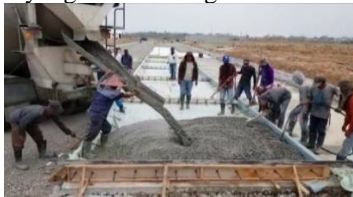
Gambar 6.6. Stabilisasi dengan LMC
