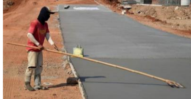
Gambar 6.12. Pembentukan Alur Jalan Sumber : www.google.com
