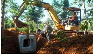
Gambar 6.4. Pemasangan U-ditch
