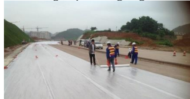
Gambar 6.14. Pemasangan geotextile Sumber : www.google.com
