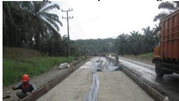
Gambar 6.9. Pemasangan Bekisting
