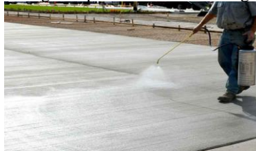
Gambar 6.13. Penyemprotan Curing Compound Sumber : www.google.com
