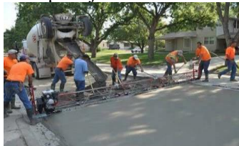
Gambar 6.11. Pengecoran Jalan Beton
