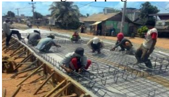
Gambar 6.10. Pemasangan Tie bar dan Dowel
