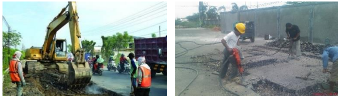
Gambar 6.5. Pembongkaran Perkerasan Lama dengan Excavator (kiri) dan Jack Hammer (kanan)
