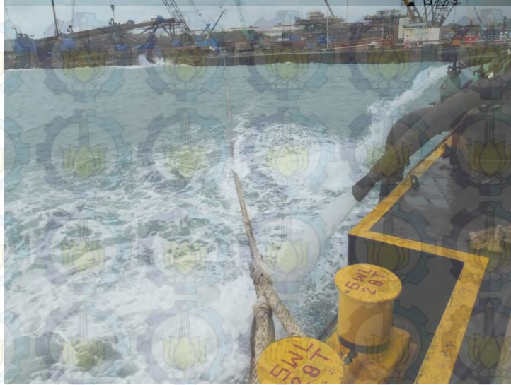
Gambar 4.5. Instalasi mooring pada barge
