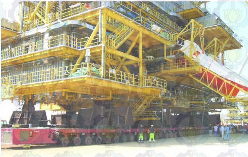
Gambar 2.4. Deck Structure di atas SPMT
