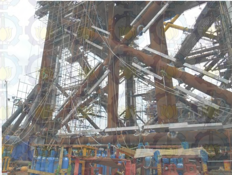
Gambar 4.8. Proses Seafastening pada Jacket C24-P3 Sumber : (PT. XXX)
