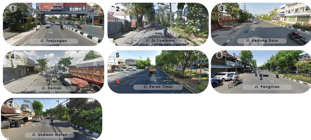
Gambar 4.22 Kondisi jalan Zona C Sumber : Olahan Penulis (2021)
