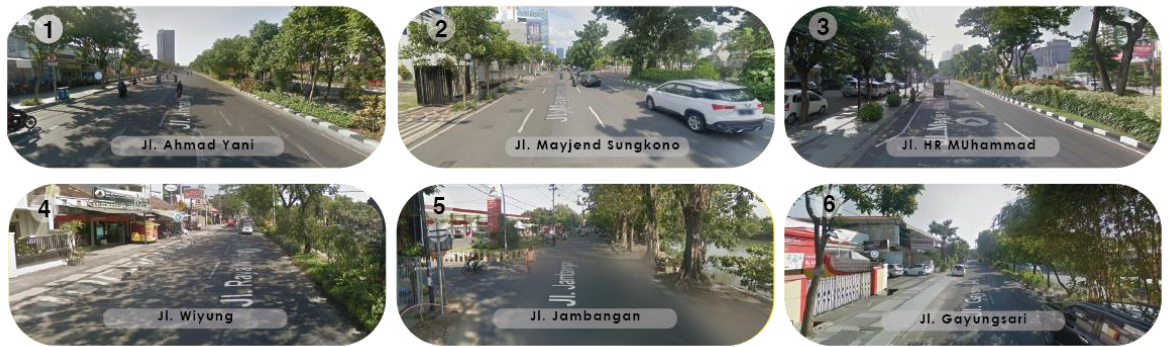
Gambar 4.18 Kondisi jalan Zona A Sumber : Olahan Penulis (2021)
