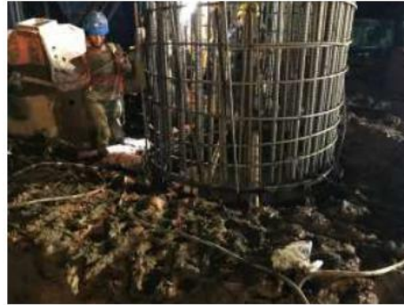
Gambar 4. 9 Pekerjaan pengelasan antar segmen tulangan
