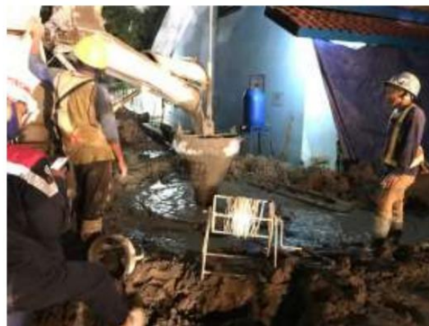
Gambar 4. 10 Pekerjaan pengecoran menggunakan concrete mixer truck dan pipa tremie
