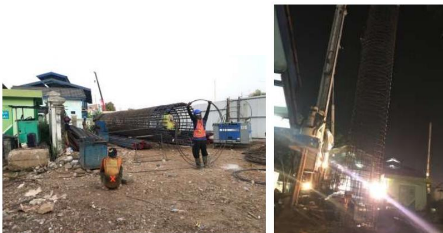
Gambar 4. 8 Pekerjaan pembesian dan pemasangan pembesian tulangan bored pile
