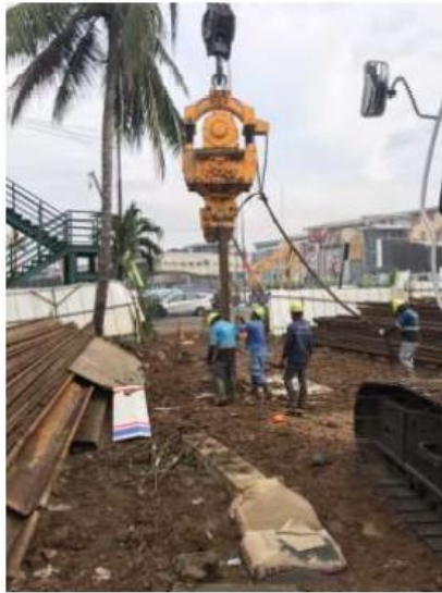
Gambar 4. 12 Pekerjaan pemancangan SSP menggunakan free hanging
