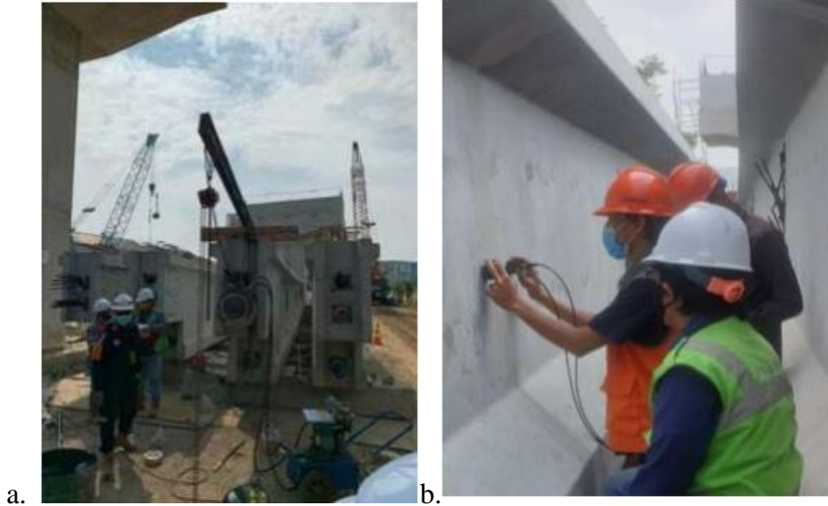
Gambar 4. 37 a. Stressing b. Tes UPV girder setelah stressing
