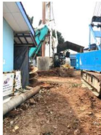
Gambar 4. 6 a. Pekerjaan Pre-Boring b. Pekerjaan Installing Casing
