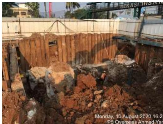
Gambar 4. 13 Galian tanah untuk pekerjaan pile cap
