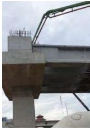
Gambar 4. 43 Pengecoran diafragma menggunakan concrete pump
