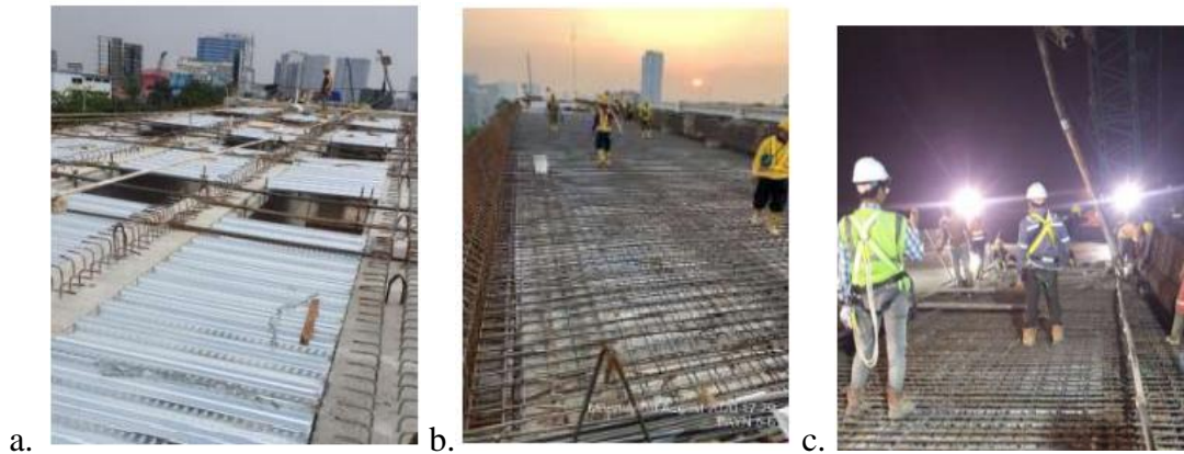
Gambar 4. 44 a. Pemasangan steel deck b. Pembesian slab c. Pengecoran slab menggunakan concrete pump
