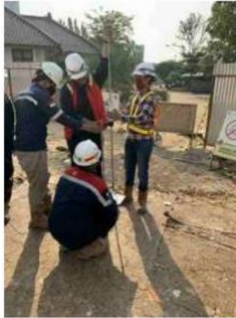
Gambar 4. 28 Pekerjaan Test DCP
