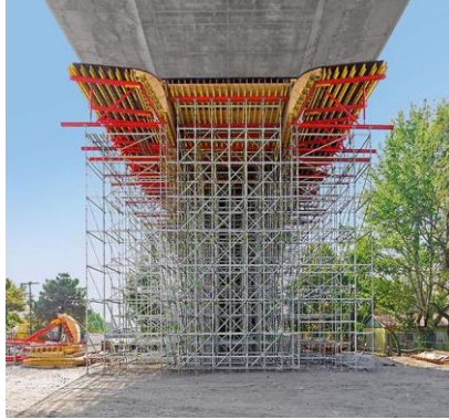
Gambar 4. 24 Pemasangan shoring , scaffolding , dan baseform
