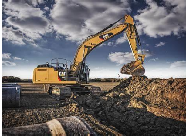
Gambar 4. 2 Pembersihan lingkungan kerja dengan excavator
