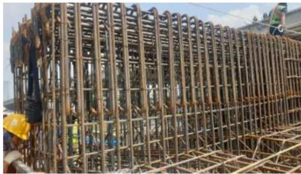
Gambar 4. 25 Penulangan pada pier head
