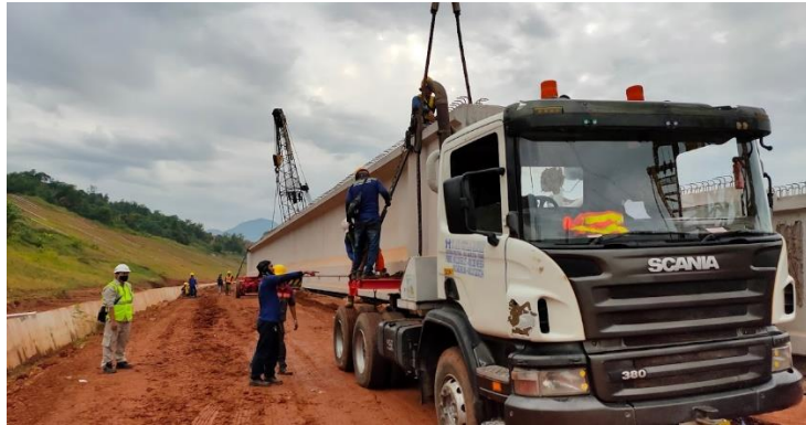
Gambar 4. 39 Mobilisasi girder ke titik erection
