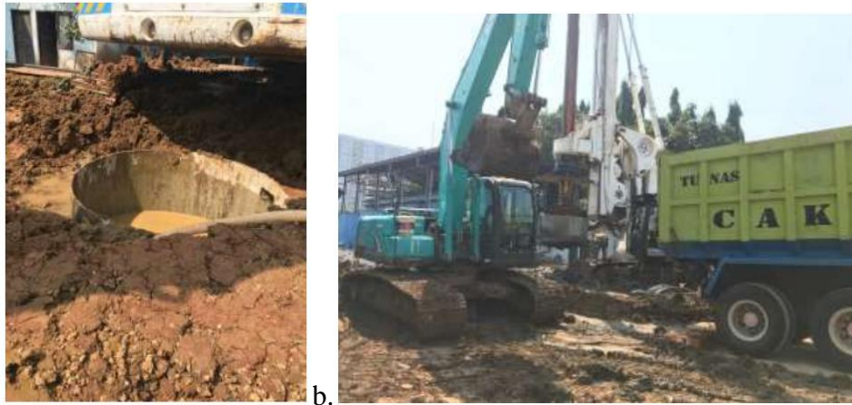
Gambar 4. 7 a. Lubang galian bored pile dengan temporary casing . b. Pengangkutan tanah hasil galian menggunakan excavator dan dump truck
