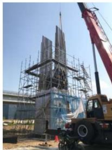
Gambar 4. 19 Penulangan pier menggunakan service crane
