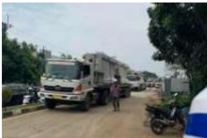
Gambar 4. 30 Mobilisasi girder segmental menggunakan truk trailer
