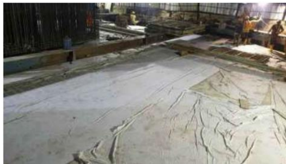
Gambar 4. 17 Pekerjaan curing pile cap menggunakan geotextile nonwoven yang disiram air
