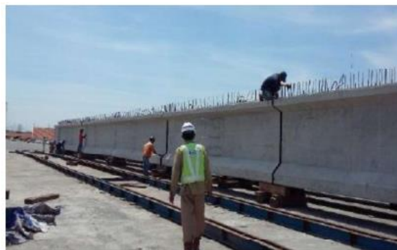
Gambar 4. 36 Pekerjaan pengeleman celah segmen girder
