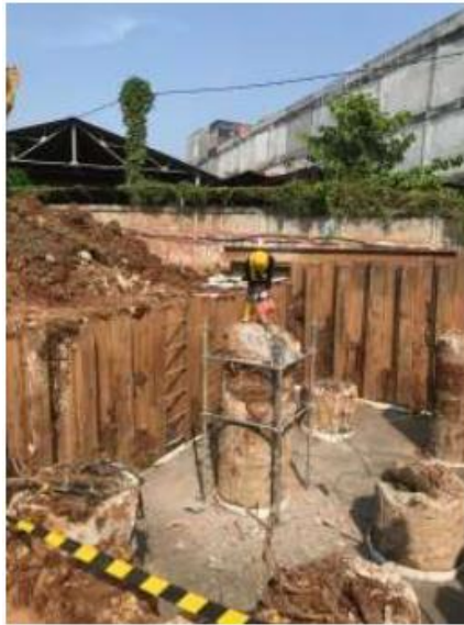
Gambar 4. 14 Pekerjaan pembobokan kepala bored pile
