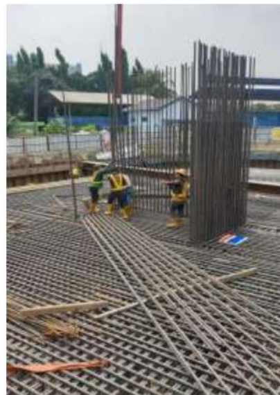
Gambar 4. 15 a. Pekerjaan pembesian untuk pile cap b. pembesian lewatan pembesian pier
