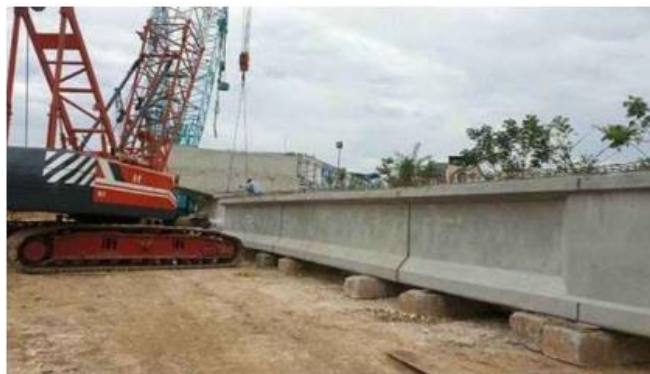
Gambar 4. 33 Setting girder menggunakan mobile crane
