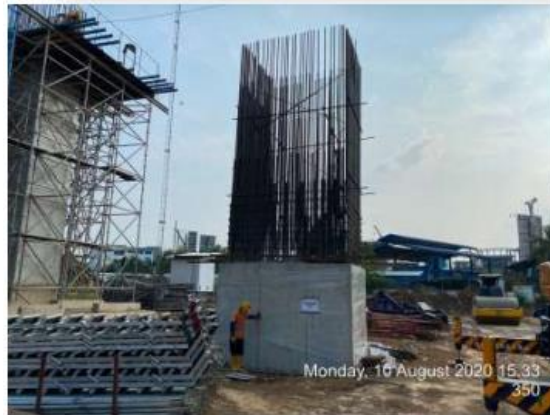
Gambar 4. 22 Pelapisan pier menggunakan plastik
