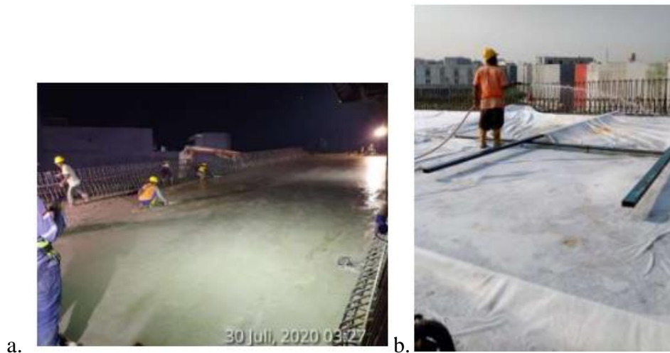
Gambar 4. 45 Pekerjaan a. grooving b. curing pada slab
