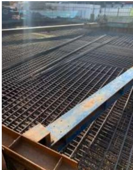
Gambar 4. 15 a. Pekerjaan pembesian untuk pile cap b. pembesian lewatan pembesian pier
