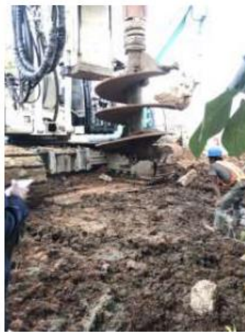
Gambar 4. 6 a. Pekerjaan Pre-Boring b. Pekerjaan Installing Casing
