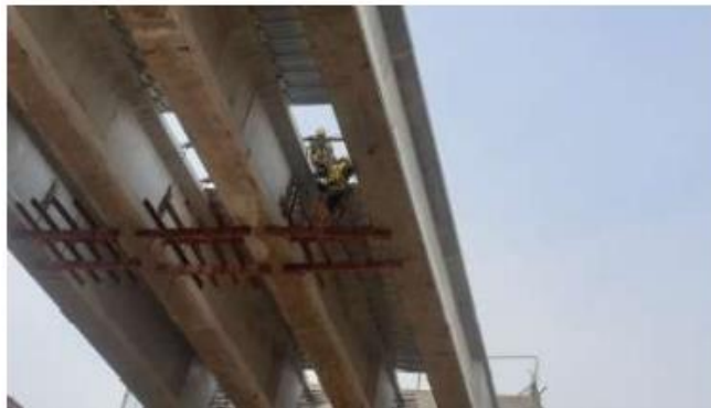
Gambar 4. 41 Pemasangan bekisting diafragma
