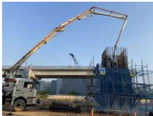
Gambar 4. 21 Pengecoran pier menggunakan concrete pump
