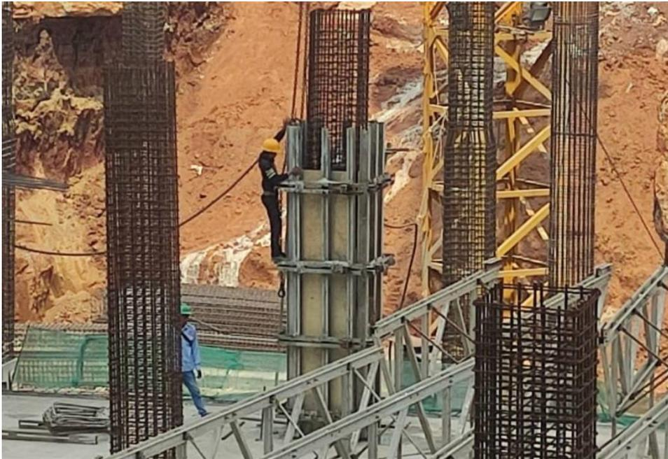
*Gambar 3.21 Pengangkatan Bekisting Kolom dengan tower crane(Sumber : Dokumentasi Penulis)*
