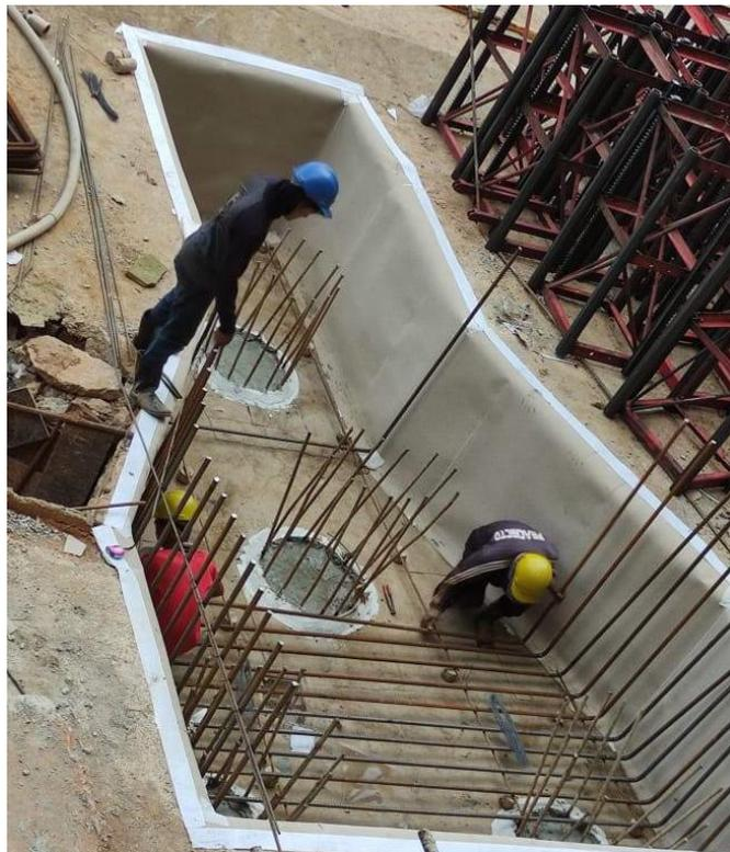
*Gambar 3.9 Ilustrasi Waterproofing Pile Cap (Sumber : Dokumentasi Penulis)*
