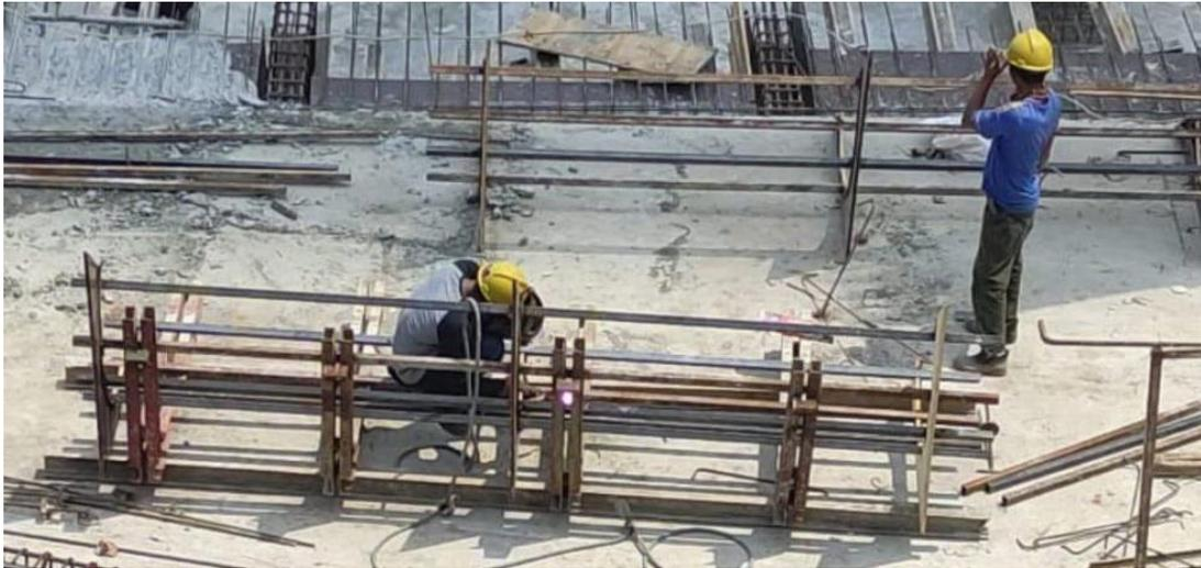
*Gambar 3.16 Fabrikasi Bekisting Kolom (Sumber : Dokumentasi Penulis)*
