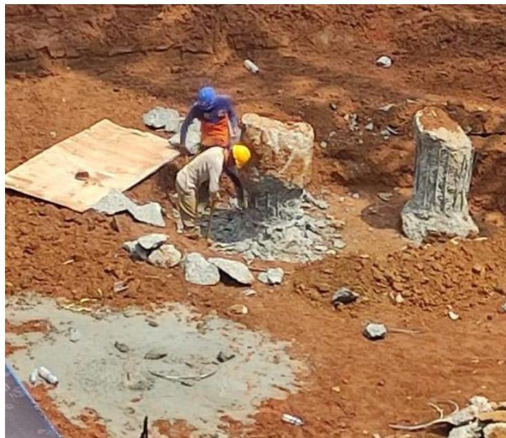
Gambar 3.3 Pemotongan Bore Pile (Sumber : Dokumentasi Penulis)
