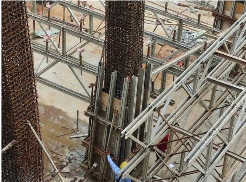
*Gambar 3.20 Pelepasan Bekisting Kolom (Sumber : Dokumentasi Penulis)*
