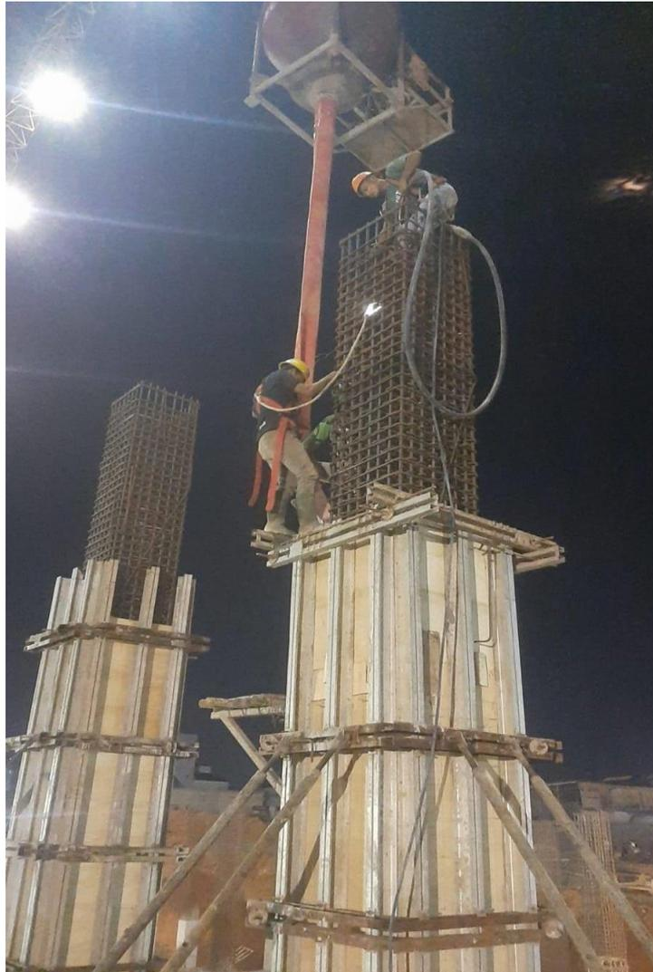
*Gambar 3.19 Pengecoran Kolom dengan Bucket dan Tremi(Sumber : Dokumentasi Penulis)*
