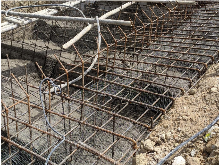
Gambar 3.4 Pemasangan bekisting & pembesian dinding pelimpah
