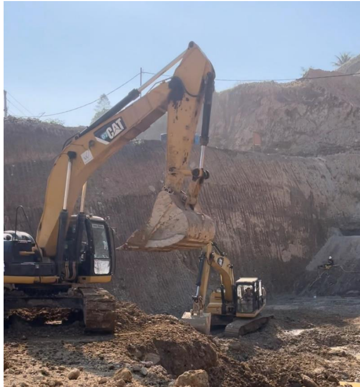
Gambar 3.9 Penggalian menggunakan excavator dengan hydraulic breaker
