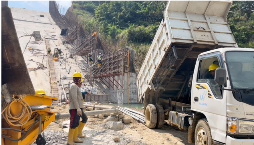
Gambar 4.22 Proses pemasangan pipa baja
