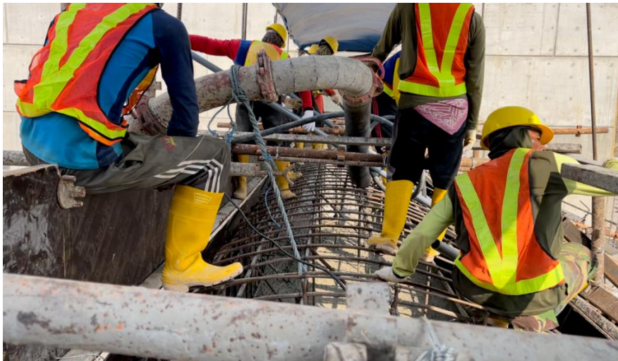
Gambar 4.33 Proses pengecoran bersamaan dengan perataan dengan vibrator
