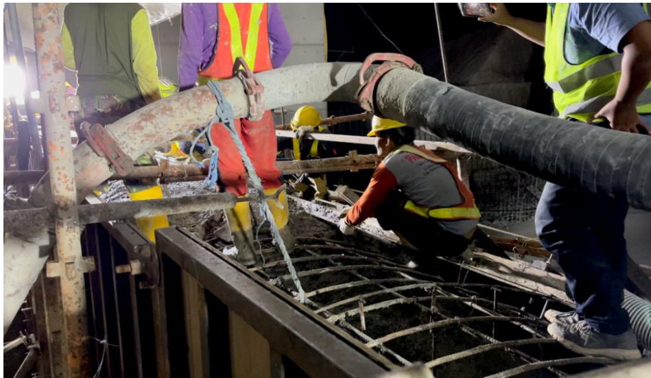
Gambar 4.35 Proses pengecoran pada mercu
