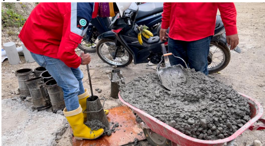
Gambar 4.24 Slump test di lokasi pengecoran
