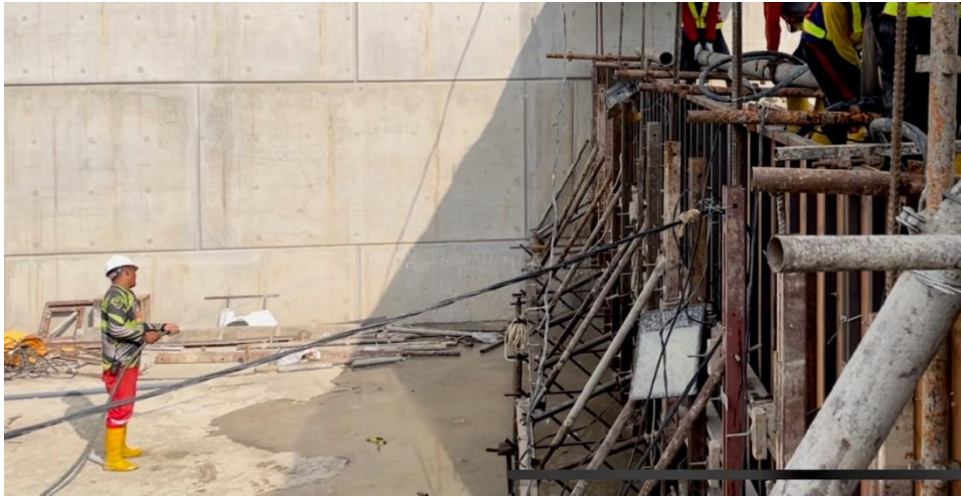
Gambar 4.34 Penyiraman dinding bekisting dengan air
