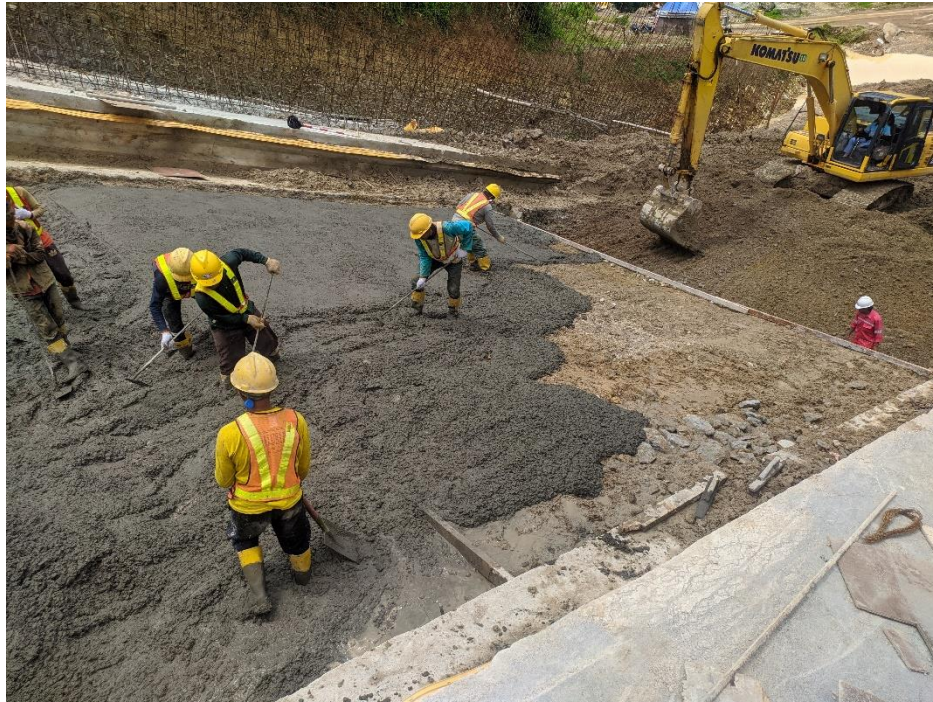
Gambar 3.6 Pengecoran lean concrete pada lantai pelimpah
