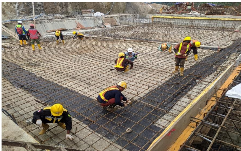
Gambar 3.7 Pemasangan bekisting dan pembesian lantai pelimpah
