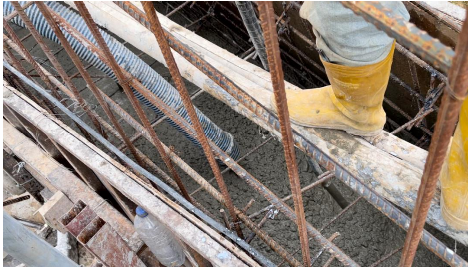
Gambar 4.25 Proses pengecoran sekaligus perataan menggunakan vibrator
