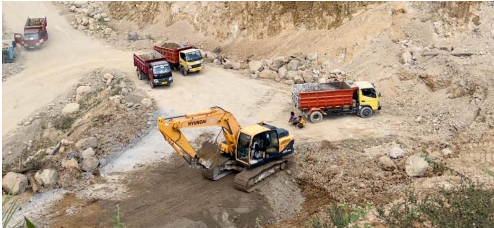
Gambar 4.4 Pemindahan galian dengan excavator dan dumptruck
