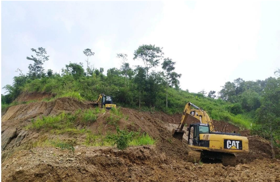
Gambar 3.8 Pekerjaan galian yang bergerak dari arah hulu ke hilir
