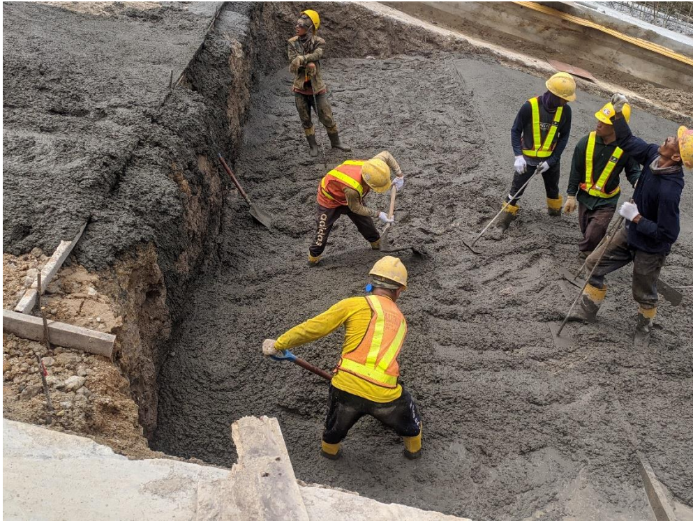
Gambar 3.3 Pengecoran lean concrete pada dinding pelimpah
