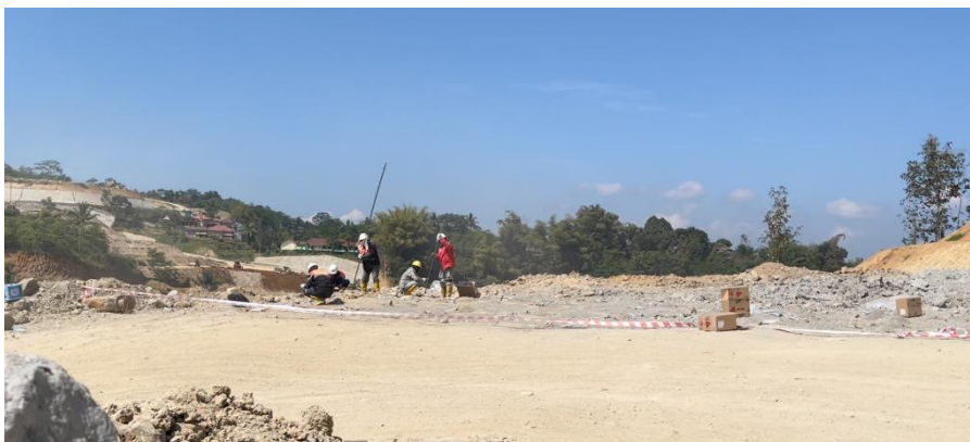
Gambar 4.10 Pembatasan lokasi blasting
