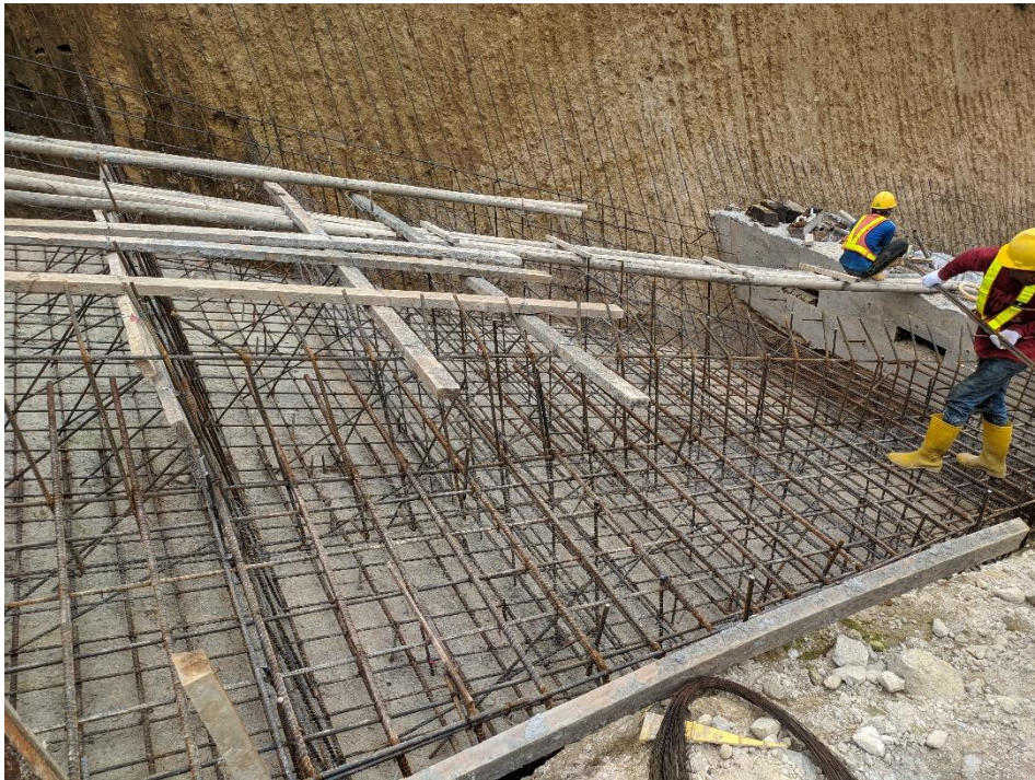
Gambar 3.2 Pemasangan angkur 25 mm di bawah pondasi pelimpah
