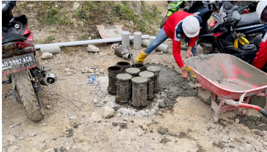
Gambar 4.32 Pengujian slump di lokasi pengecoran
