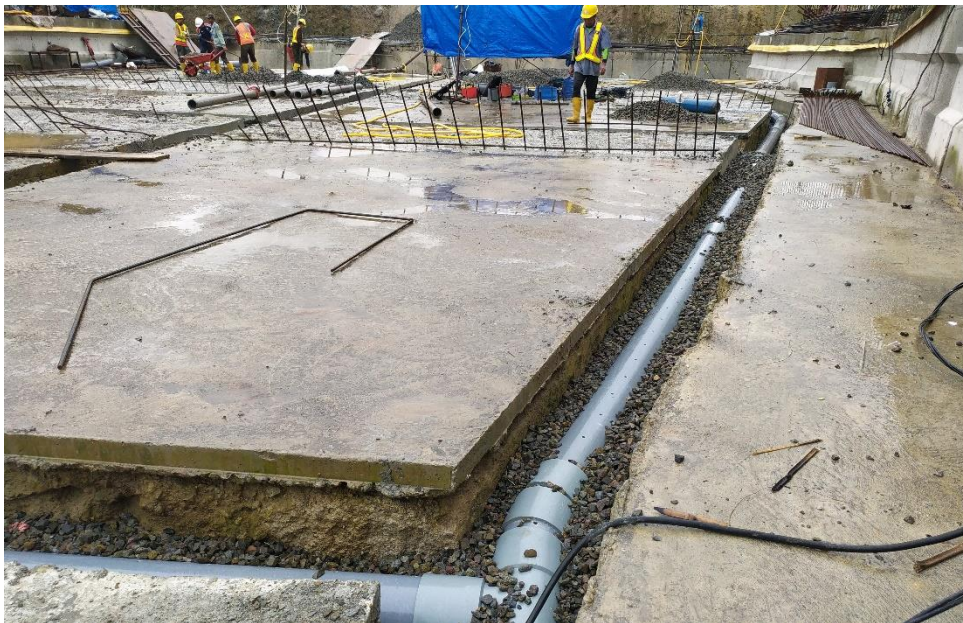
Gambar 3.5 Pemasangan collector drain pada lantai pelimpah
