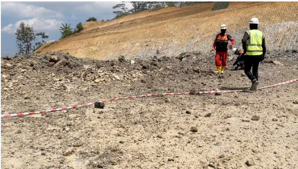
Gambar 4.20 Pengecekan zona blasting
