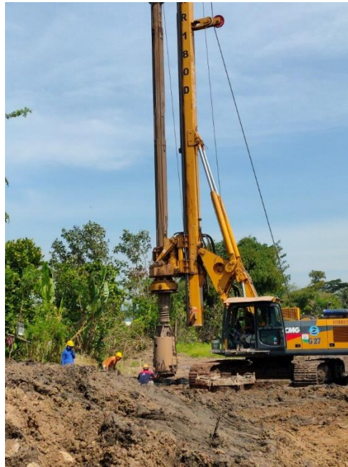
Gambar 4. 9 Pengeboran Bore Pile Menggunakan Mesin Bore Pile
