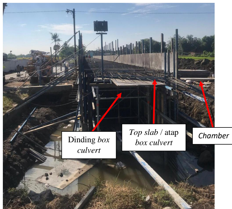
Gambar 7. 2 Pembagian dalam Perhitungan Volume Beton pada Pengecoran Dinding dan Top Slab Box Culvert STA 7+485
