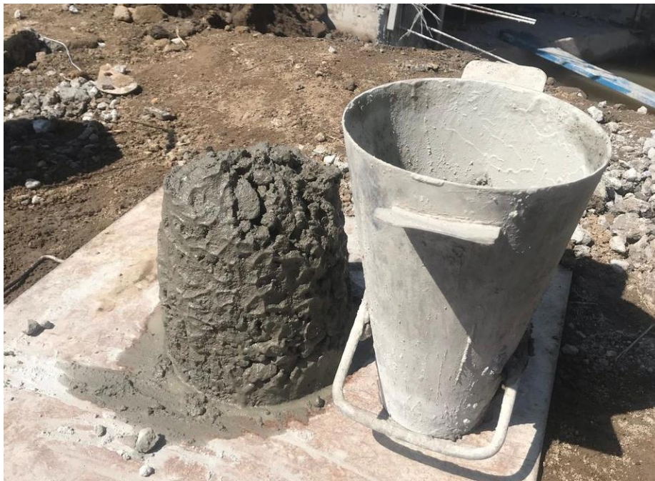
Gambar 4. 4 Pengujian Slump Test pada Beton Segar untuk Pengecoran Box Culvert
