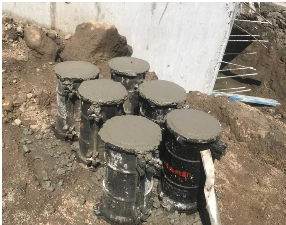
Gambar 4. 3 Sampel Pengujian Beton Menggunakan Silinder
