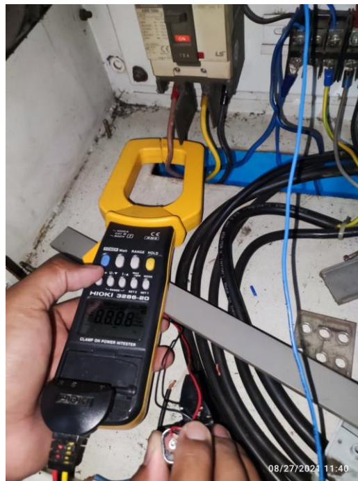
Pengambilan Data Kelistrikan Pompa
