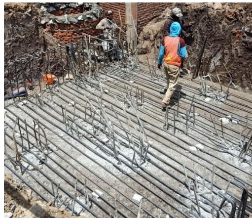
Gambar 4.16 Perakitan tulangan pile cap
