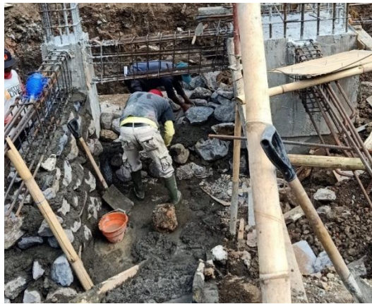
Gambar 4.24 Pemasangan batu kali
