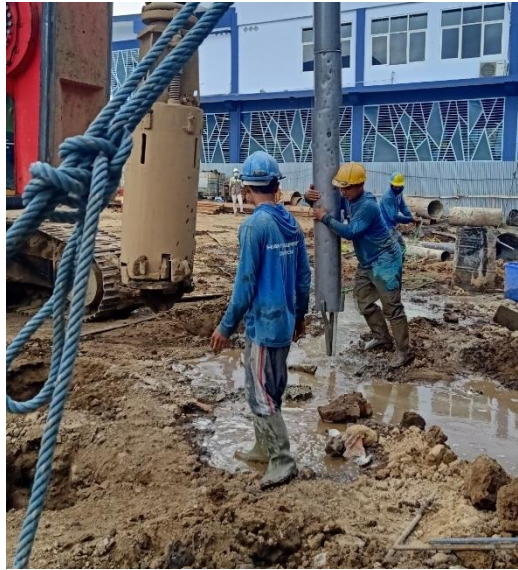
Gambar 5. 12 Pemasangan tremi ke dalam lubang bored pile
