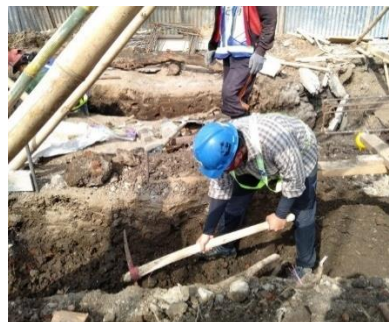
Gambar 4.23 Pekerjaan galian pondasi batu kali
