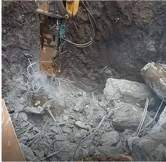
Gambar 4.13 Pembobogan Bored Pile
