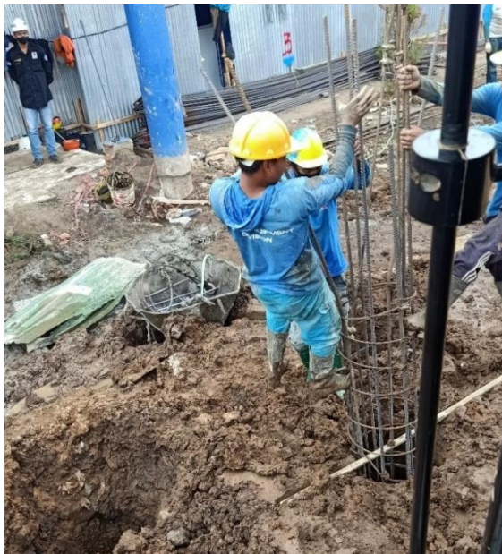
Gambar 4.6 Pemasangan tulangan bored pile
