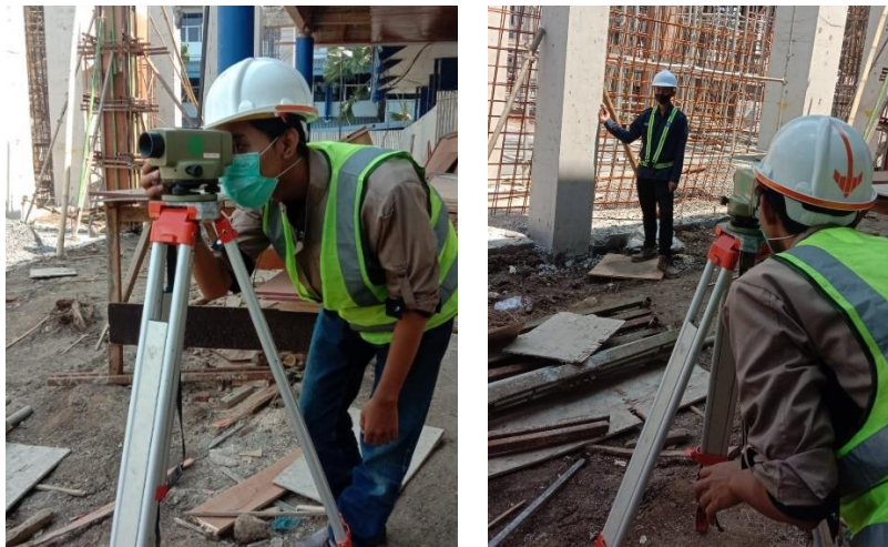
Gambar 4.30 Penggunaan waterpass untuk mengecek elevasi lapangan
