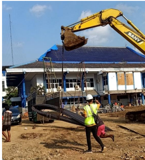
Gambar 7. 7 Pengecekan kedatangan material besi
