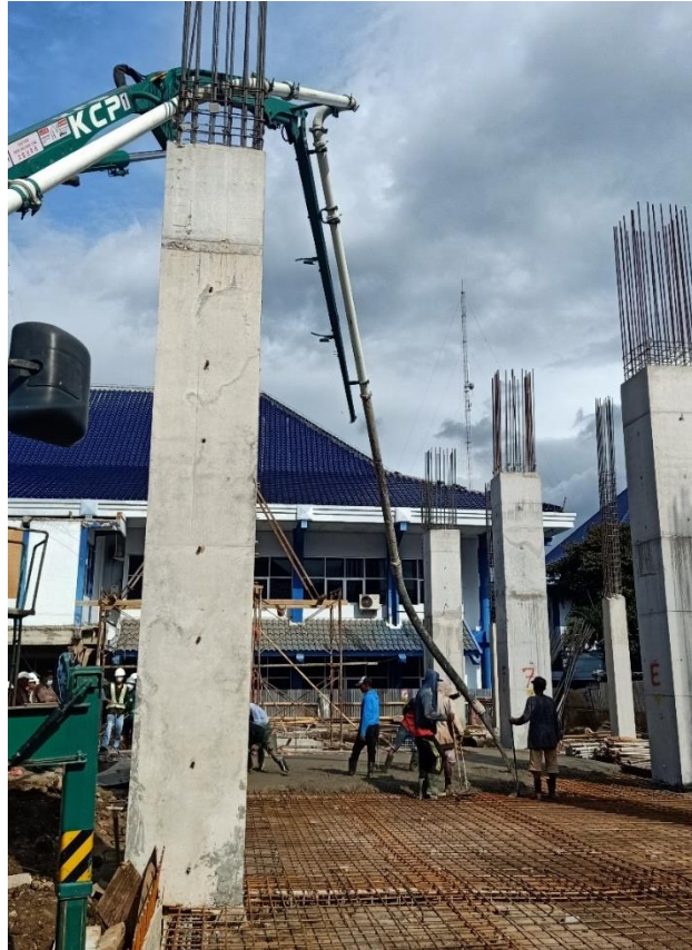
Gambar 4.33 Pengecoran pelat lantai dasar
