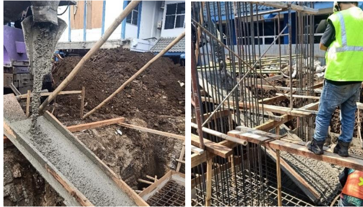
Gambar 4.19 Pengecoran pile cap
