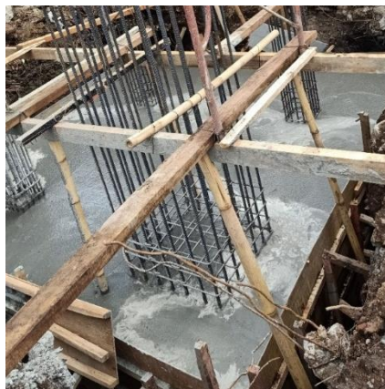
Gambar 4.20 Kondisi pile cap yang sudah dicor
