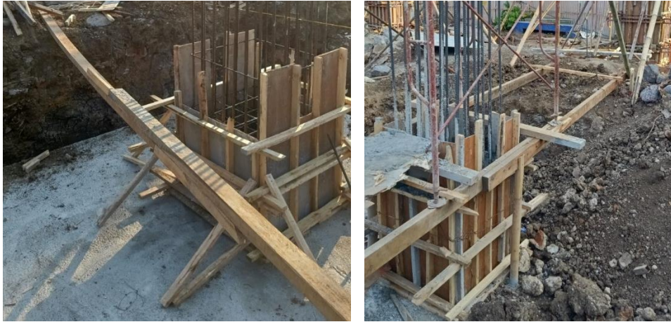
Gambar 4.37 Pemasangan bekisting pada kolom
