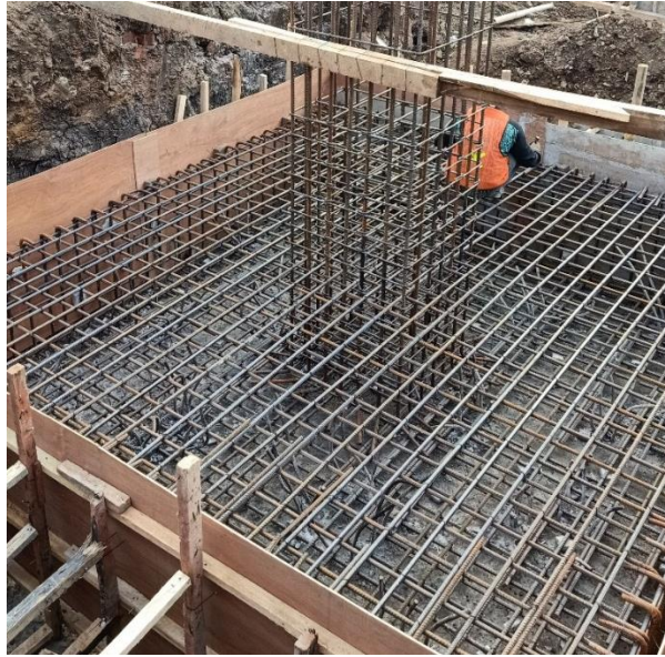
Gambar 4. 17 Pengecekan kondisi bekisting pile cap
