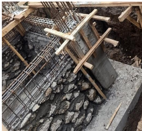
Gambar 4.25 Kondisi batu kali setelah dipasang
