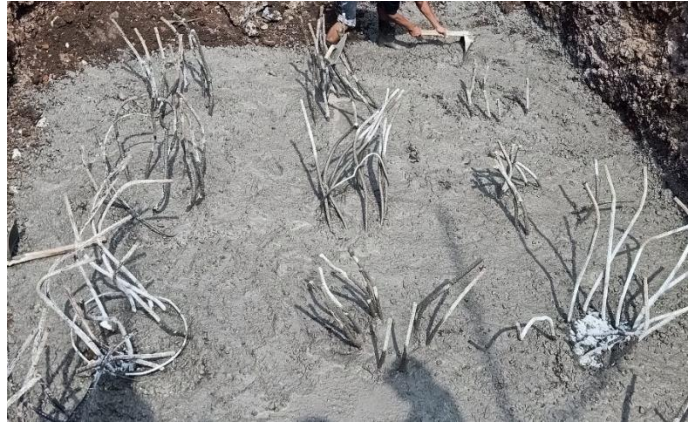
Gambar 4.15 Pemberian lantai kerja beton pile cap
