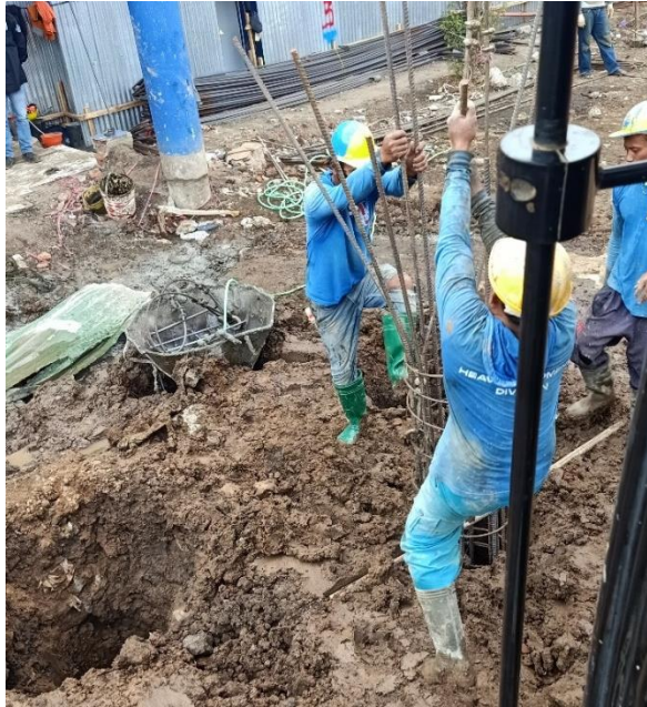
Gambar 4.7 Pembengkokkan tulangan atas bored pile
