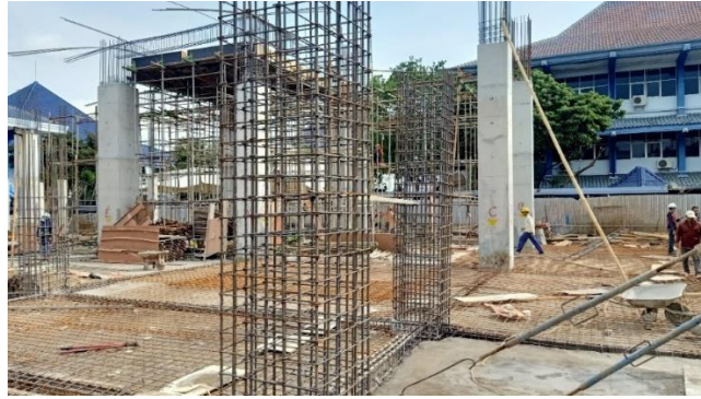
Gambar 4.31 Pemasangan tulangan pelat lantai dasar
