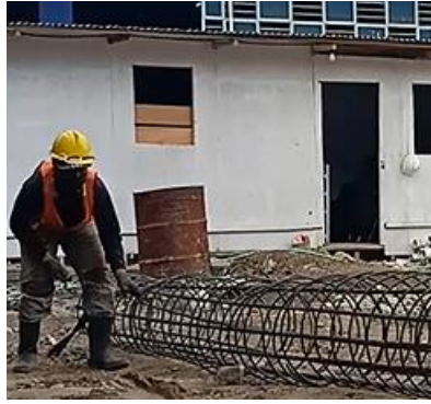
Gambar 5. 7 Perakitan tulangan bored pile
