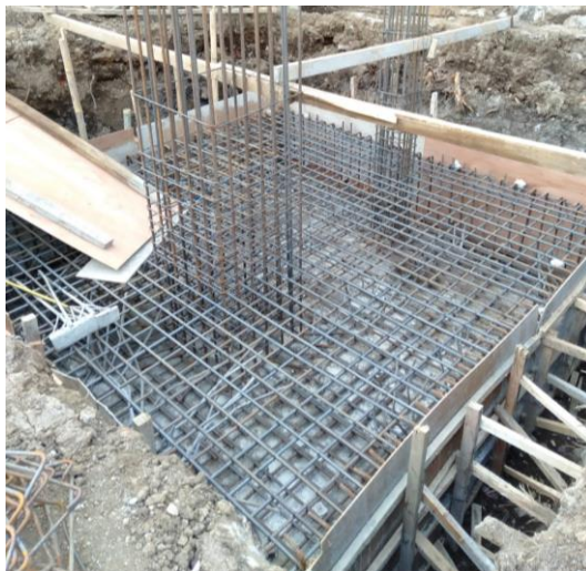
Gambar 4.18 Kondisi pile cap yang siap dicor
