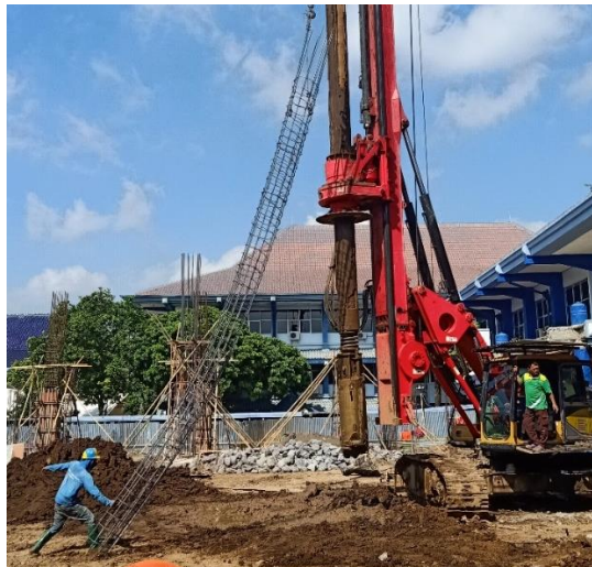
Gambar 5. 8 Pemasangan tulangan bored pile
