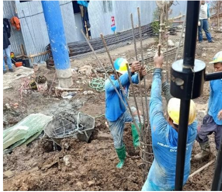
Gambar 5. 9 Pemasangan tulangan bored pile
