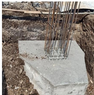
Gambar 4.21 Pile cap yang selesai dicor
