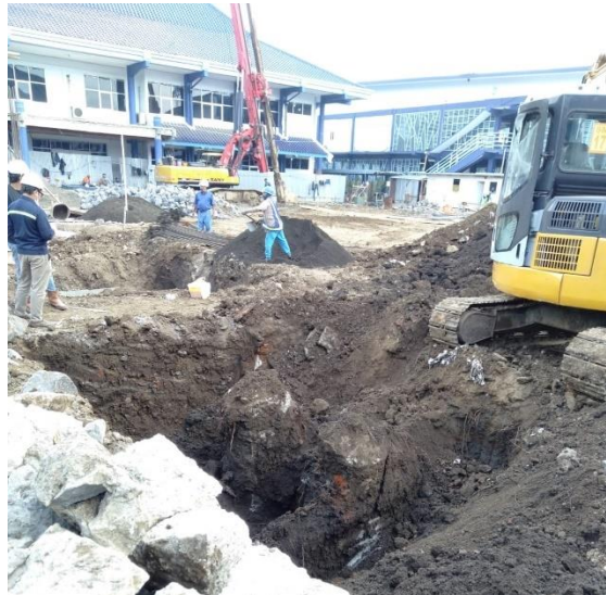
Gambar 4.12 Penggalian lokasi pile cap
