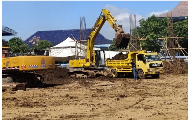
Gambar 4.11 Pemindahan tanah galian ke dump truck
