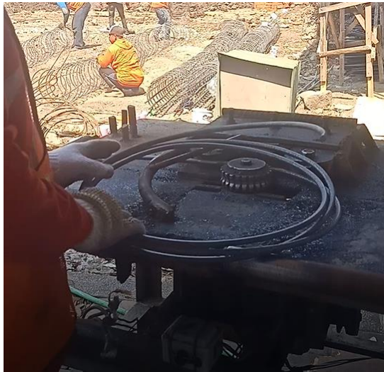
Gambar 5. 5 Pembuatan tulangan spiral bored pile
