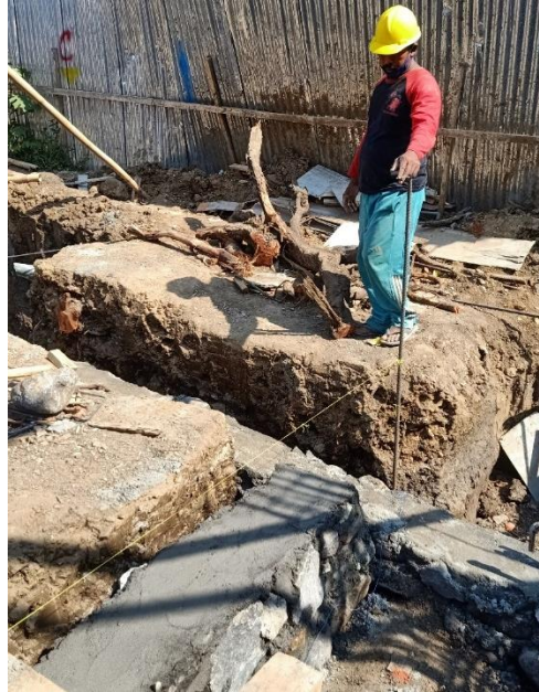
Gambar 4.27 Pemberian lantai kerja untuk sloof
