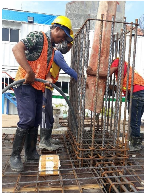
Gambar 3.9 Proses Penuangan dan Penggetaran Beton Segar pada Kepala Kolom dengan Alat Vibrator
