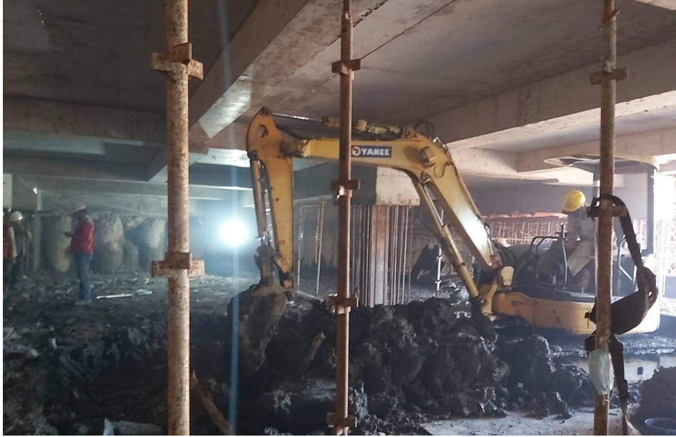
Gambar 3.29 Proses Penggalian Tanah Basement Proyek Apartemen Kyo
