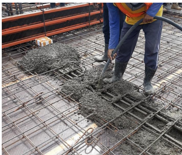
Gambar 3.12 Proses Penggetaran Beton Segar pada Balok menggunakan Alat Vibrator
