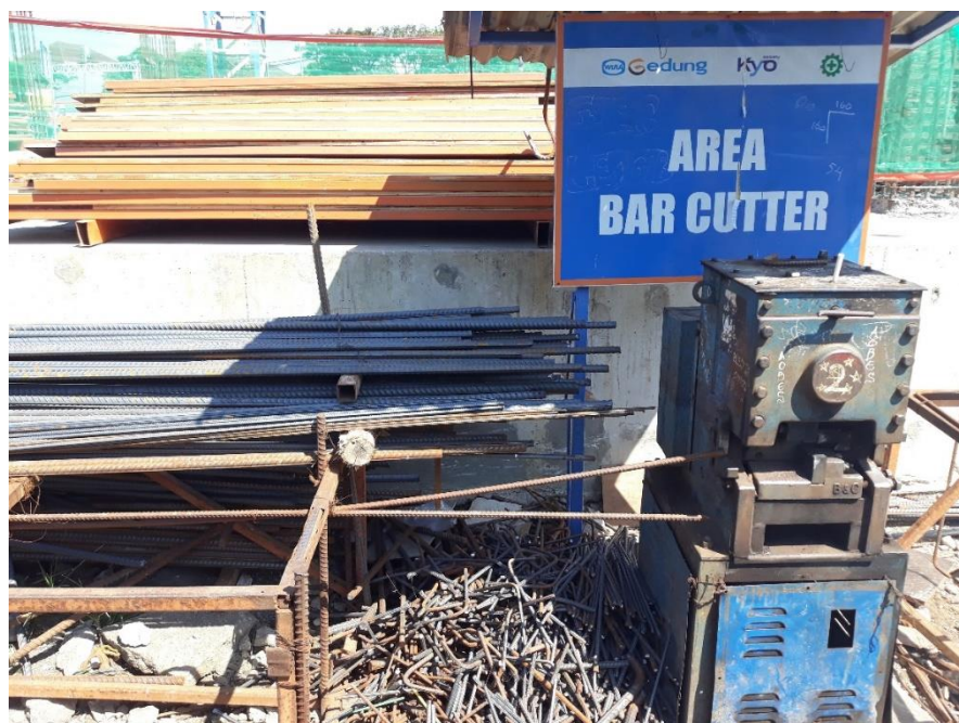
Gambar 2.12 Area Fabrikasi Besi Proyek Apartemen Kyo
