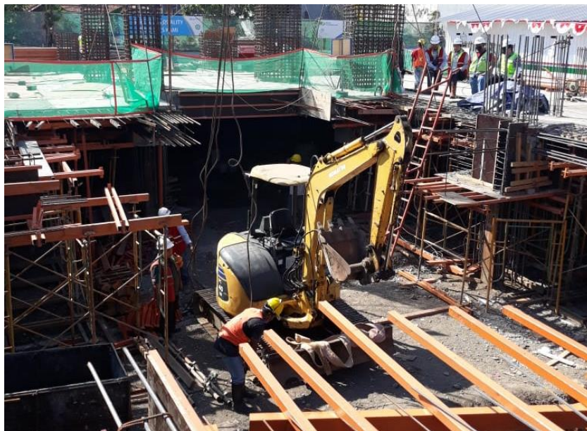
Gambar 3.28 Ekskavator pada Lokasi Galian
