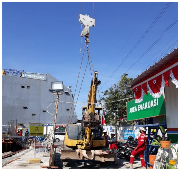
Gambar 3.26 Proses Rigging Tali pada Ekskavator
