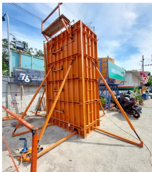
Gambar 3.34 Hasil Bekisting Kolom yang Telah Terakit
