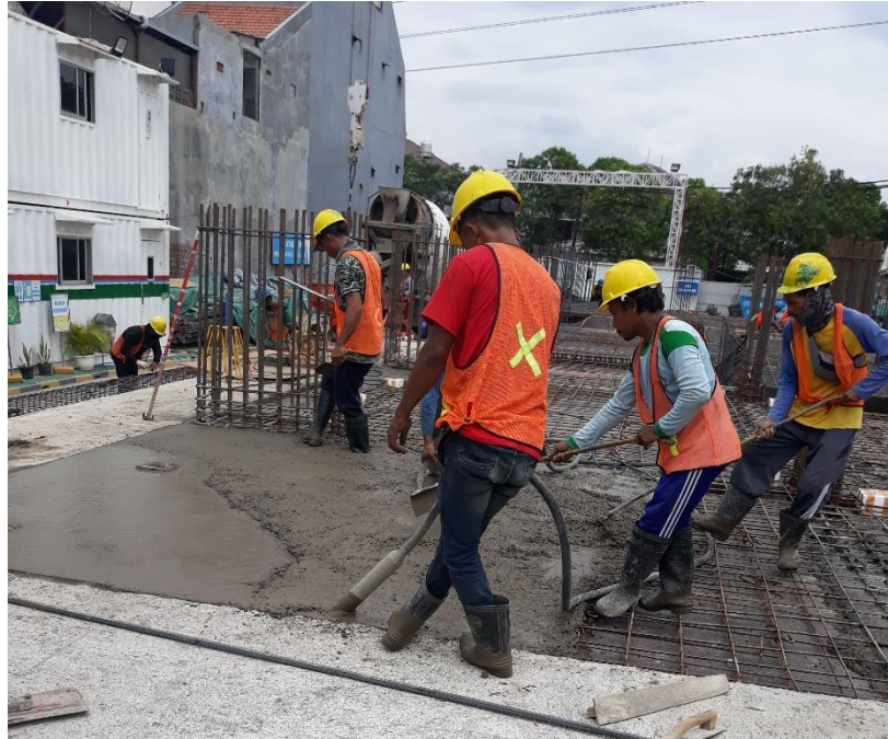
Gambar 3.14 Proses Penggetaran Beton Segar pada Plat Lantai dengan Alat Vibrator
