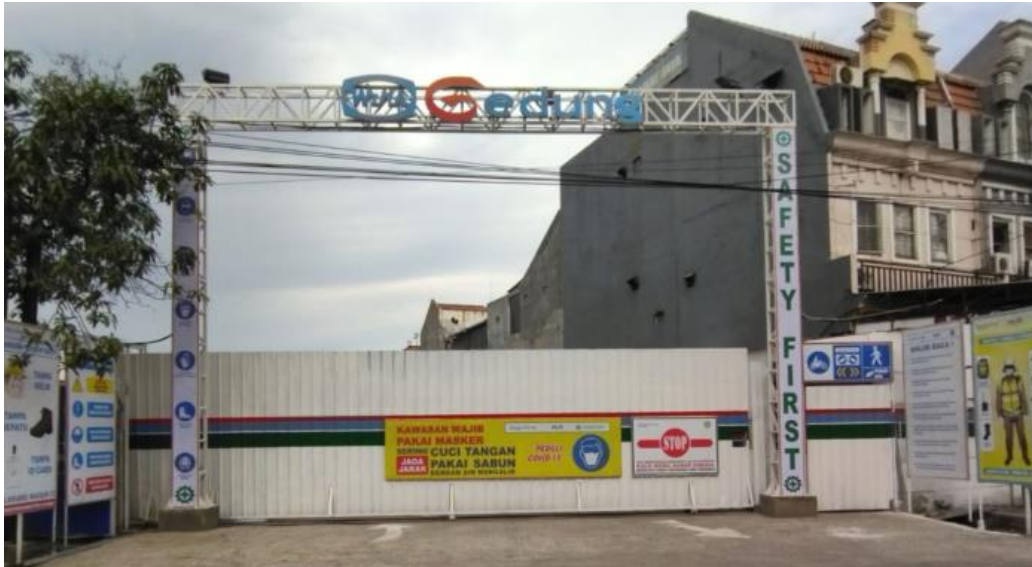
Gambar 2.5 Gerbang Proyek Proyek Apartemen Kyo
