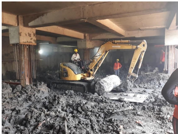
Gambar 3.32 Proses Pembuangan Beton yang Telah Dibobok
