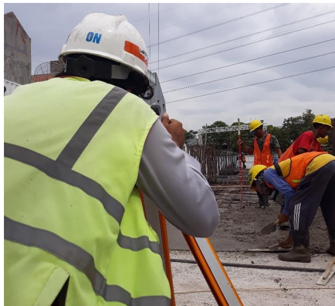
Gambar 3.15 Proses Pemeriksaan Elevasi Beton Segar menggunakan Waterpass
