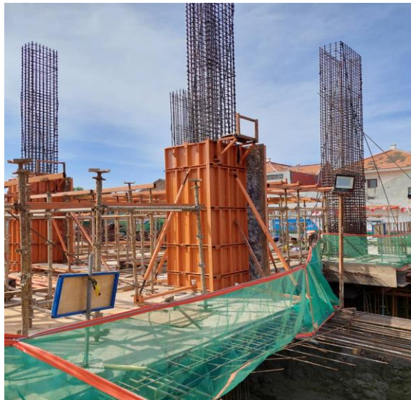
Gambar 3.36 Proses Penyesuaian Bekisting Kolom
