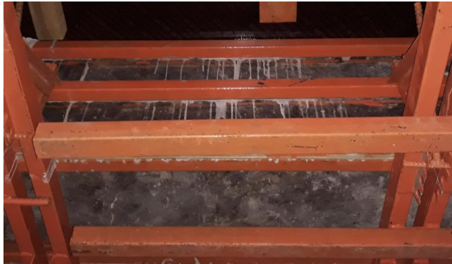
Gambar 3.25 Hollow Bekisting Balok 40x40 cm pada Perancah
