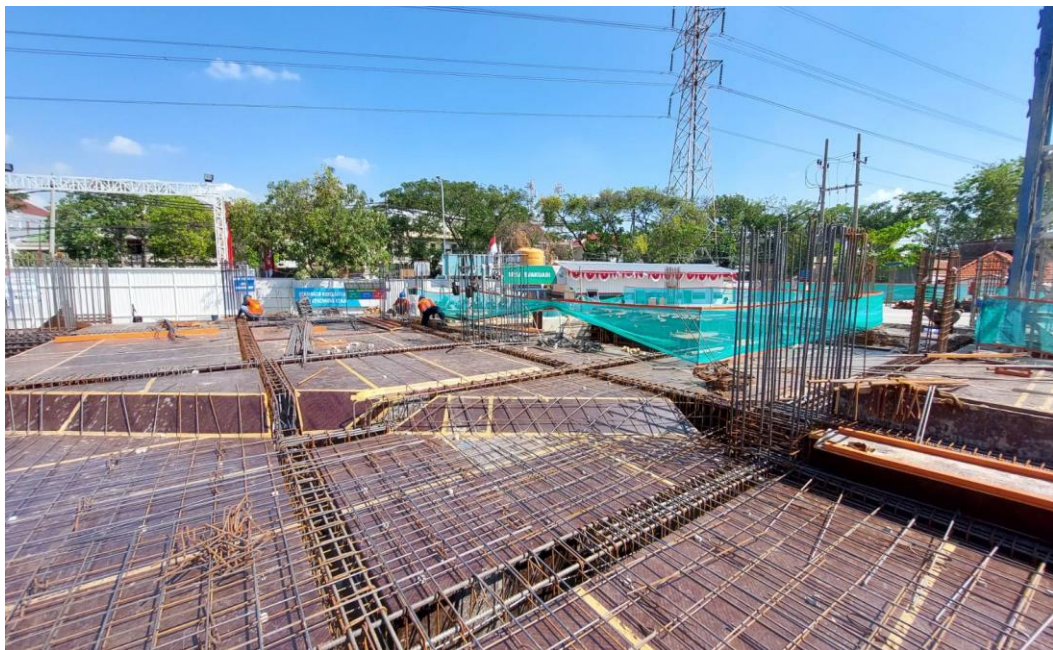
Gambar 3.1 Pekerjaan Penulangan Balok dan Plat Lantai
