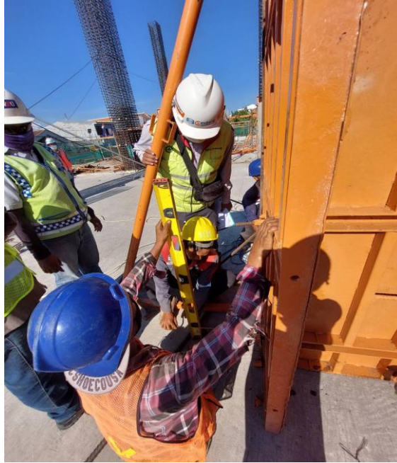
Gambar 3.37 Uji Vertikalitas pada Bekisting Kolom
