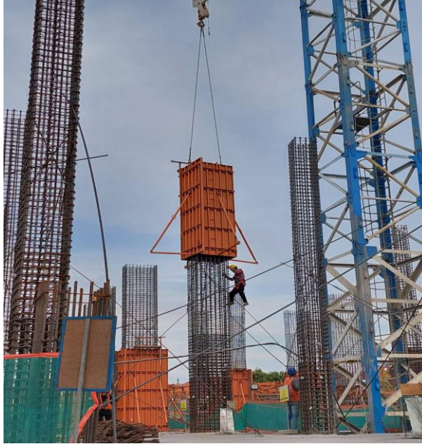
Gambar 3.35 Proses Perletakan Bekisting Kolom ke Tulangan Kolom Eksisting
