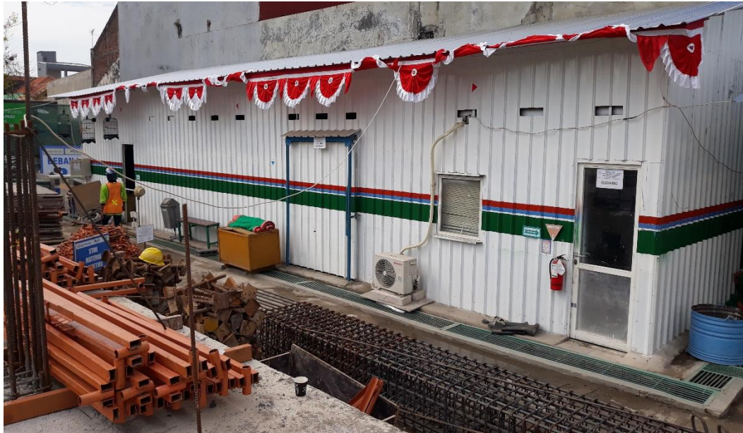
Gambar 2.11 Gudang Material Proyek Apartemen Kyo
