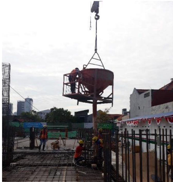
Gambar 3.8 Proses Penuangan Beton Segar dari Bucket Cor
