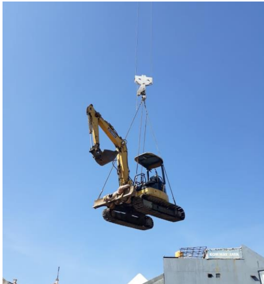
Gambar 3.27 Proses Pengangkatan Ekskavator dengan Tower Crane
