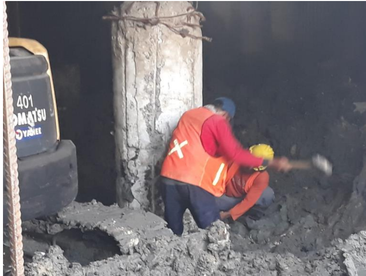
Gambar 3.31 Proses Pembobokan Kepala Bored Pile Eksisting
