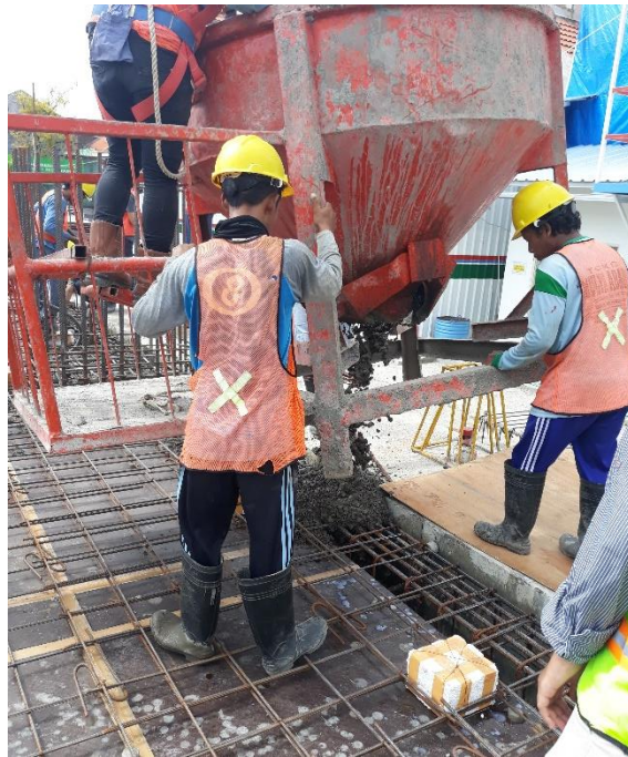
Gambar 3.11 Proses Penuangan Beton Segar pada Balok
