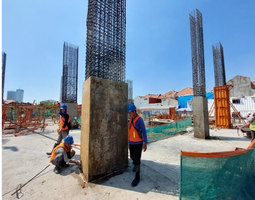
Gambar 3.40 Rembesan Air di Sekitar Kolom
