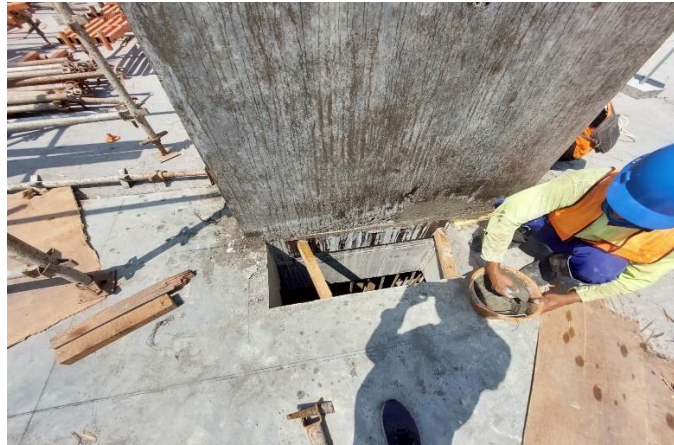
Gambar 3.42 Proses Grouting pada Bagian yang Keropos
