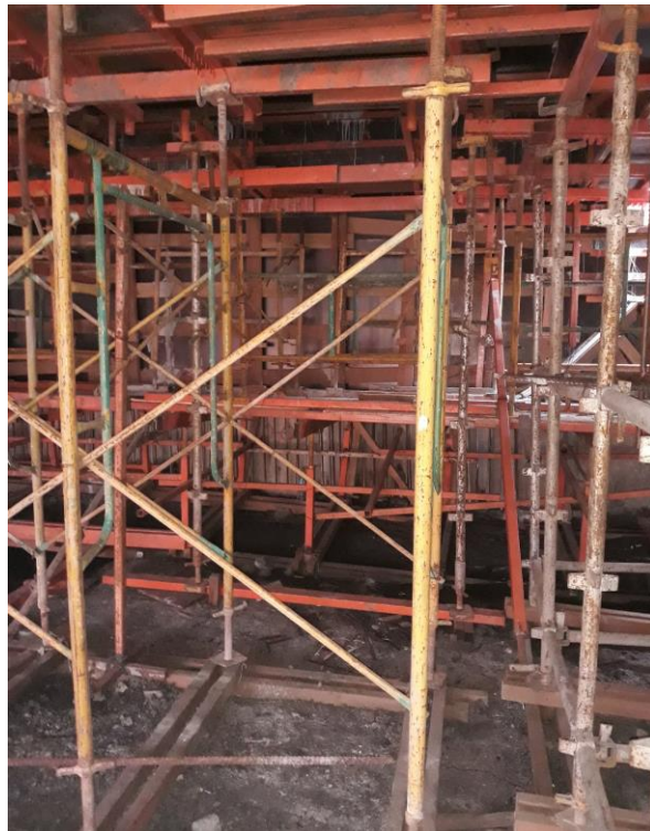
Gambar 3.20 Main Frame pada Perancah
