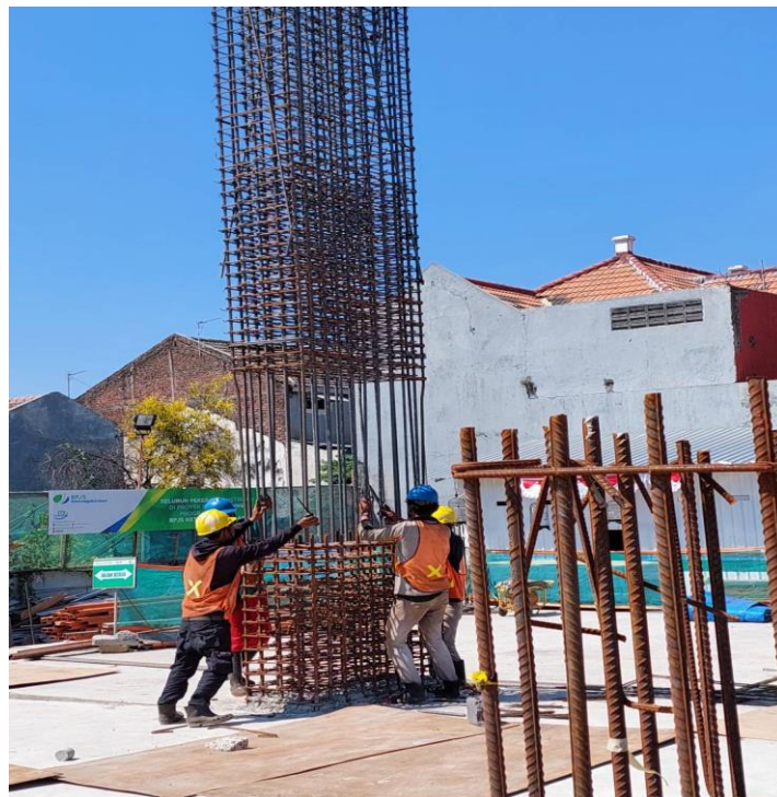
Gambar 3.3 Proses erection penulangan kolom terakit ke kolom eksisting
