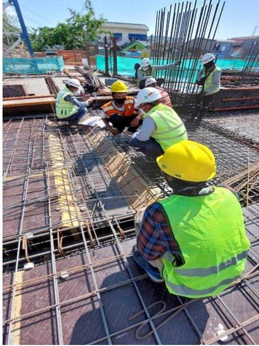
Gambar 2.27 Pemakaian Masker di Lokasi Proyek
