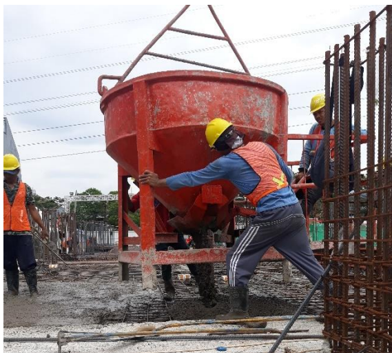
Gambar 3.13 Proses Penuangan Beton Segar dari Bucket Cor untuk Plat Lantai
