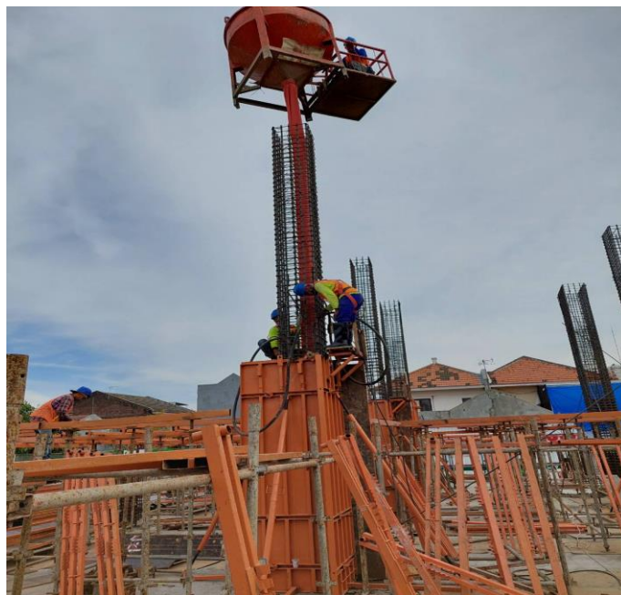
Gambar 3.38 Proses Penuangan Beton Segar dari Bucket Cor
