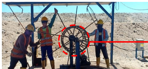
Gambar 3.1.8 Fabrikasi Tulangan menggunakan Bar Rolling
