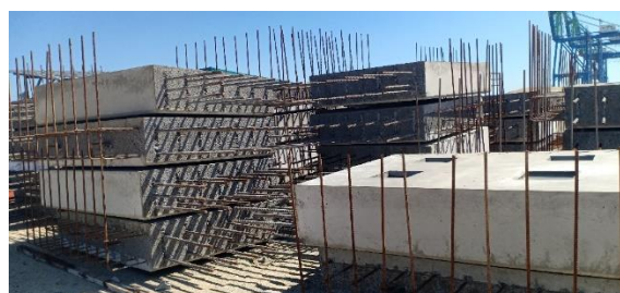
Gambar Lisplank Precast di Storage Area
