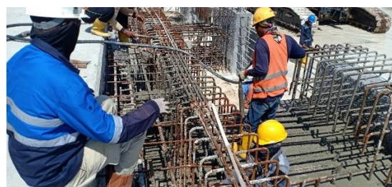
Gambar 3.3.23 Pengecoran Capping Beam Tahap 2
