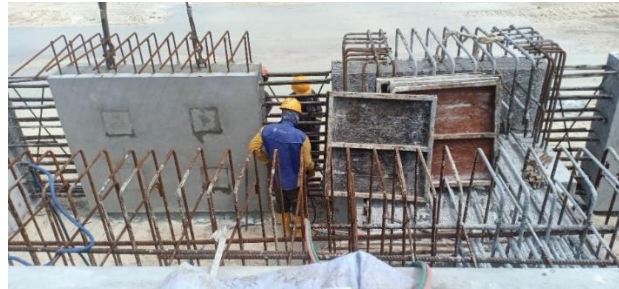
Gambar 3.3.27 Instalasi Tulangan Joint Lisplank
