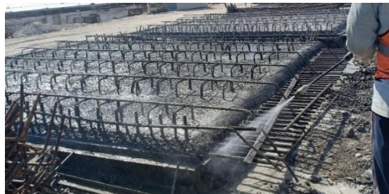
Pekerjaan Greencut Plat Precast
