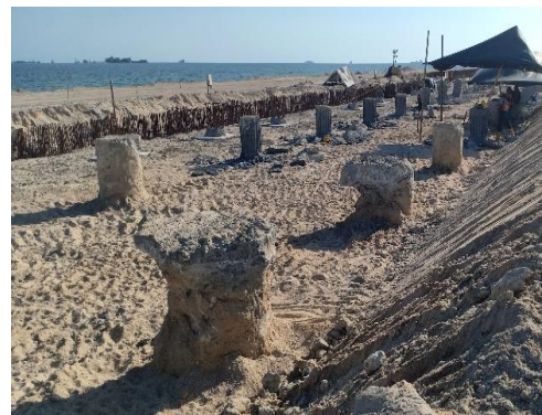
Gambar 3.1.32 Borepile yang telah dibobok
