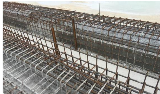
Gambar 3.3.36 Pengecoran Lantai Saluran
