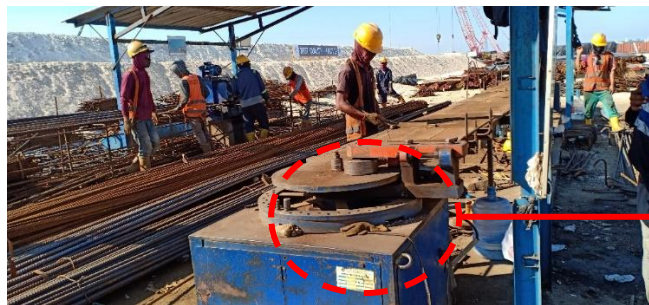
Gambar 3.1.7 Fabrikasi Tulangan menggunakan Bar Bending
