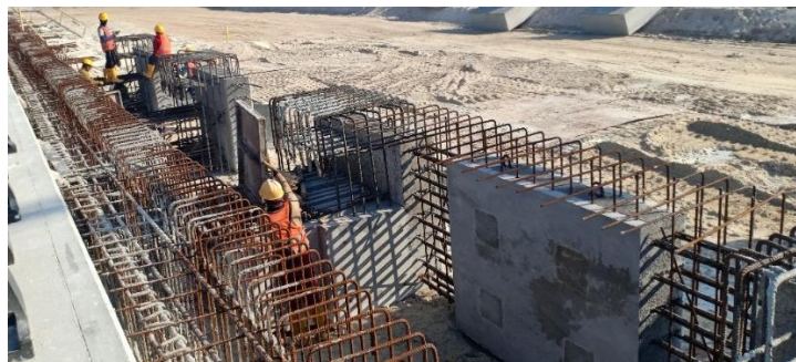
Gambar 3.3.18 Pekerjaan Tulangan Capping Beam
