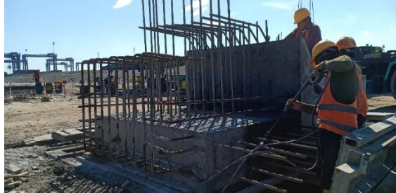
Pekerjaan greencut Plank Fender
