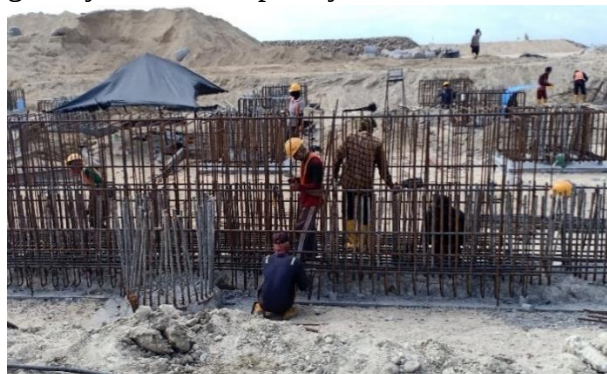
Gambar 3.3.6 Pekerjaan Tulangan Capping Beam
