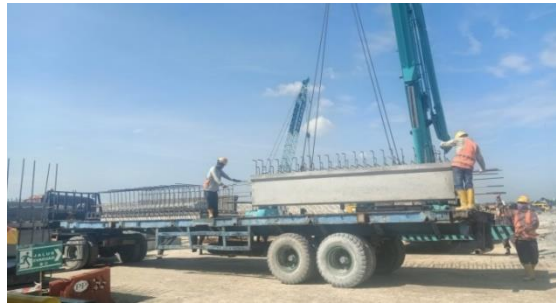
Lifting Lantai Saluran
