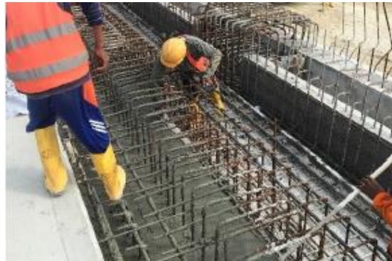
Gambar 3.3. 35 Pengecoran Lantai Saluran + Capping Beam tahap 3
