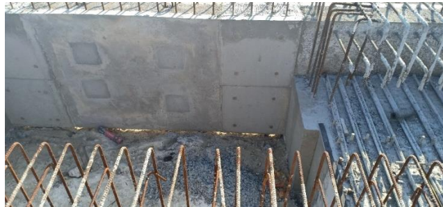
Gambar 3.3.30 Pekerjaan Pengecoran Lisplank
