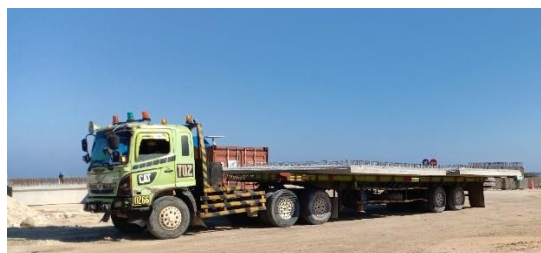
Mobilisasi panel precast
