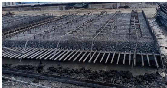
Tampak Pekerjaan Precast
