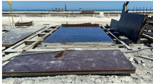
Fabrikasi Bekisting Lisplank Precast
