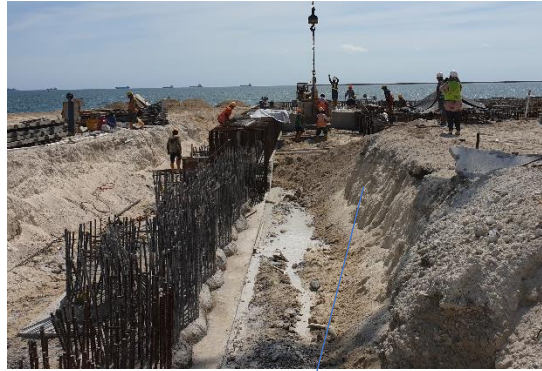
Gambar 3.3.5 Pekerjaan Lantai Kerja Capping Beam
