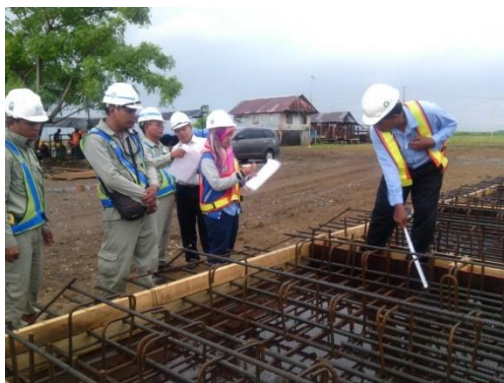
Gambar 2.10 Cek Instalasi Tulangan
