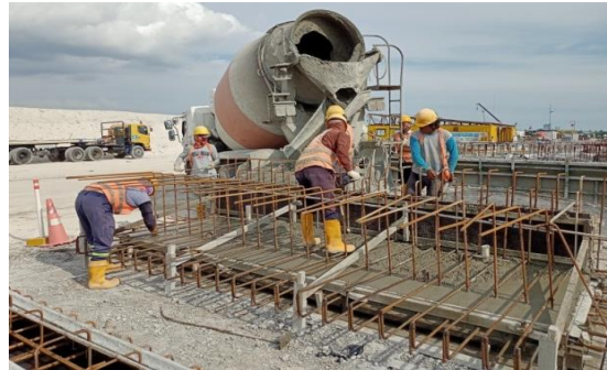
Pengecoran Lantai Saluran
