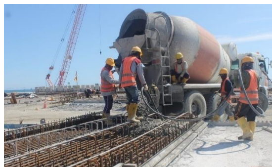
Pengecoran Plat Precast
