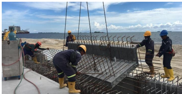
Gambar 3.3. 33 Instalasi Lantai Saluran Precast
