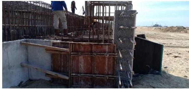
Gambar 3.3. 19 Pekerjaan Instalasi Bekisting Plank Fender
