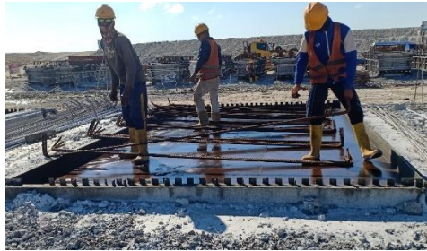
Instalasi tulangan pembagi pada plat
