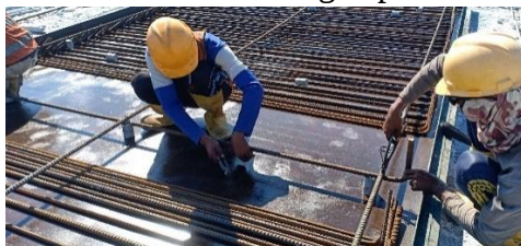
Instalasi tulangan pembagi dengan selimut beton
