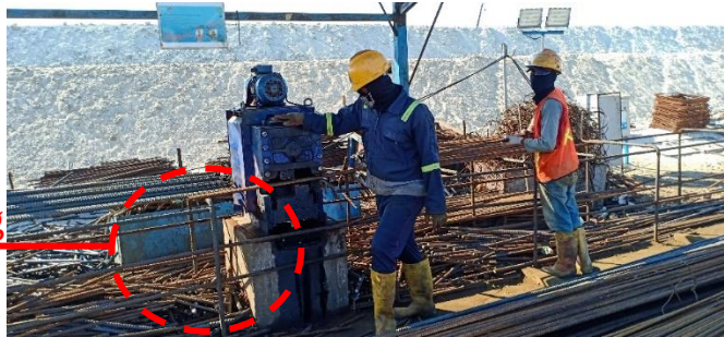
Gambar 3.1.6 Fabrikasi Tulangan menggunakan Bar Cutting
