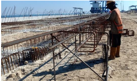
Fabrikasi tulangan plat
