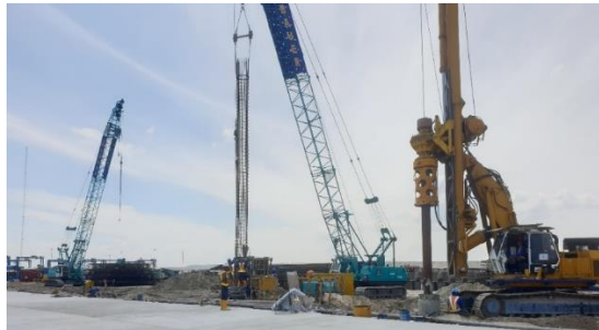
Gambar 3.1.25 Instalasi Tulangan Borepile
