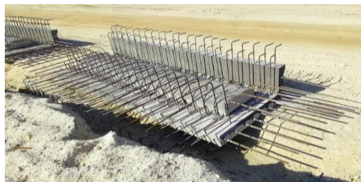
Lantai Saluran di storage area
