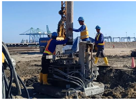
Gambar 3.1.28 Instalasi Pipa Tremie pada Lubang Bor
