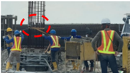
Gambar 3.1.26 Penyambungan Rangkaian Tulangan
