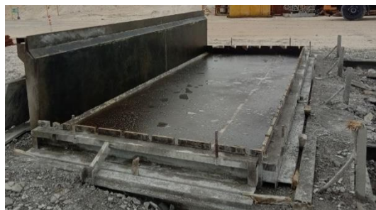
Bekisting Lantai Saluran
