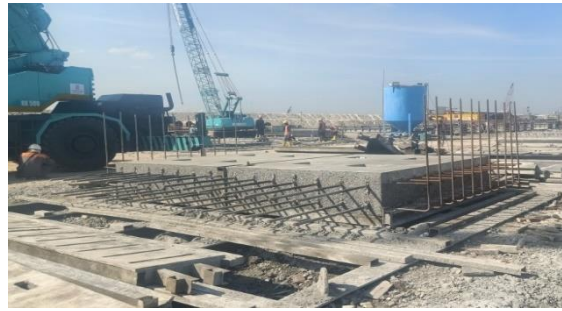
Panel Lisplank Precast setelah di Green Cut
