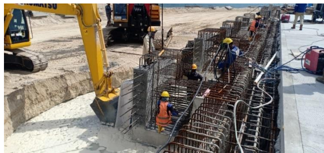
Gambar 3.3.15 Instalasi Plank Fender
