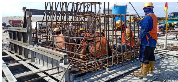
Perakitan Tulangan Precast
