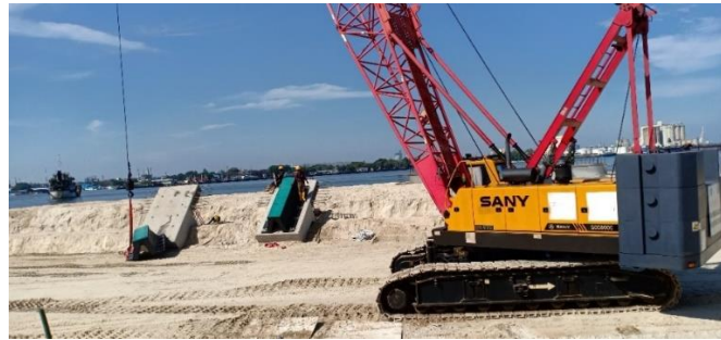
Gambar 3.3. 14 Instalasi Rubber Fender pada Plank Fender
