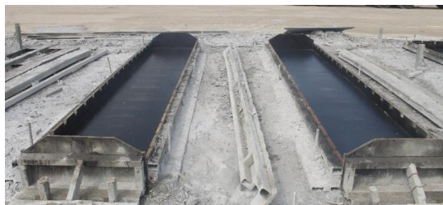
Pekerjaan bekisting kantilever
