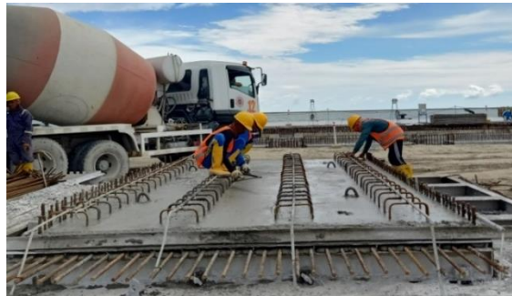
Pekerjaan Perataan Permukaan Plat Precast
