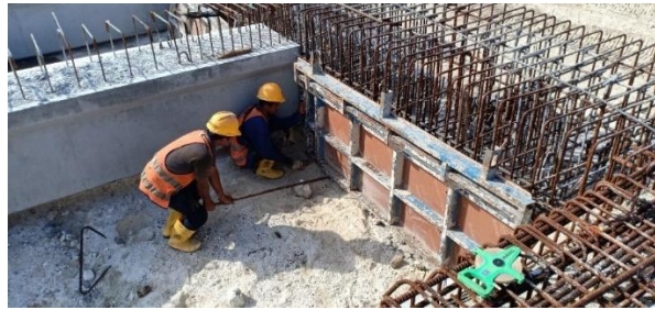
Gambar 3.3.21 Pekerjaan Instalasi Bekisting
