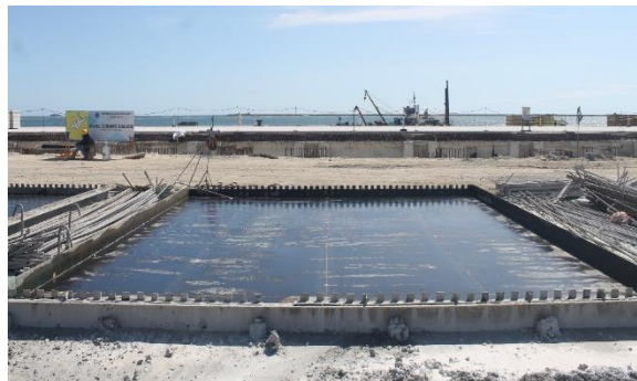
Gambar Bekisting Plat Pracetak yang telah Diolesi Minyak
