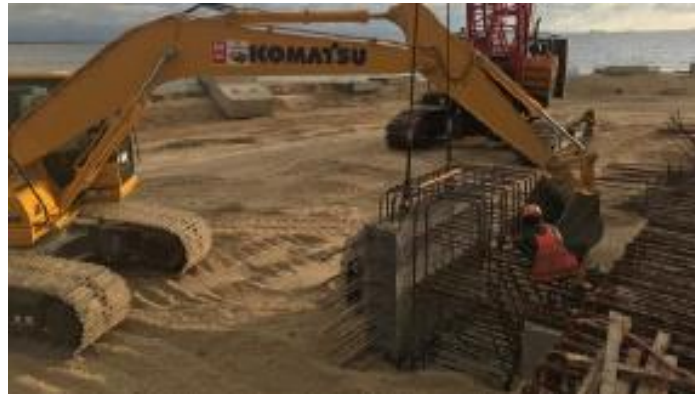
Gambar 3.3.17 Pekerjaan Urugan Plank Fender
