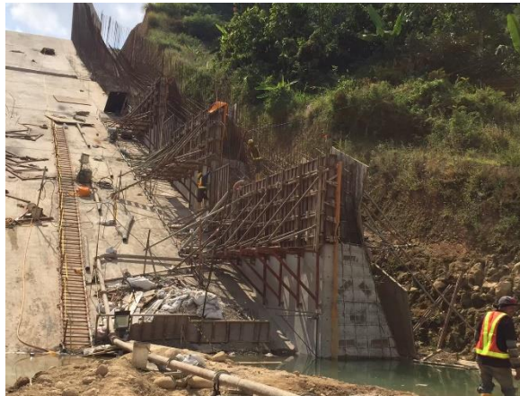
Gambar 3. 39 Bekisting dan Penulangan Dinding Pelimpah (Sumber: Dokumentasi Penulis, 2021)
