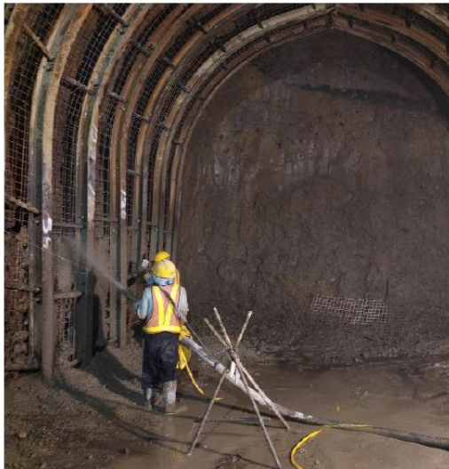
Gambar 3. 17 Shotcrete Pada Tunnel (Sumber: Data Proyek Bendungan Jlantah)
