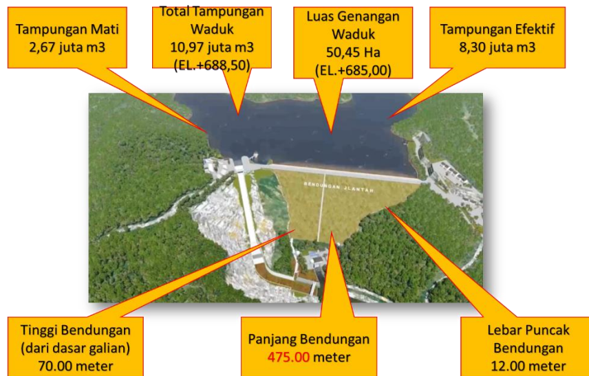
Gambar 2. 1 Data Teknis Umum Proyek Pembangunan Bendungan Jlantah (Sumber: Data Proyek Bendungan Jlantah)
