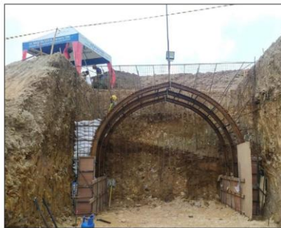
Gambar 3. 6 Pemasangan Wiremesh Portal
