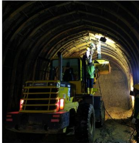
Gambar 3. 15 Pemasangan Ventilation dan Lightning Sistem (Sumber: Data Proyek Bendungan Jlantah)
