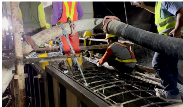
Gambar 4. 15 Pengecoran Lengkung Mercu Menggunakan Sliding Form
