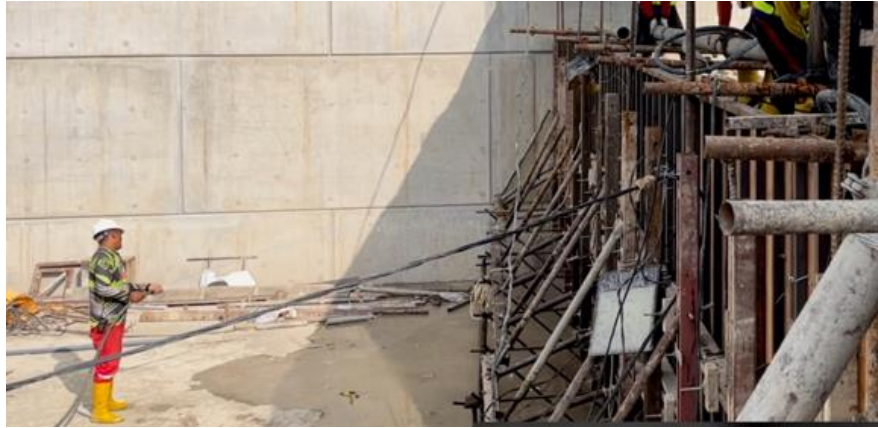
Gambar 4. 16 Pekerja Menyemprotkan Air Untuk Membersihkan Beton (Sumber: Dokumentasi Penulis, 2021)
