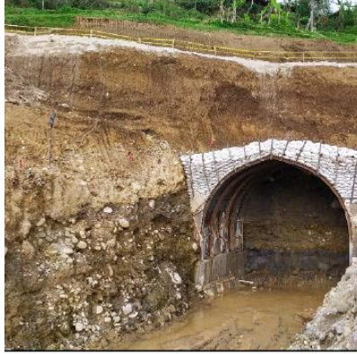
Gambar 3. 7 Pemasangan Sandbag pada Portal (Sumber: Data Proyek Bendungan Jlantah)
