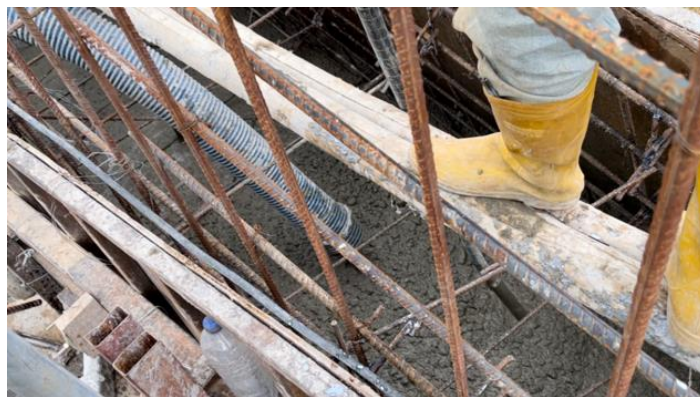
Gambar 3. 41 Pemadatan Cor Beton Dengan Vibrator (Sumber: Dokumentasi Penulis, 2021)
