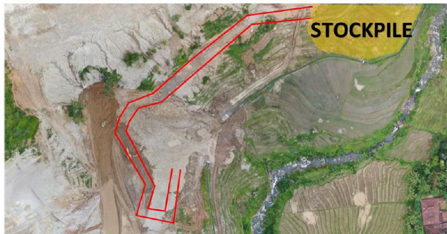
Gambar 3. 12 Stockpile Area Tunnel Pengelak (Sumber: Data Proyek Bendungan Jlantah)
