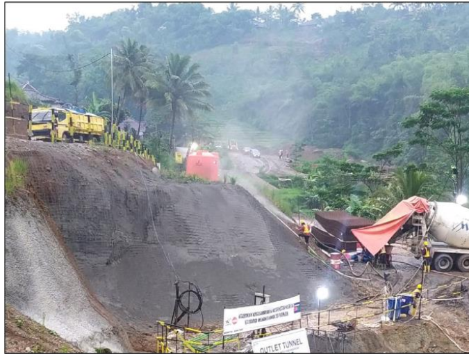
Gambar 3. 22 Pelaksanaan Shotcrete Sebagai Proteksi Lereng (Sumber: Data Proyek Bendungan Jlantah)
