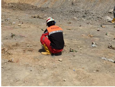
Gambar 4. 27 Pemasangan Rangkaian Kabel Pemicu Ledak (Sumber: Dokumentasi Penulis, 2021)
