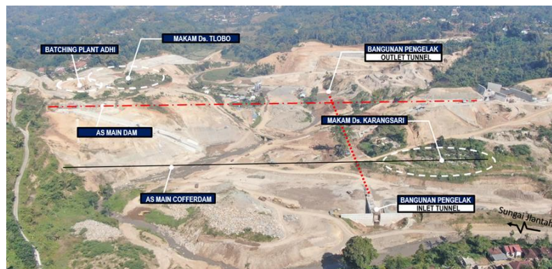
Gambar 5. 1 Lokasi Makam di Lokasi Proyek
