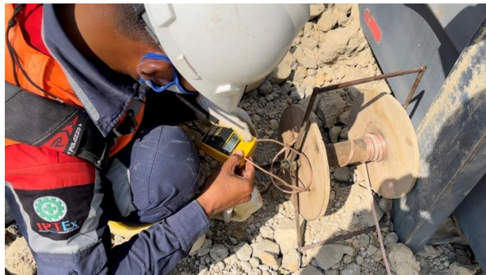
Gambar 4. 28 Pemasangan kabel Pemicu Ledak ke Detonator (Sumber: Dokumentasi Penulis, 2021)
