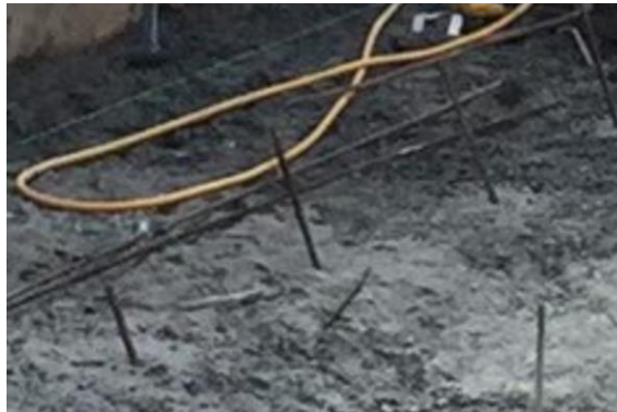
Gambar 4. 3 Angkur pada Dasar Dinding Bidang Kontak (Sumber: Dokumentasi Penulis, 2021)
