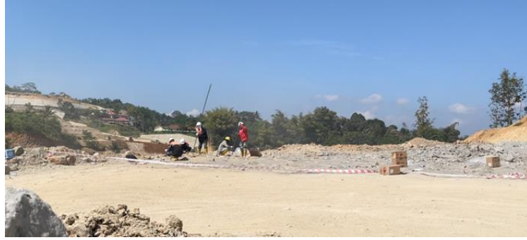
Gambar 4. 23 Lokasi Blasting (Sumber: Dokumentasi Penulis, 2021)
