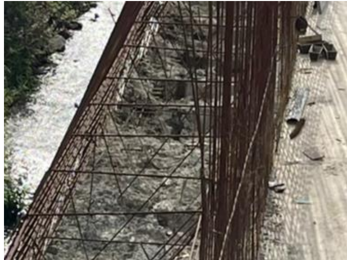
Gambar 3. 36 Lean Concrete Dinding Pelimpah (Sumber: Dokumentasi Penulis, 2021)
