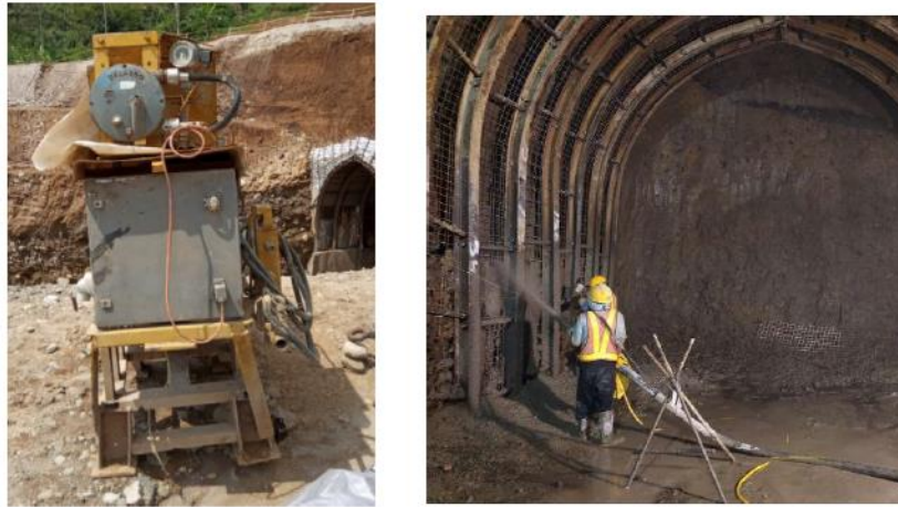
Gambar 3. 13 Mesin dan Pelaksanaan Shotcrete (Sumber: Data Proyek Bendungan Jlantah)
