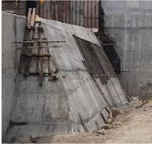
Gambar 4. 7 Dinding Bidang Kontak Inti Cofferdam dengan Beton
