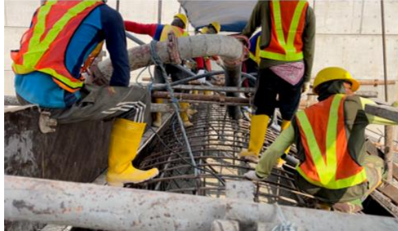
Gambar 4. 14 Pengecoran Mercu Bendung (Sumber: Dokumentasi Penulis, 2021)
