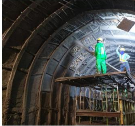
Gambar 3. 20 Penyemprotan Shotcrete di Langit-langit Tunnel (Sumber: Data Proyek Bendungan Jlantah)
