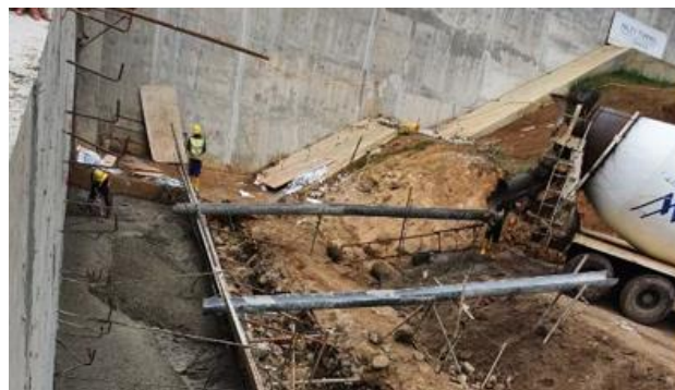
Gambar 4. 6 Pengecoran Dinding Bidang Kontak
