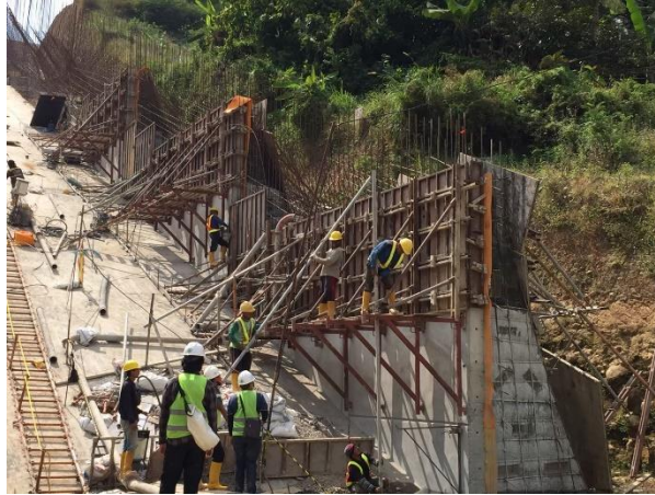
Gambar 3. 40 Pengecoran Dinding Pelimpah (Sumber: Dokumentasi Penulis, 2021)
