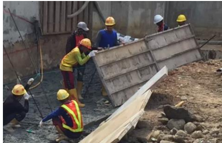
Gambar 4. 5 Pemasangan Bekisting Bidang Kontak
