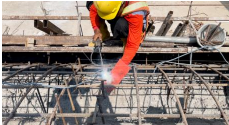
Gambar 4. 12 Pemasangan Lintasan Sliding Form (Sumber: Dokumentasi Penulis, 2021)
