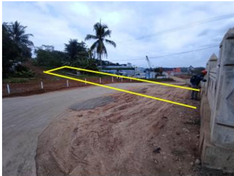
Gambar 3.2 Sisi KP Besar dan area yang digali untuk entry pit
