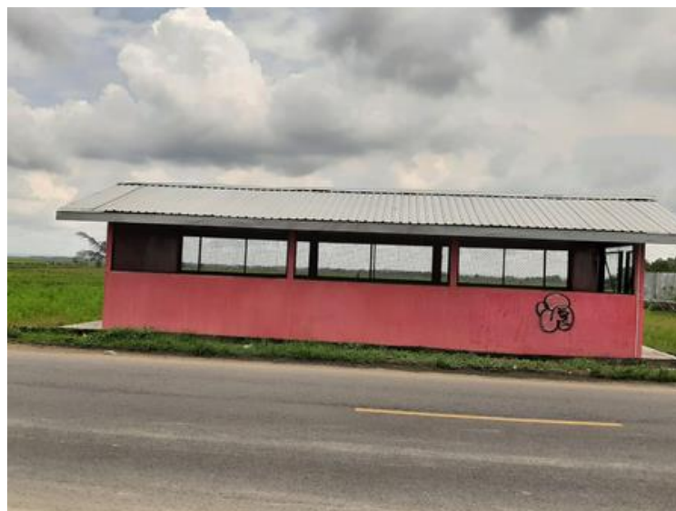
Gambar 3.73 Tampak rumah samping LBCV KP 30+100
