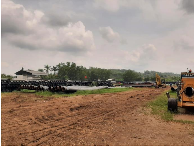
Gambar 2.7 Site Office (Tumpukan Pipa)
