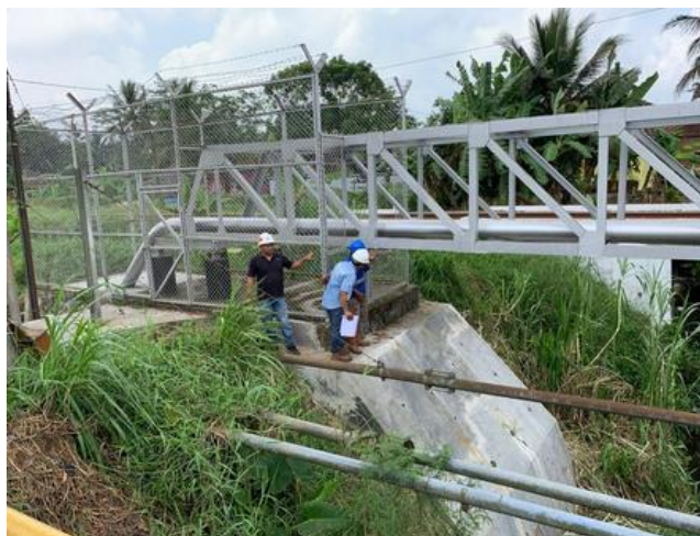
Gambar 3.71 Jembatan Awipari Sisi Kiri
