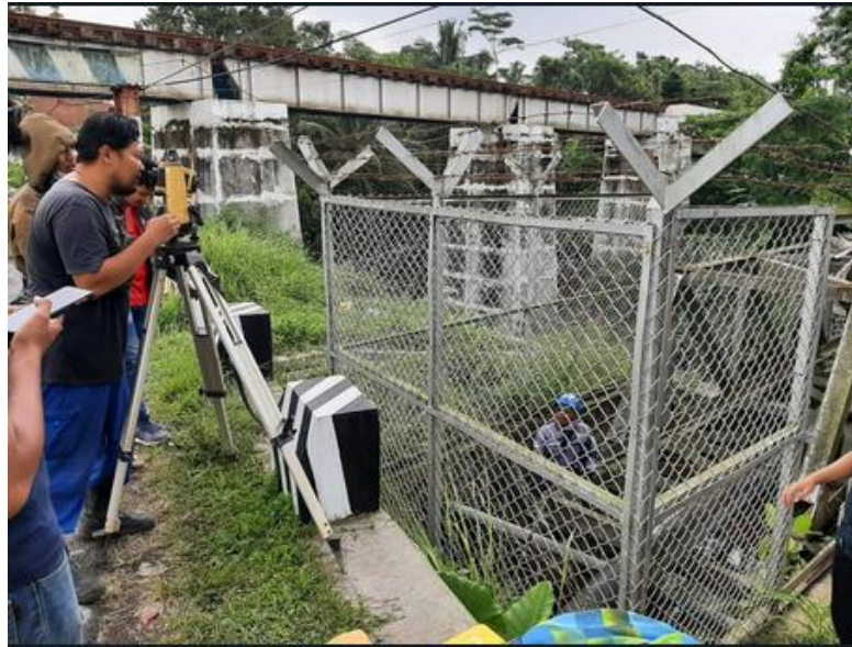
Gambar 3.78 Pengukuran elevasi Jembatan Cintapada
