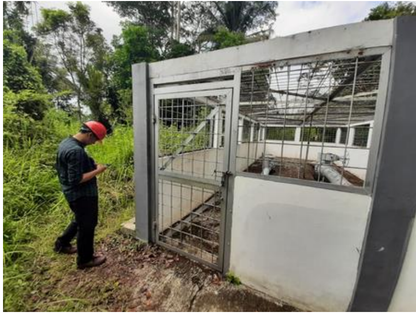
Gambar 3.80 Tampak depan Rumah LBCV KP 102+200
