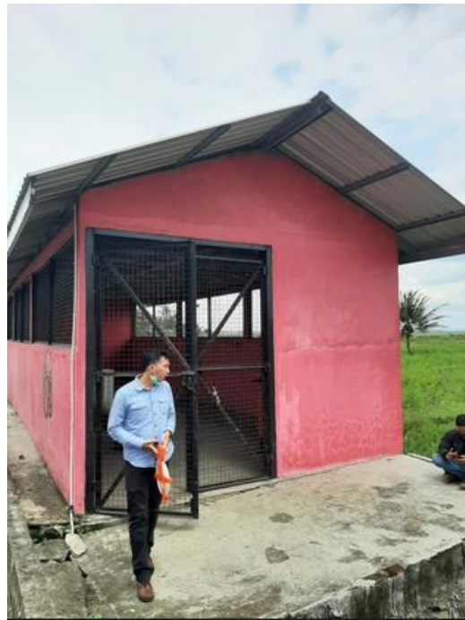
Gambar 3.72 Tampak depan rumah LBCV KP 30+100
