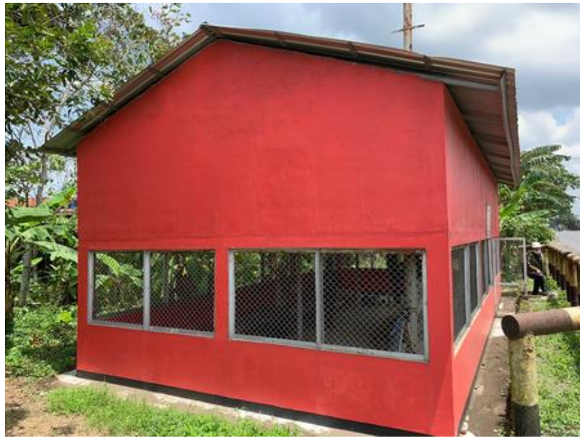
Gambar 3.74 Tampak samping rumah LBCV KP 35+300
