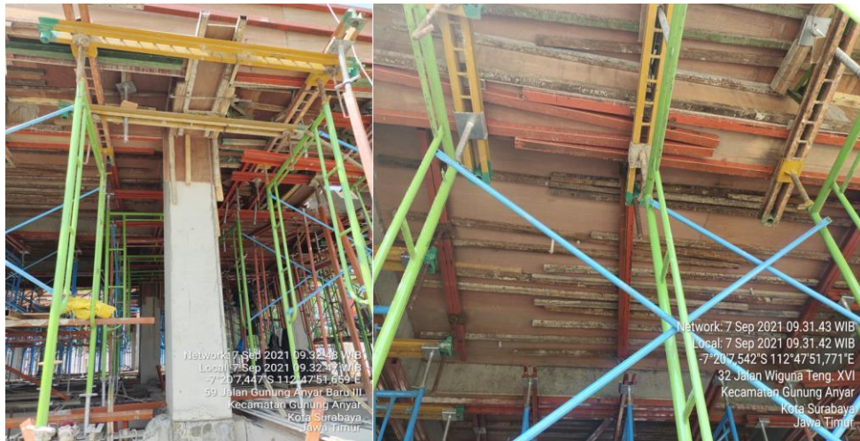
Gambar 3. 13 Pemasangan Bekesting Plat Lantai
