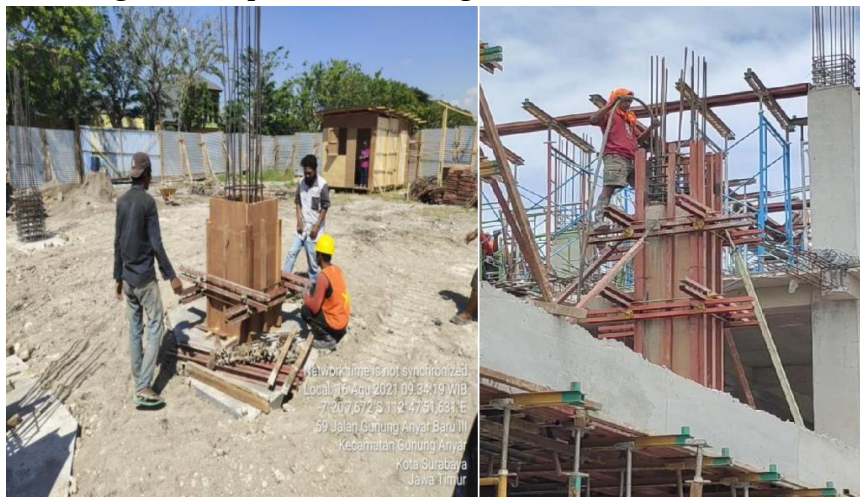
Gambar 3. 8 Pemasangan Bekesting Kolom
