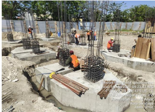
Gambar 3. 6 Pengecoran Pile Cap
