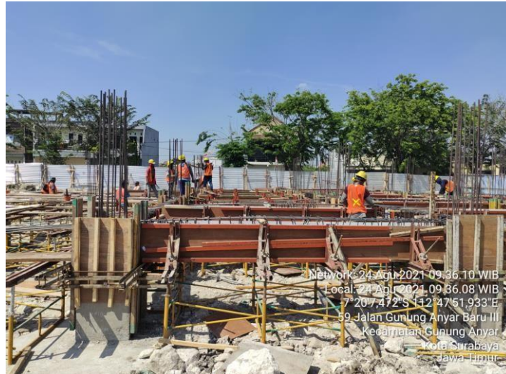
Gambar 3. 11 Pemasangan Bekisting Balok
