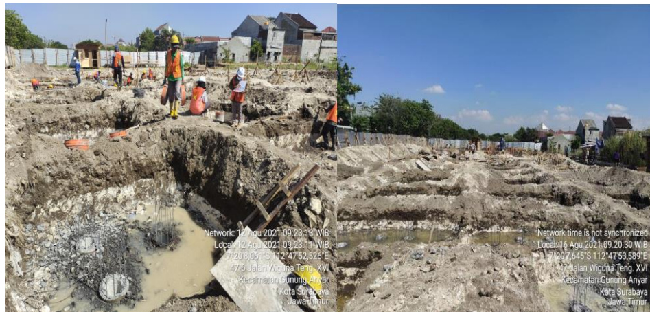
Gambar 3. 3 Pekerjaan Galian Pile Cap
