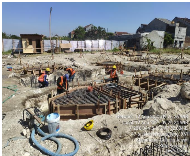
Gambar 3. 5 Pemasangan Bekesting Pile Cap
