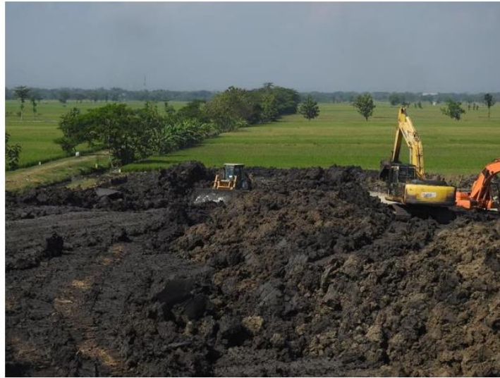
Gambar 3. 4 Proses Pengupasan Tanah Menggunakan Bulldozer dan Excavator
