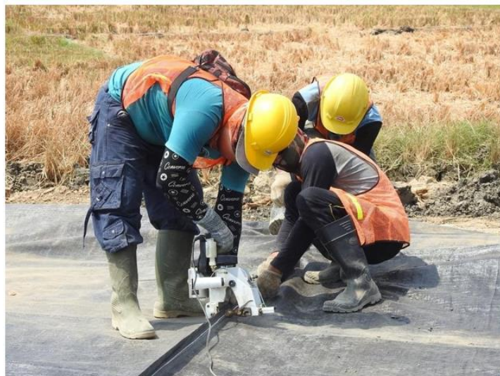
Gambar 3. 12 Proses Penjahitan Geotekstil Woven
