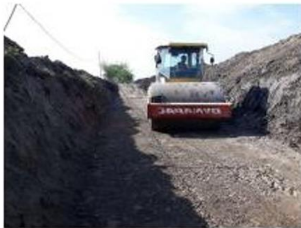
Gambar 3. 25 Pemadatan Tanah Dasar
