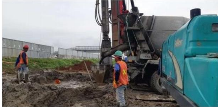
Gambar 3. 19 Proses Pengeboran Tanah
