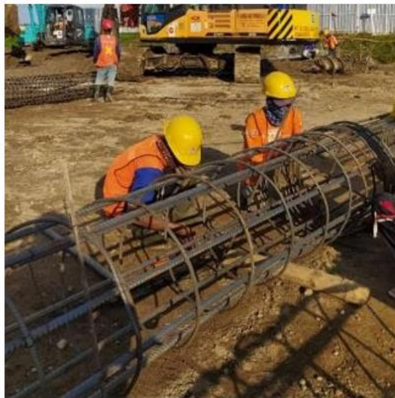
Gambar 3. 20 Proses Fabrikasi Baja Tulangan Bored Pile
