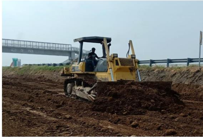
Gambar 3. 9 Proses Penghamparan Tanah Timbunan Menggunakan Bulldozer
