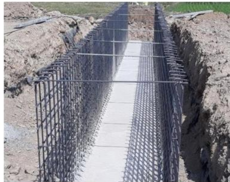
Gambar 3. 27 Pembesian Box Culvert
