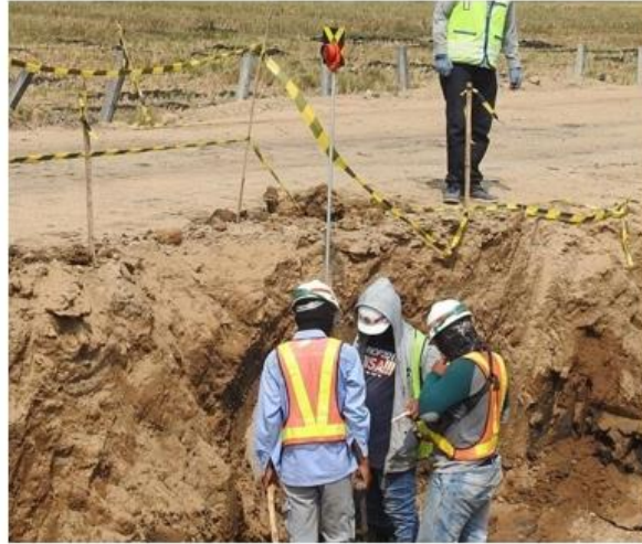
Gambar 3. 24 Pengukuran dan Pemasangan Patok
