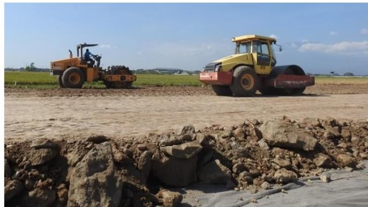
Gambar 3. 10 Proses Pemadatan Tanah Menggunakan Sheep Foot Roller dan Vibro Roller
