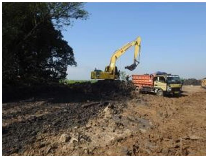
Gambar 3. 5 Loading Tanah ke Dalam Dump Truck
