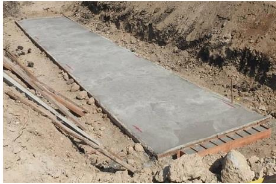
Gambar 3. 26 Pengecoran Lantai Kerja
