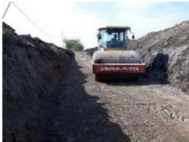
Gambar 3. 25 Pemadatan Tanah Dasar
