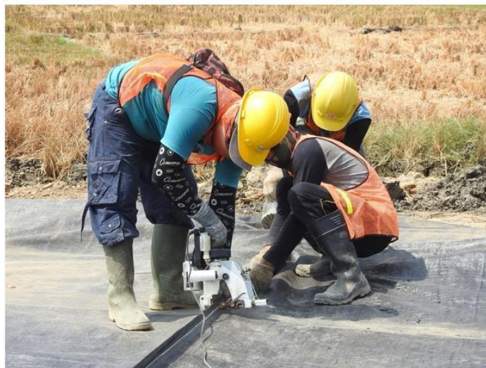
Gambar 3. 12 Proses Penjahitan Geotekstil Woven
