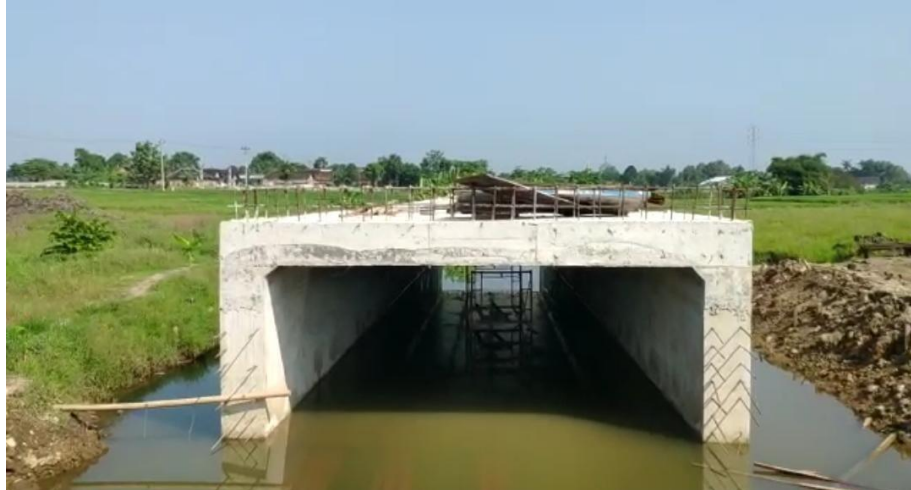
Gambar 3. 49 Genangan Air Akibat Hujan
