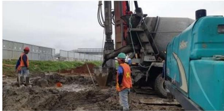
Gambar 3. 19 Proses Pengeboran Tanah
