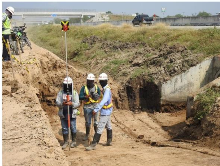
Gambar 3. 3 Marking Lokasi Pekerjaan
