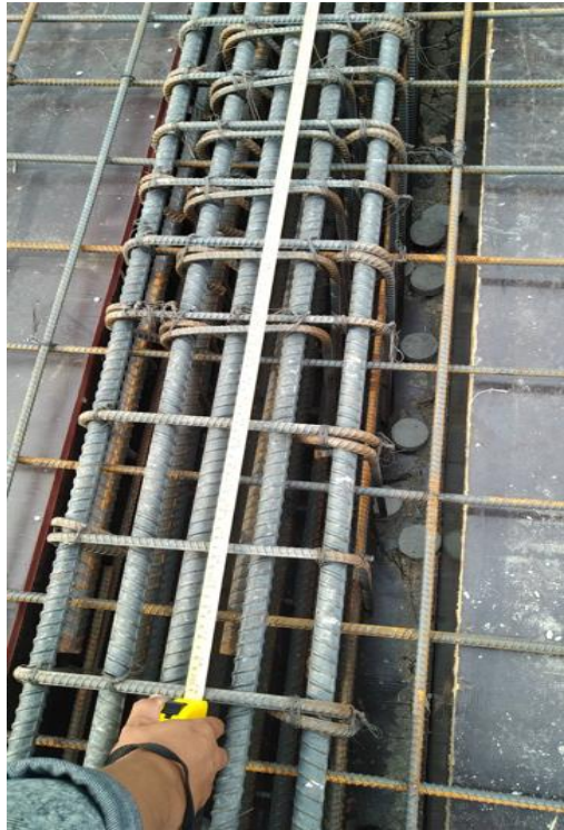
Gambar 5. 3 Pengecekan panjang lewatan
