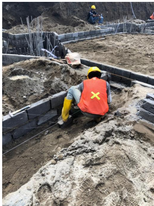
Gambar 4. 16 Pekerjaan bekisting Tie beam menggunakan batako
