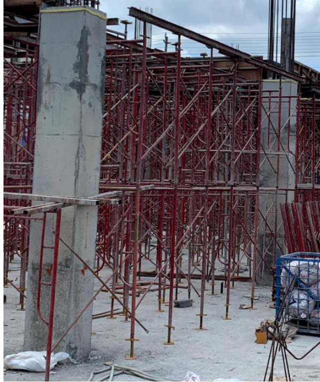
Gambar 4. 30 Hasil Pengecoran kolom setelah pembongkaran bekisting
