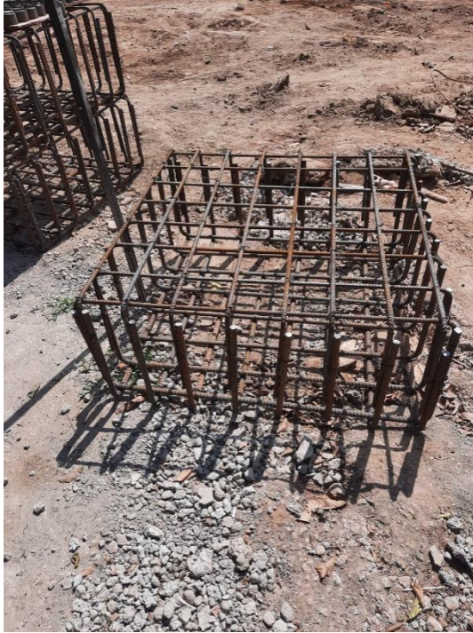
Gambar 4. 11 Pembuatan tulangan pile cap
