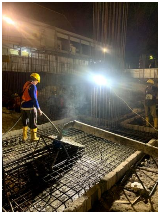
Gambar 4. 14 Pengecoran Pile cap
