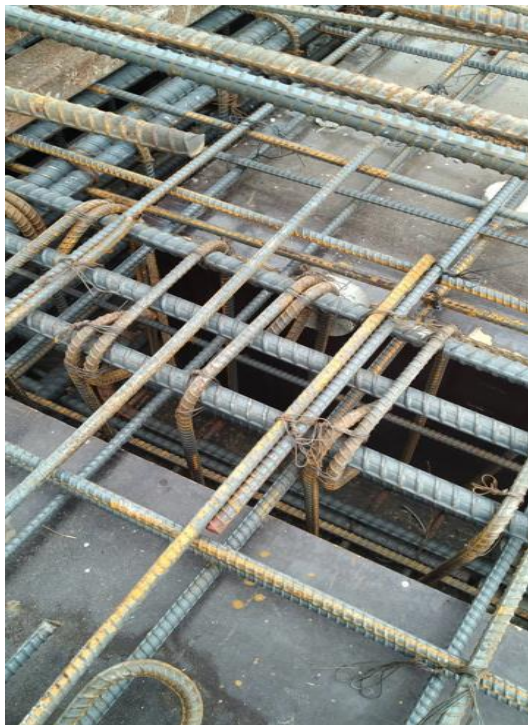
Gambar 5. 2 Pengecekan tulangan utama serta sengkang pada balok
