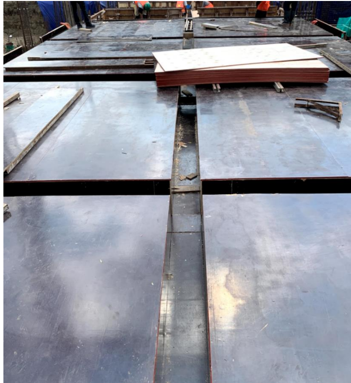
Gambar 4. 32 Hasil pemasangan bekisting kolom sebelum di cor
