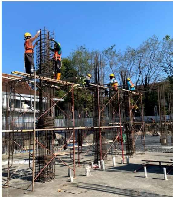
Gambar 4. 26 Pengerjaan pembesian kolom
