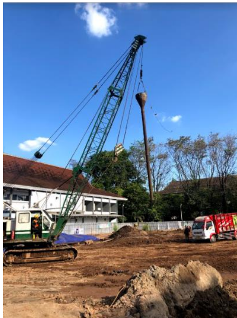
Gambar 4. 5 Pemandahan Pipa tremi menggunakan mobile crane
