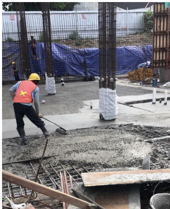
Gambar 4. 23 Pengecoran Pelat Lantai
