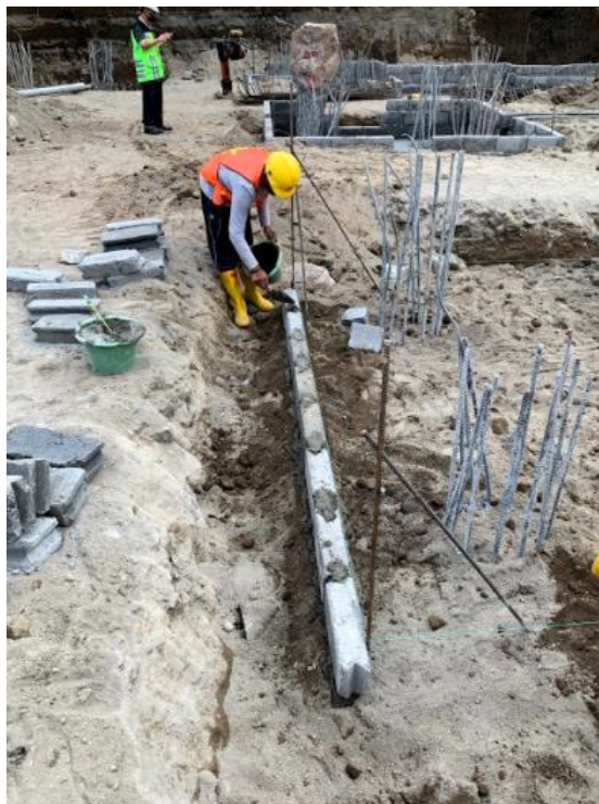
Gambar 4. 8 Instalasi bekisting pile cap menggunakan batako
