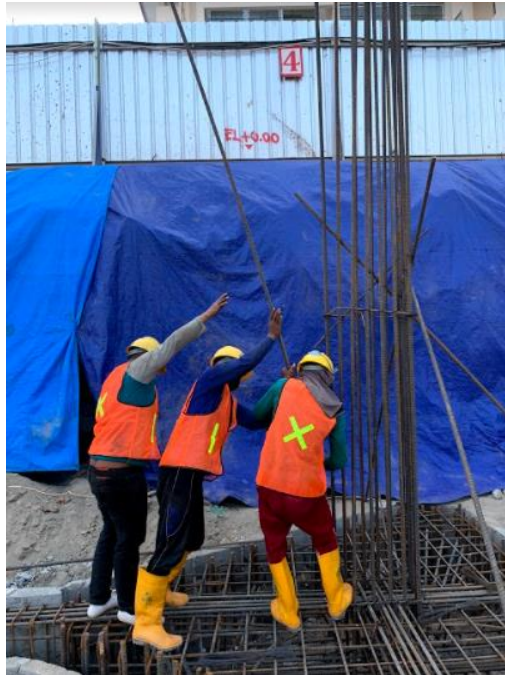
Gambar 4. 13 Pembuatan Stek kolom
