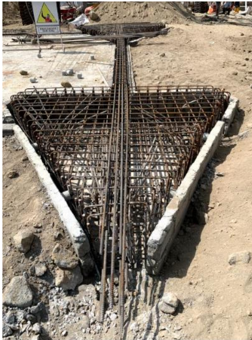
Gambar 4. 12 Penulangan pilecap pada site
