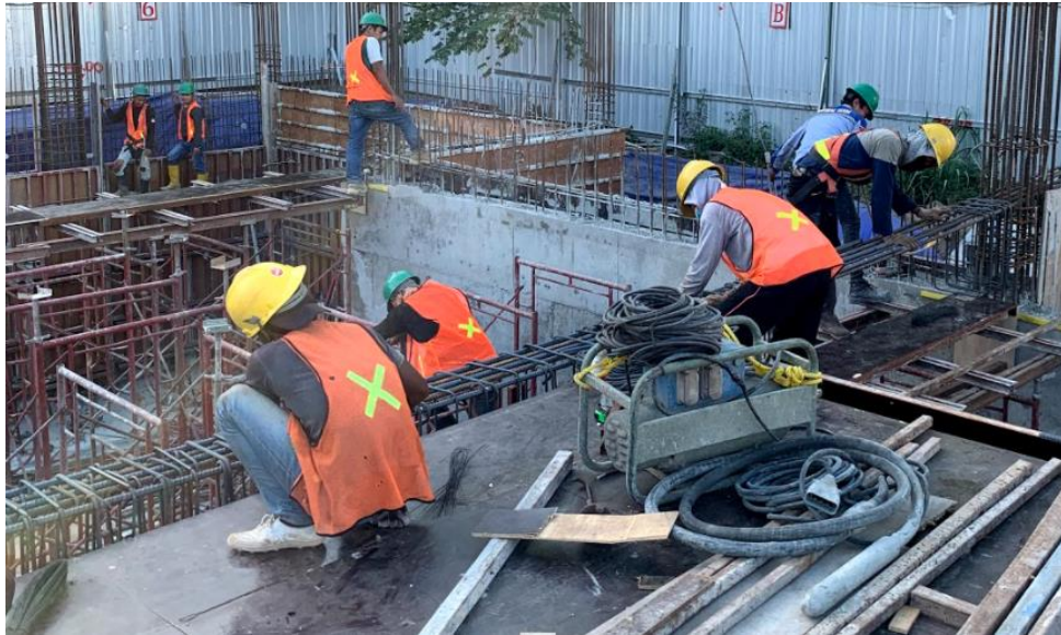
Gambar 4. 33 Pekerjaan pembesian balok
