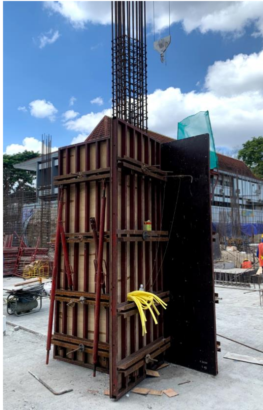
Gambar 4. 27 Pemasangan Bekisting kolom
