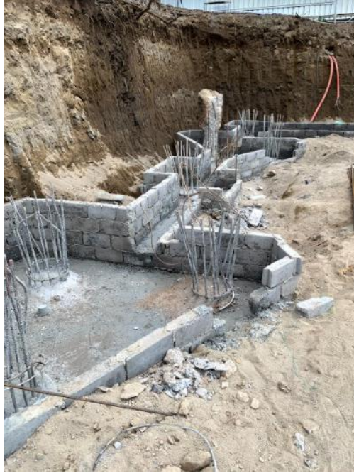
Gambar 4. 9 Hasil pengecoran lantai kerja Pile cap
