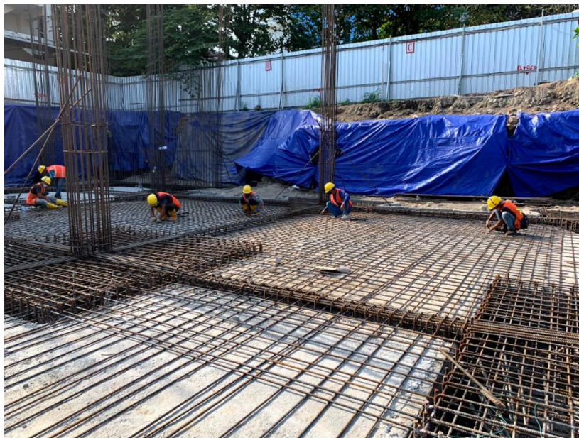
Gambar 4. 21 Penambahan Decking pada bawah tulangan
