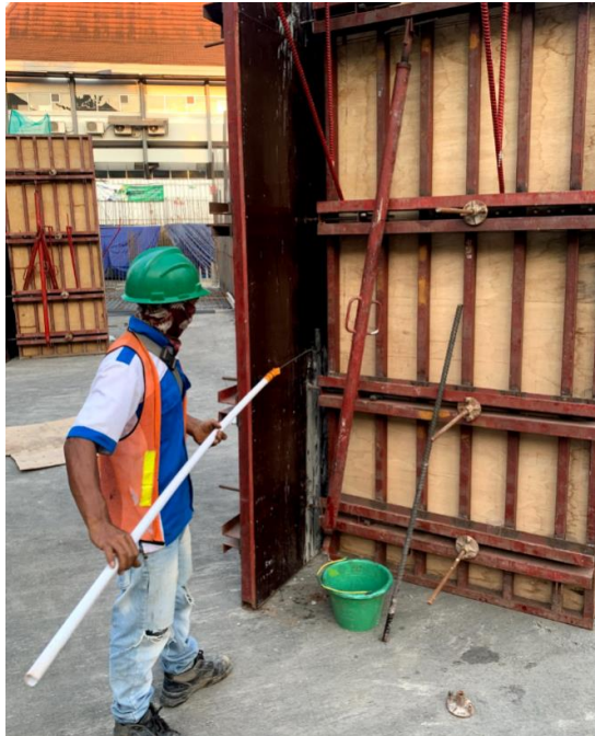
Gambar 4. 28 Penyemprotan bensin pada bekisting kolom
