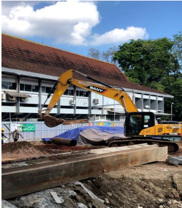
Gambar 4. 2 Galian tanah menggunakan Excavator
