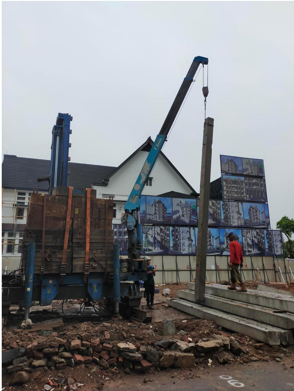
Gambar 3.6 Proses penarikan mini pile menuju Clamping Box
