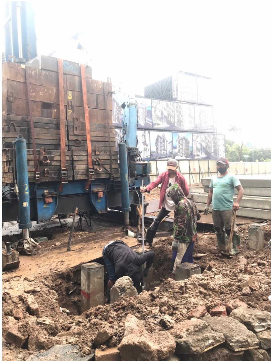
Gambar 3.13 Proses pekerjaan galian
