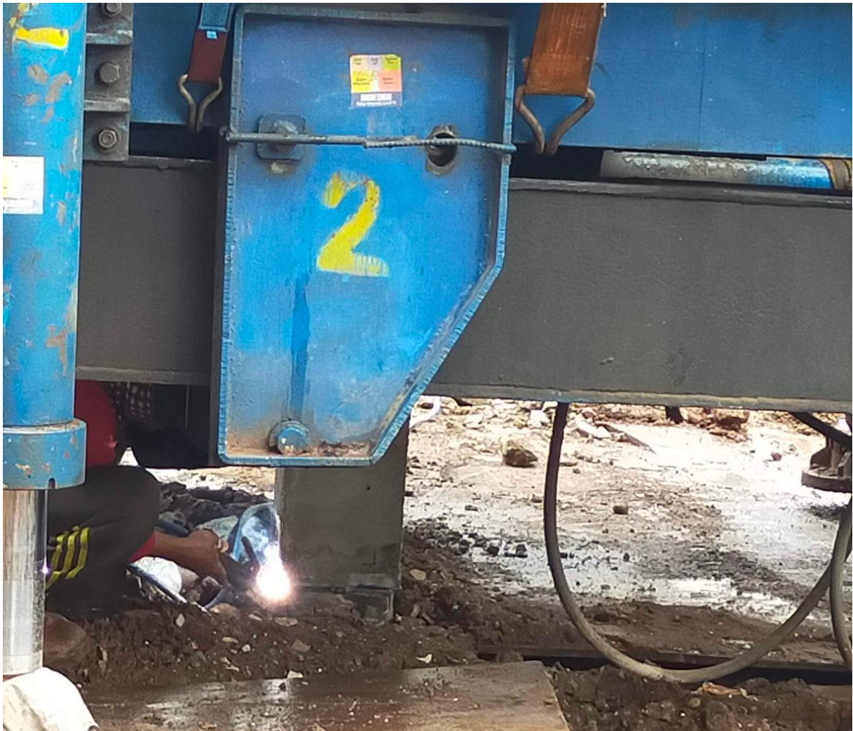
Gambar 3.10 Proses penyambungan dua mini pile dengan pengelasan
