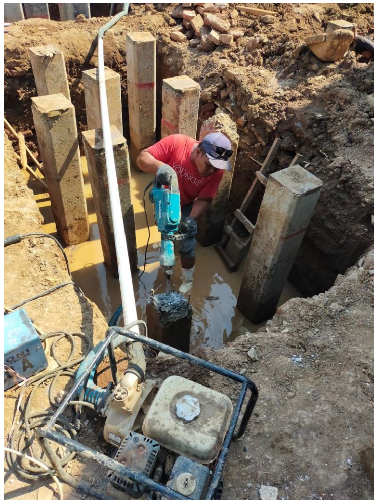
Gambar 3.15 Proses pembobokan mini pile
