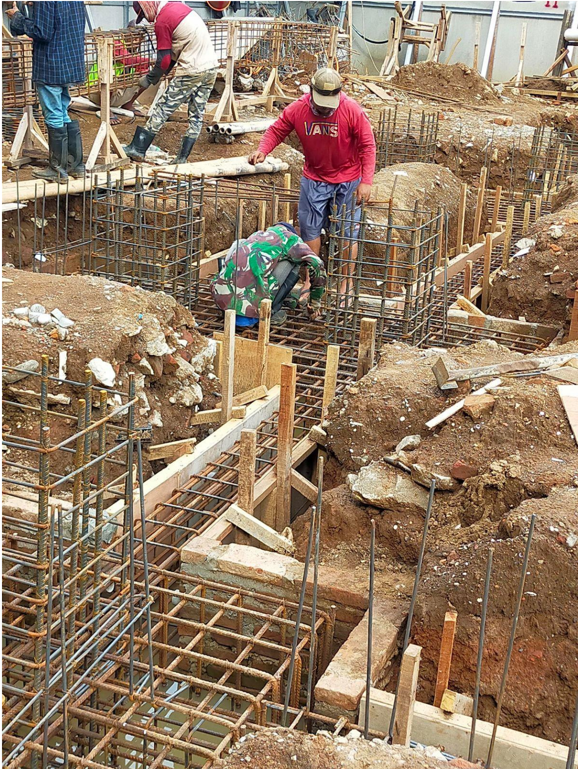
Gambar 3.23 Pemasangan kolom pedestal
