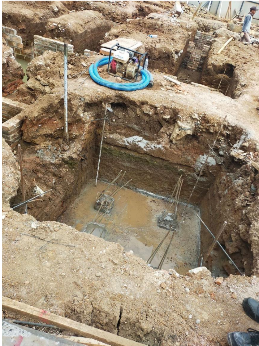
Gambar 3.16 Pembuatan lantai kerja
