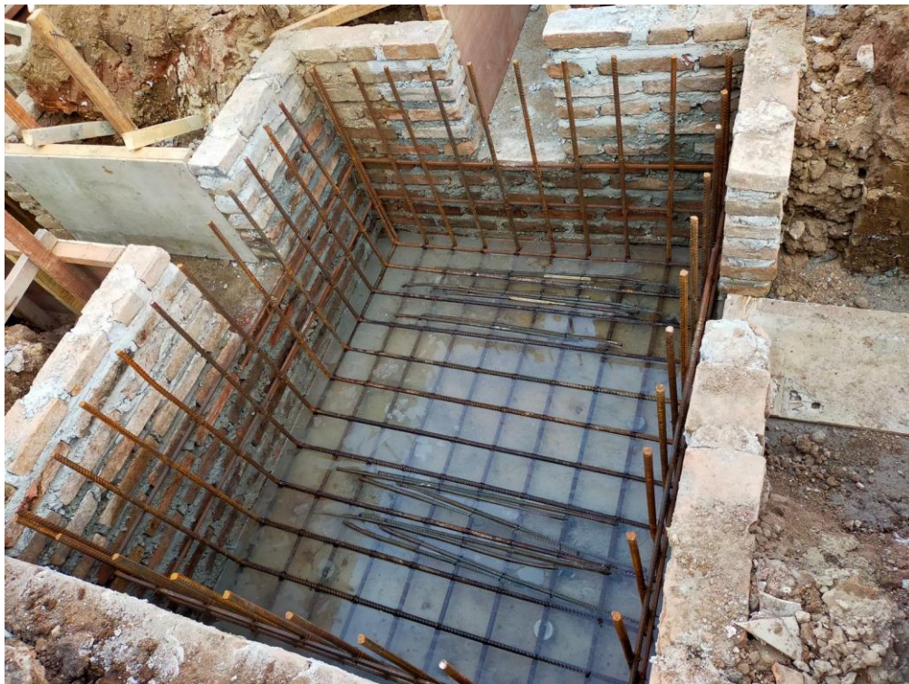
Gambar 3.21 Pemasangan Pile Cap
