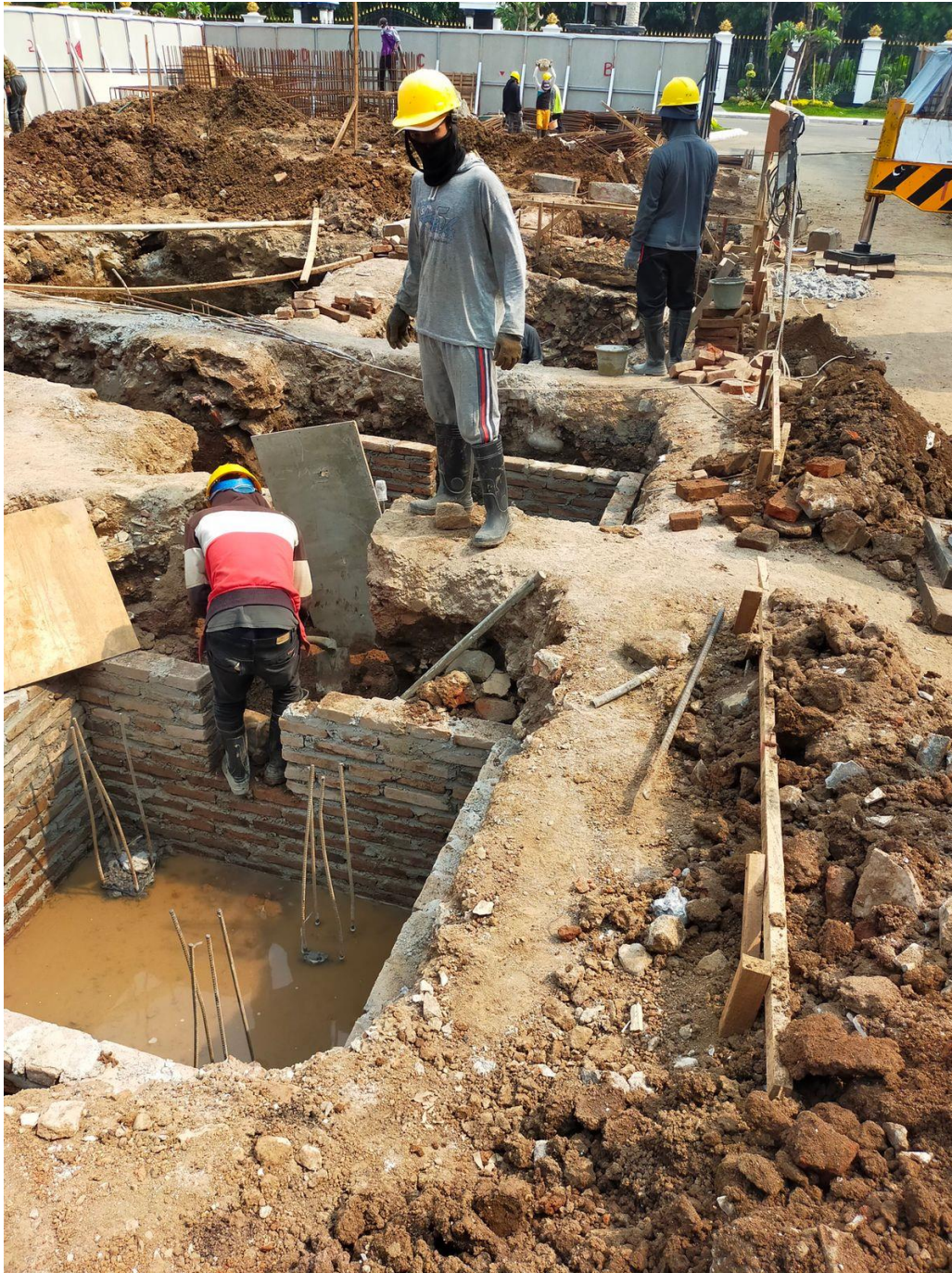
Gambar 3.17 Proses bekisting multiplek pada sloof
