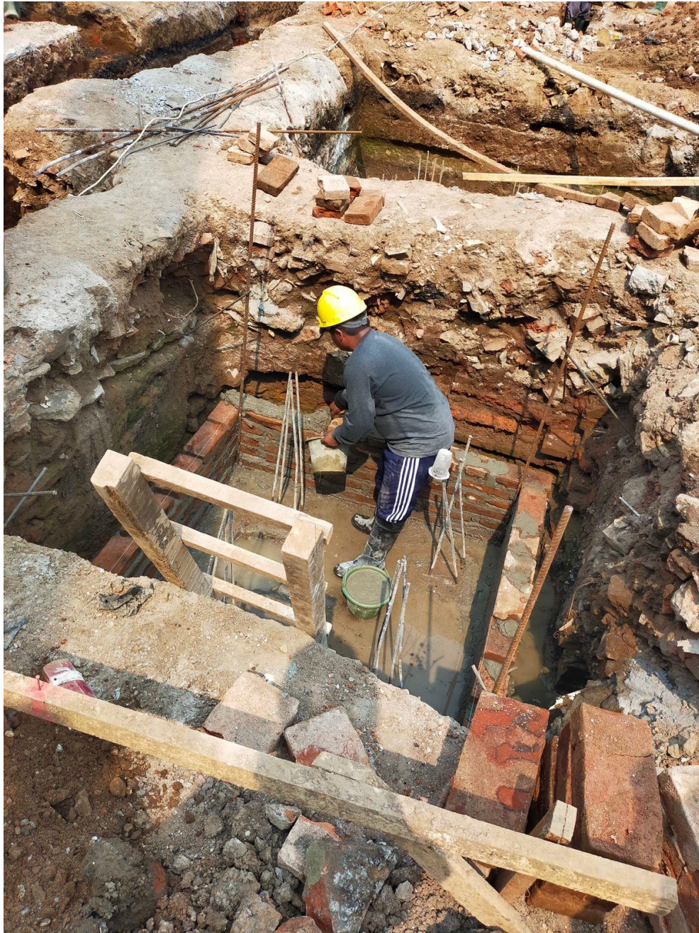
Gambar 3.18 Proses bekisting batu-bata pada pile cap
