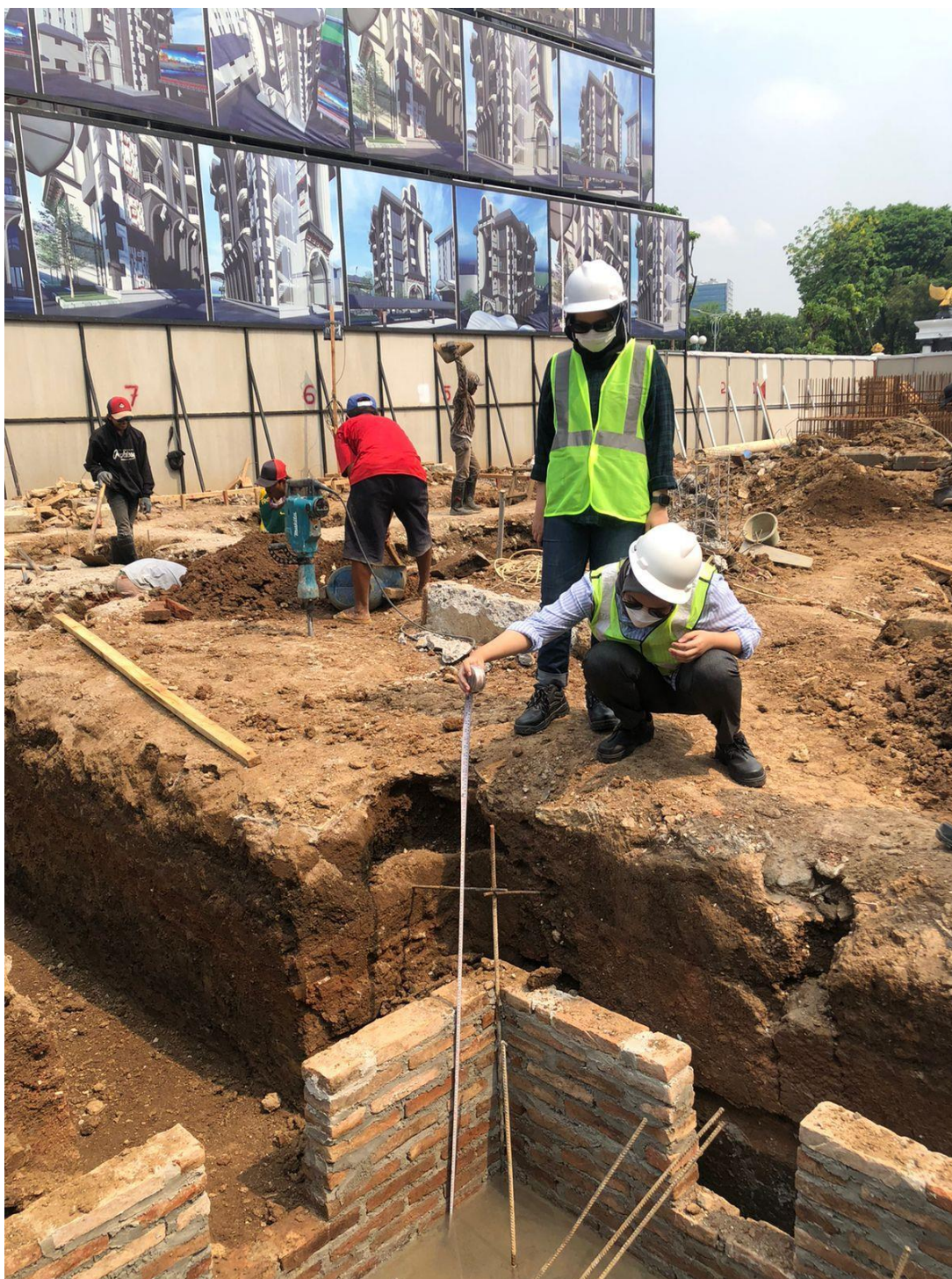
Gambar 5.3 Pengecekan Dimensi Pile Cap
