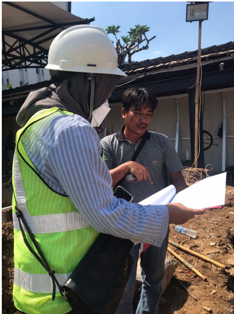
Gambar 5.1 Pengecekan titik pancang
