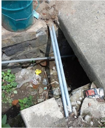
Gambar 2.8 Pipa Casing yang Terpasang di Lapangan.
