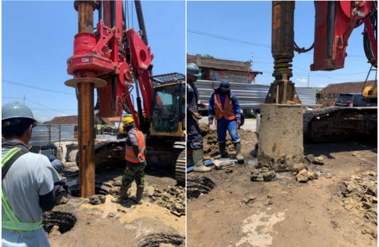
Gambar 2. 8. Pekerjaan pengeboran Bored pile
