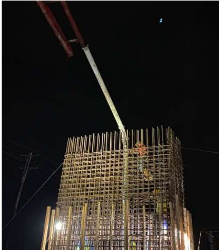
Gambar 2. 20. Pengecoran Pilar 7 Menggunakan Concrete Pump
