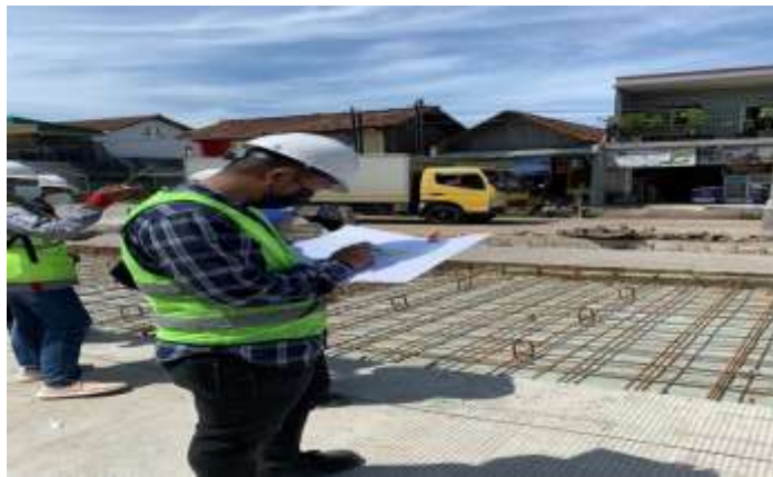
Gambar 2. 42. Peninjauan Pelaksanaan Pekerjaan STA 200
