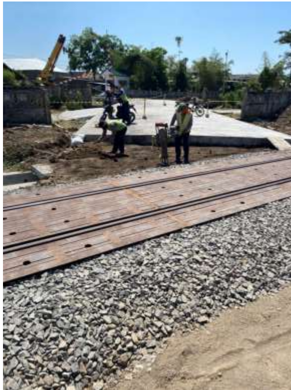
Gambar 2. 39. Pekerjaan Detouring dan Perkerasan Rel
