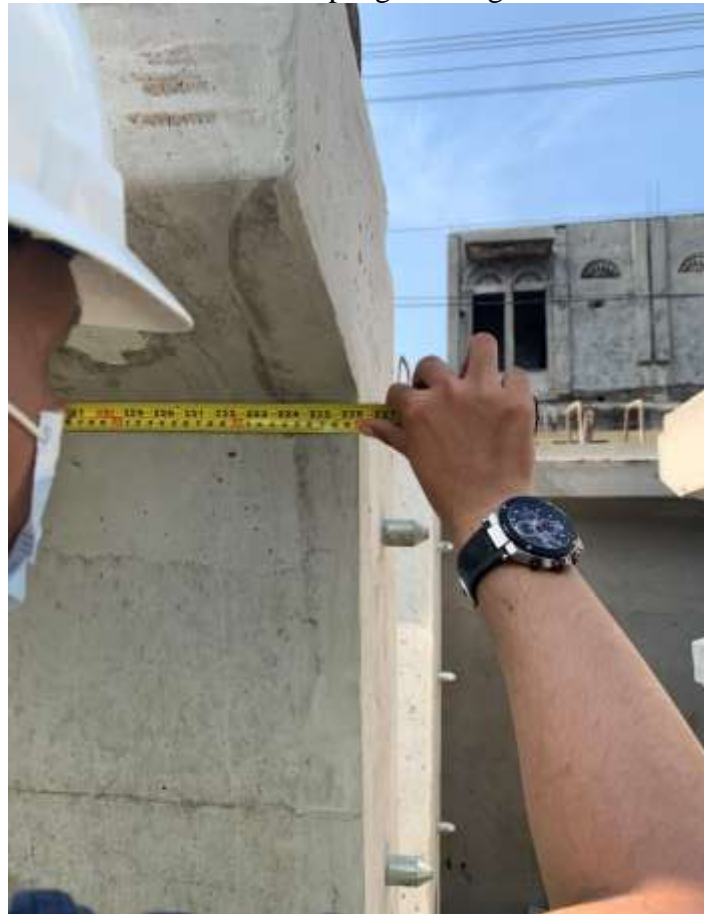
Gambar 2. 40. Pengecekan Ukuran Girder
