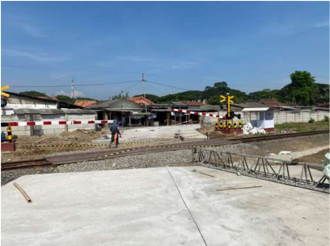
Gambar 3. 2. Pembangunan Detouring dan Perkuatan Rel
