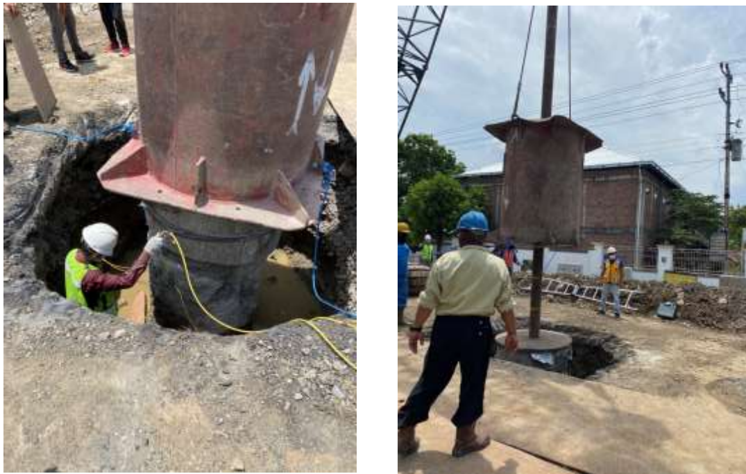
Gambar 2. 10. Pemasangan Sensor dan Pengetesan PDA
