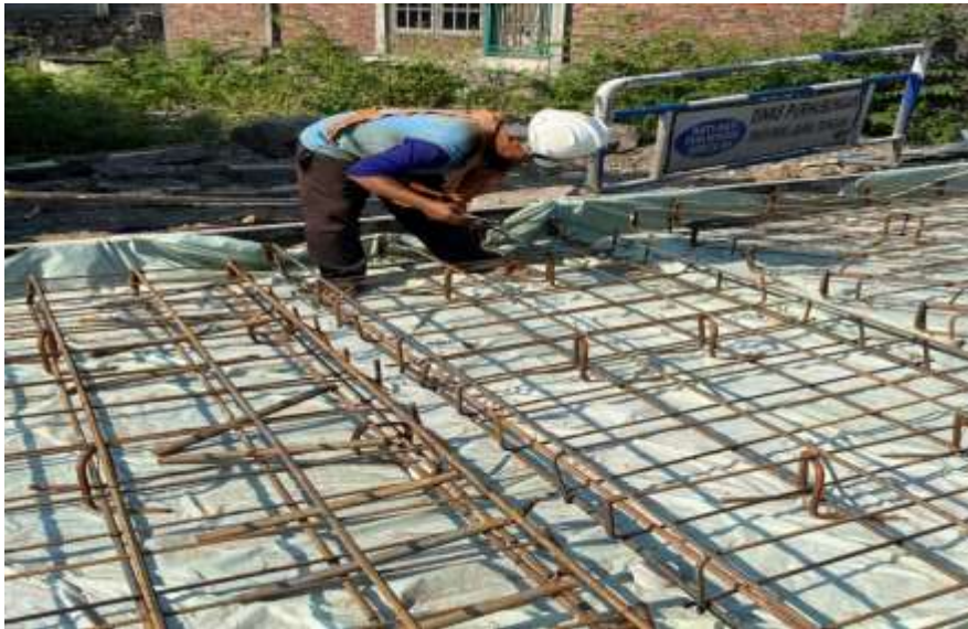
Gambar 2. 4. Pelaksanaan Pemasangan Tulangan Perkerasan Beton
